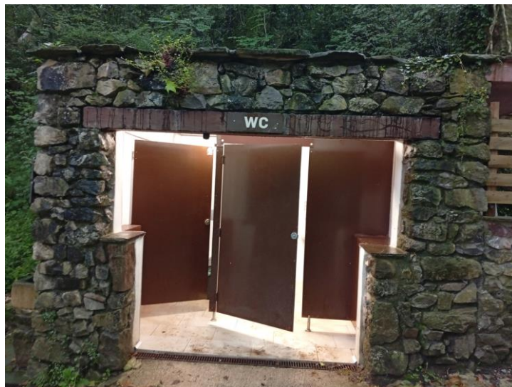
Ilustración 7. Entorno e interior del aseo
