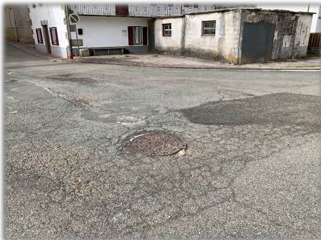
FOTOGRAFÍA 1: ESTADO ACTUAL DE LA CALLE
