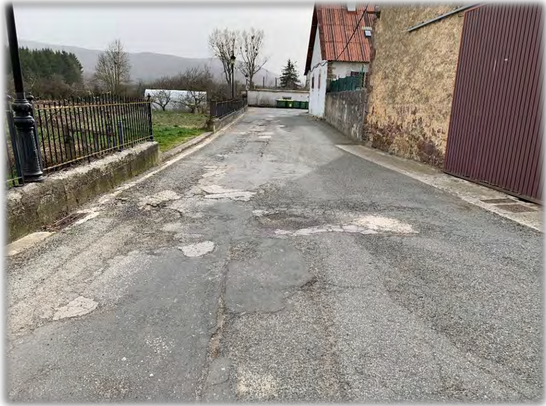
FOTOGRAFÍA 5: ESTADO ACTUAL DE LA CALLE
