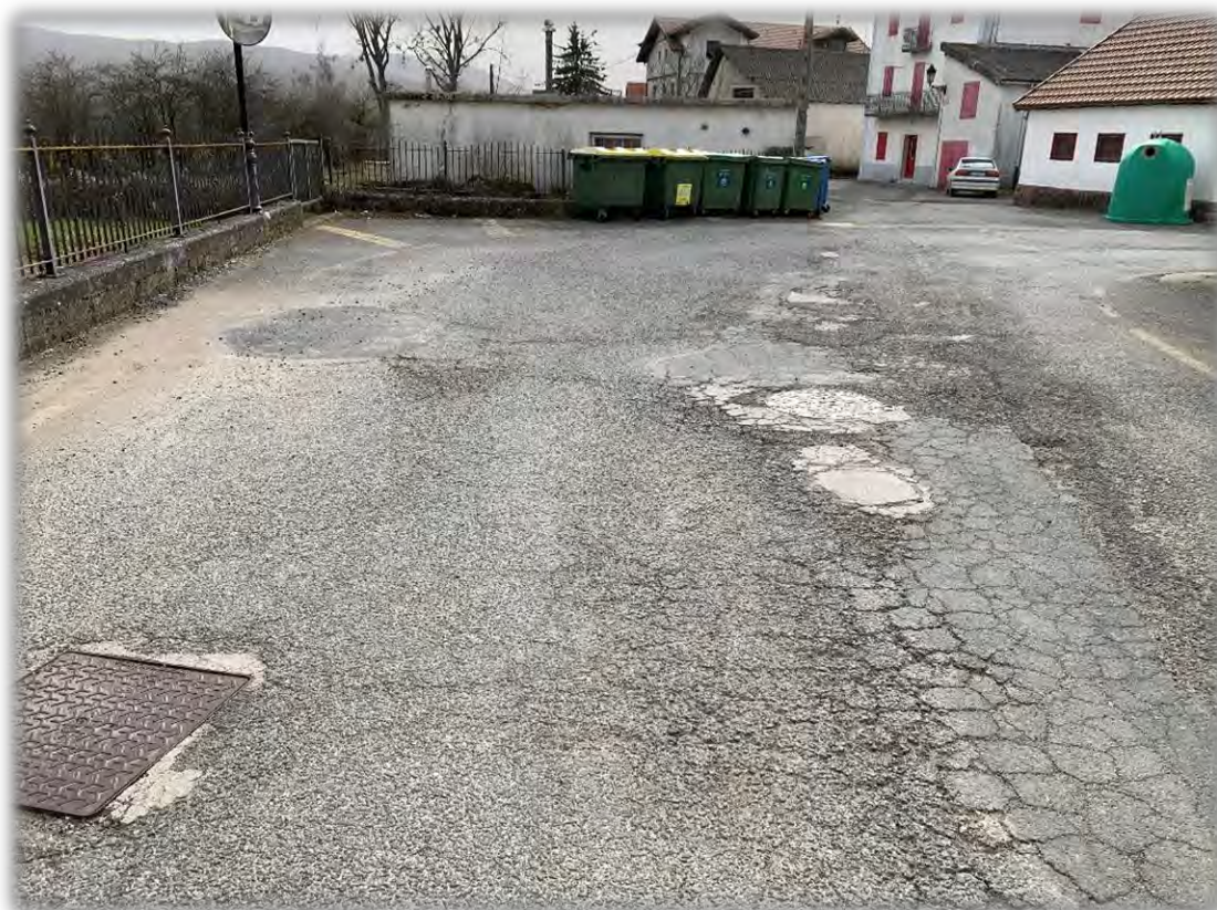
FOTOGRAFÍA 7: ESTADO ACTUAL DE LA CALLE
