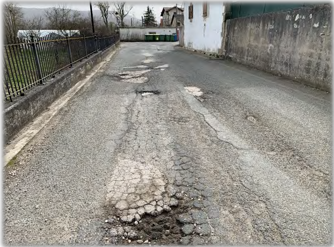
FOTOGRAFÍA 6: ESTADO ACTUAL DE LA CALLE
