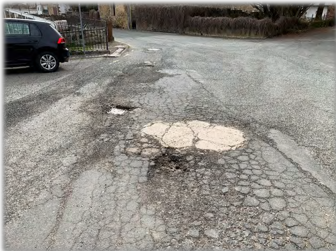
FOTOGRAFÍA 3: ESTADO ACTUAL DE LA CALLE
