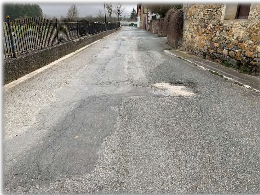
FOTOGRAFÍA 4: ESTADO ACTUAL DE LA CALLE
