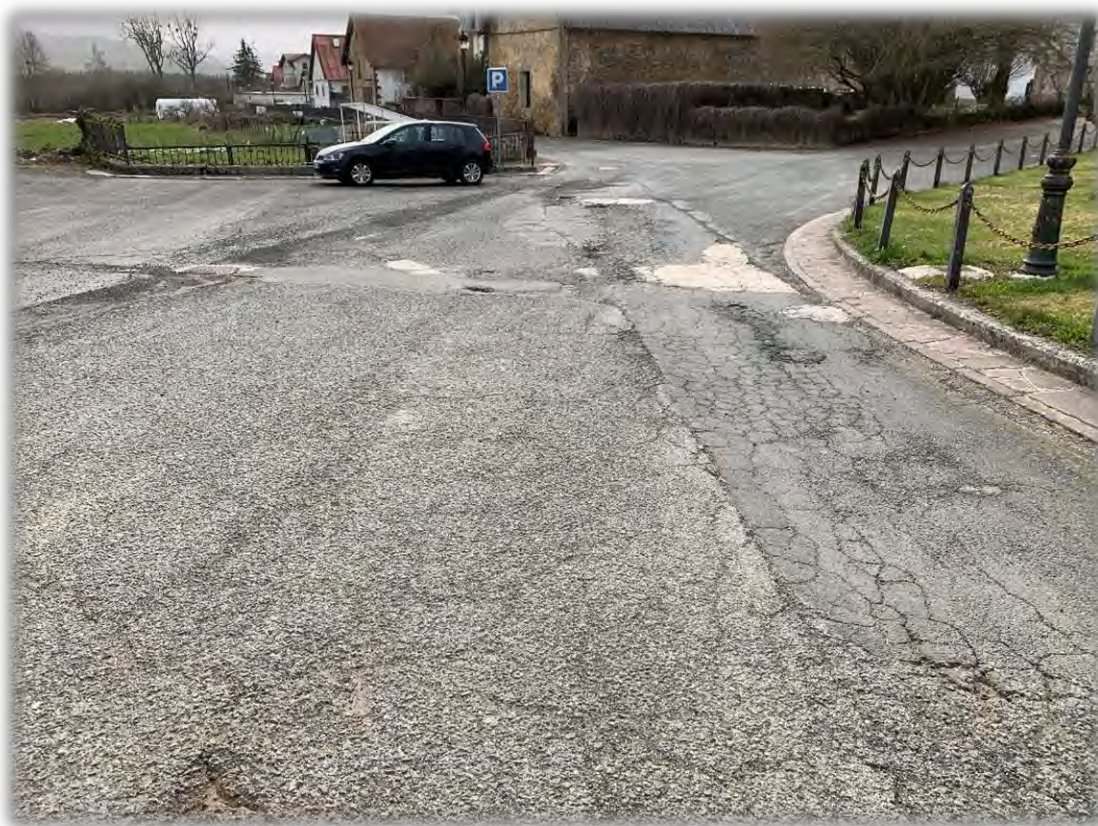
FOTOGRAFÍA 2: ESTADO ACTUAL DE LA CALLE
