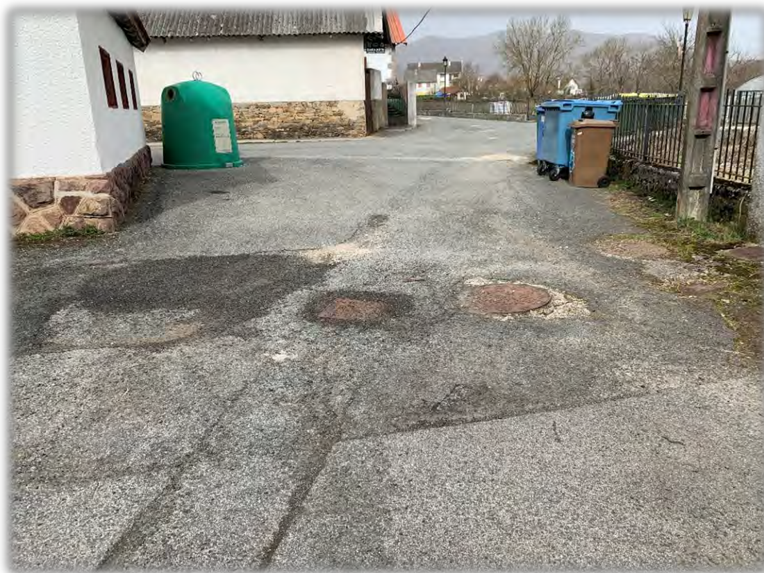
FOTOGRAFÍA 8: ESTADO ACTUAL DE LA CALLE
