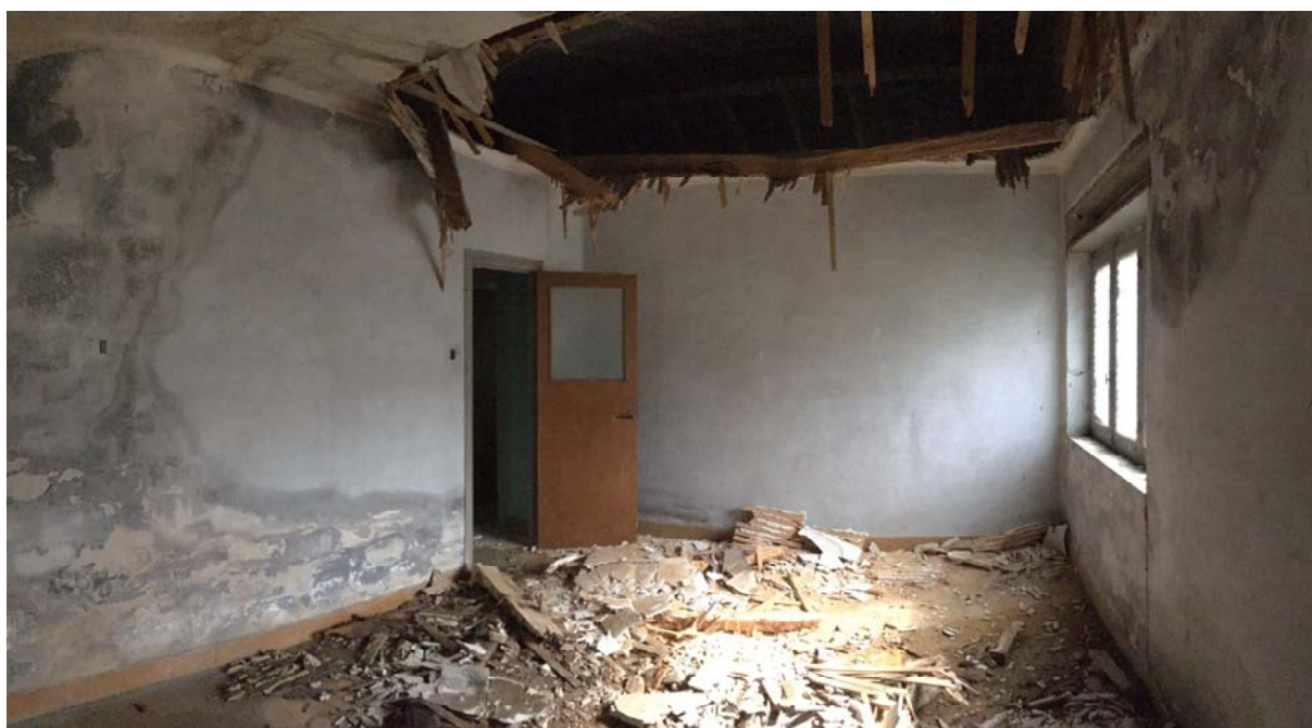
06. Estado de la Planta Bajocubierta
