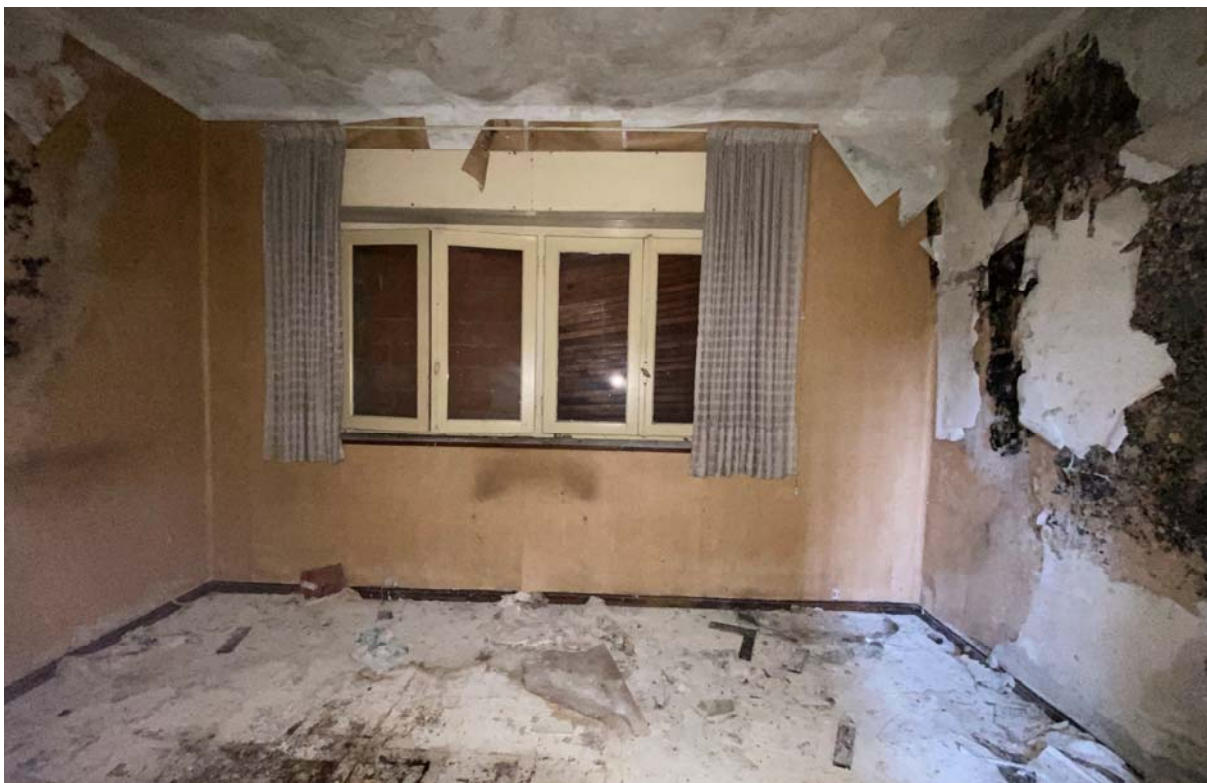
04. Estado de la Planta Baja
