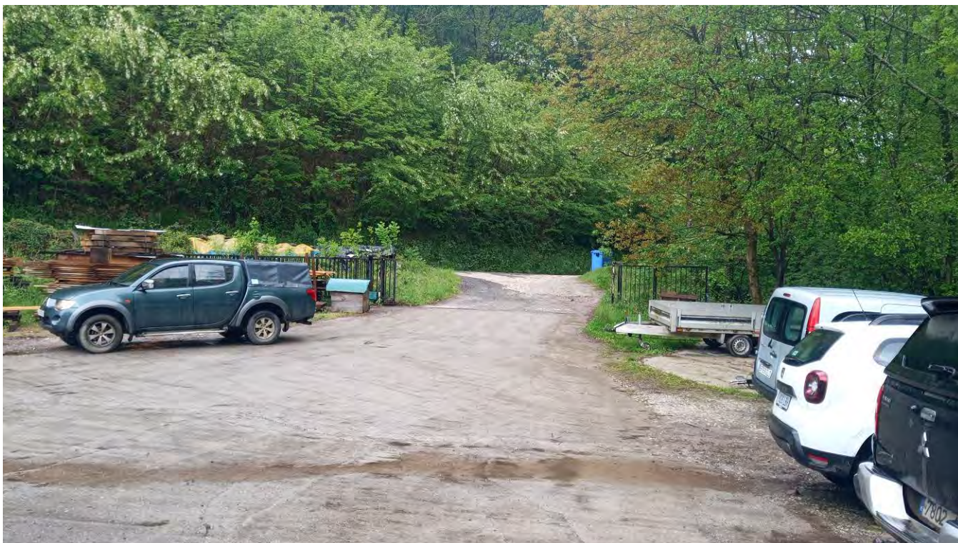
Vista acceso actual afectado por las obras de la margen izquierda
