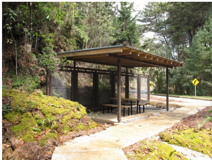
Pérgola con aparcabici, mesa y bancos
