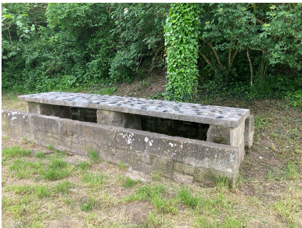
Estado actual de las mesas circulares y rectangular existentes
