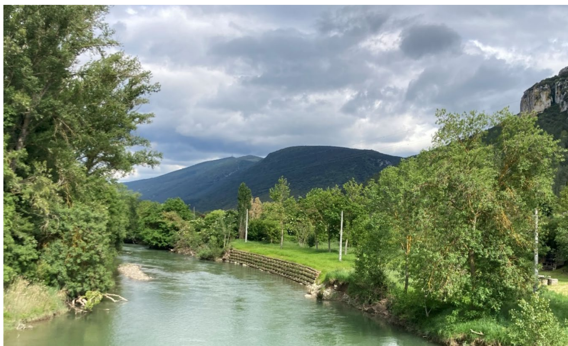
Aspecto actual del muro krainer instalado en 2024, en la zona de mayor erosión de la orilla de la zona de actuación
