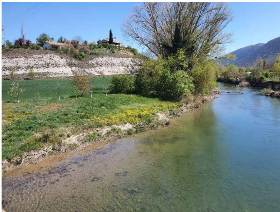
Aspecto de la margen derecha de la zona de estudio
