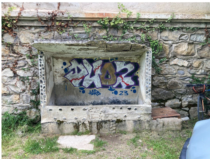
Estado actual de la fuente existente
