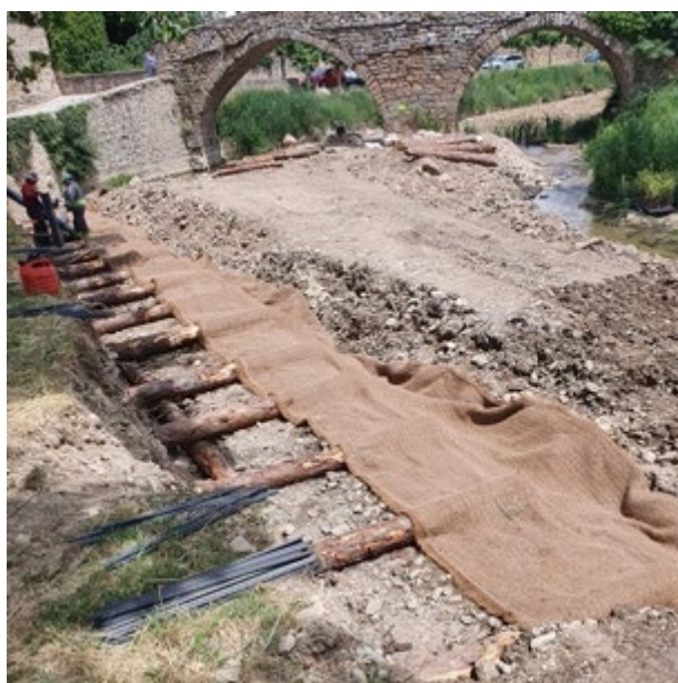
Entramado vivo en fase de instalación
