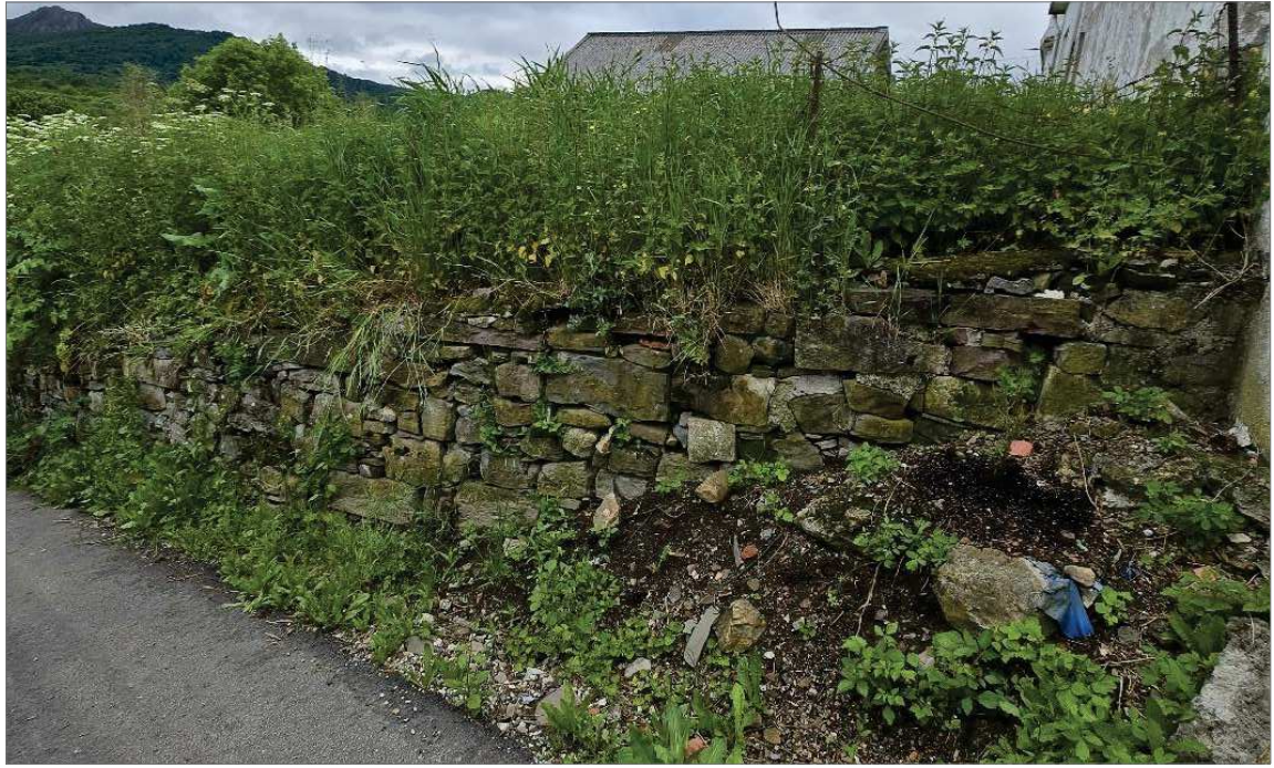
2. VISTA DE LIENZO Nº 6 EN SU EXTREMO SUR
