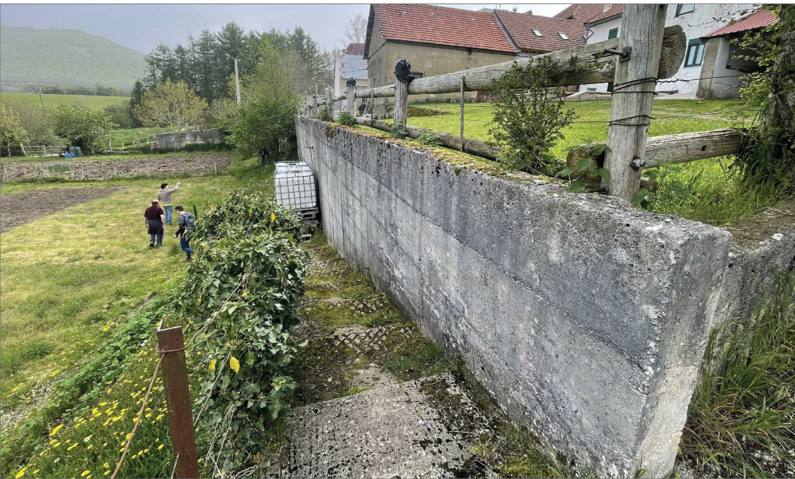
2. VISTA DE LIENZO Nº 2 DESDE FINAL DE RAMPA ESCALONADA
