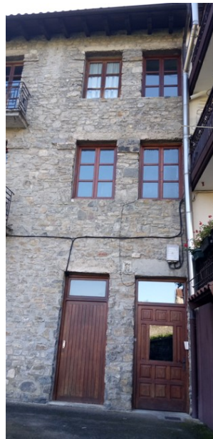
Fachada noreste. Puertas portal. Cambio de sentido de apertura
