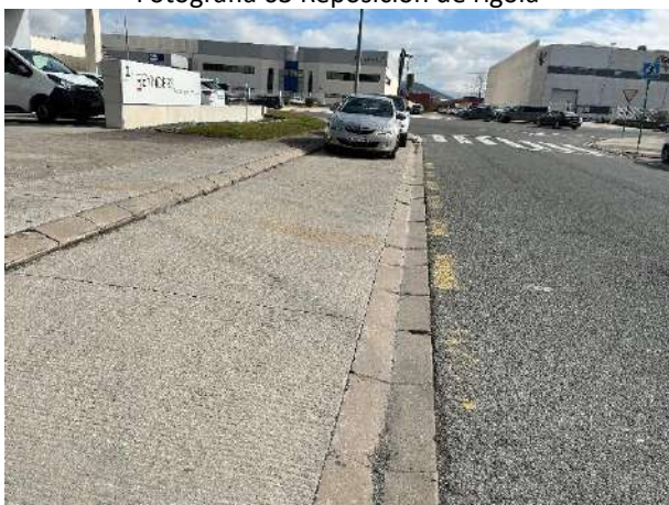
Fotografía 65 Caz deteriorado
