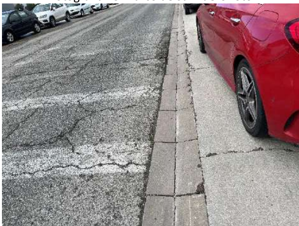
Fotografía 47 Caz deteriorado
