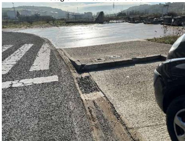
Fotografía 24 Reposición de bordillo
