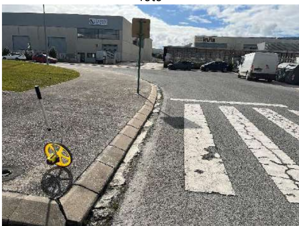
Fotografía 63 Reposición de rigola
