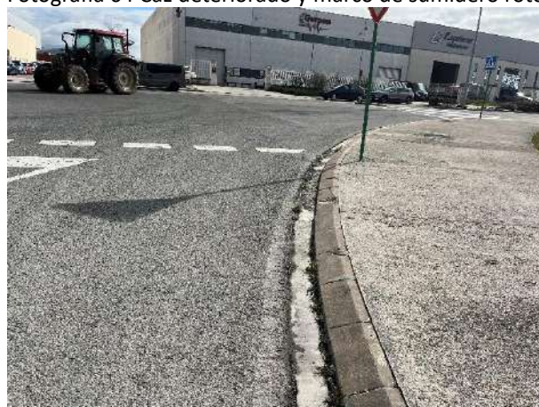
Fotografía 66 Reposición de rigola
