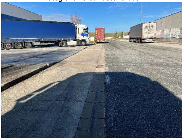
Fotografía 27 Caz deteriorado
