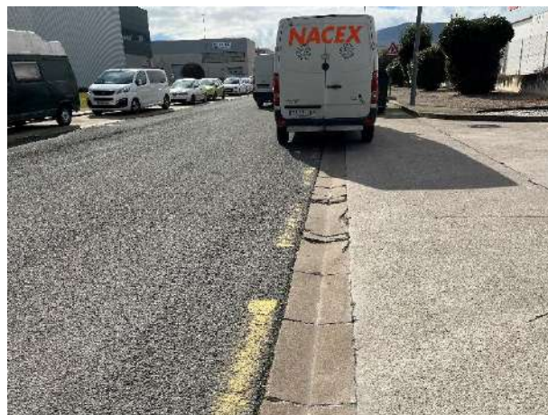
Fotografía 62 Caz deteriorado
