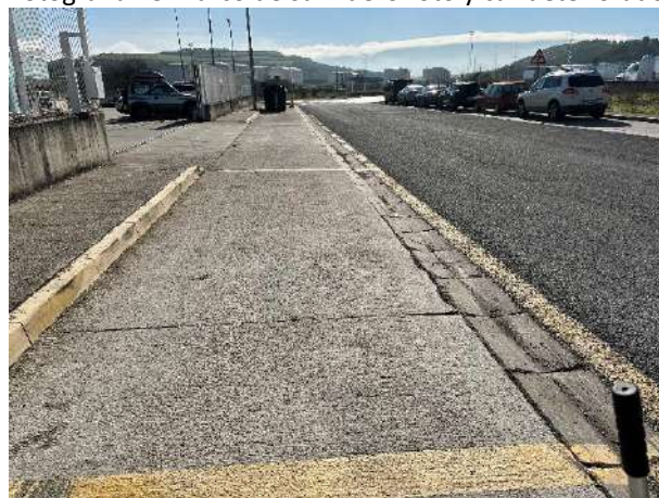
Fotografía 30 Caz deteriorado
