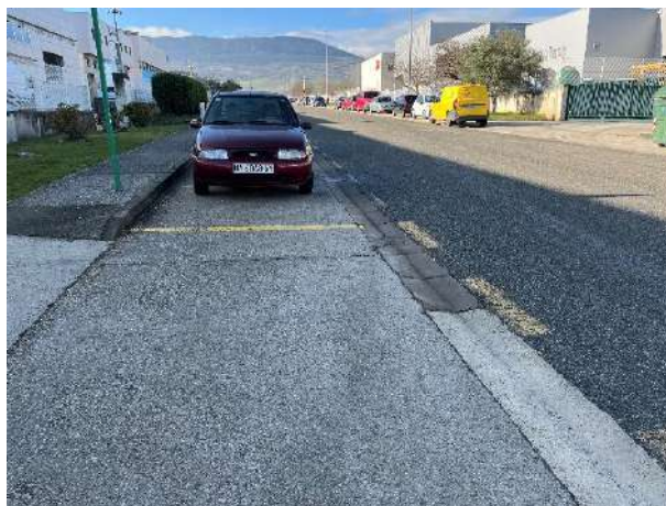
Fotografía 20 Caz deteriorado
