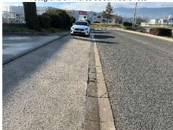
Fotografía 16 Caz deteriorado
