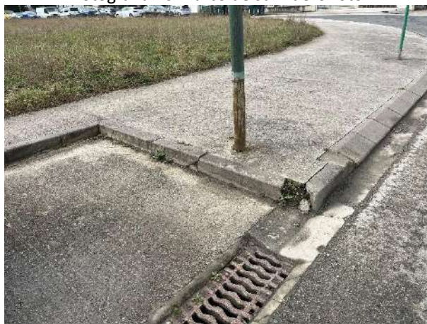
Fotografía 48 Reposición de bordillo
