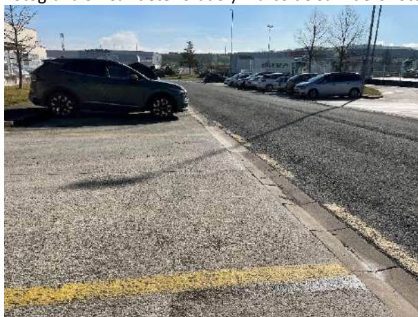
Fotografía 36 Caz deteriorado
