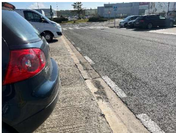
Fotografía 38 Caz deteriorado
