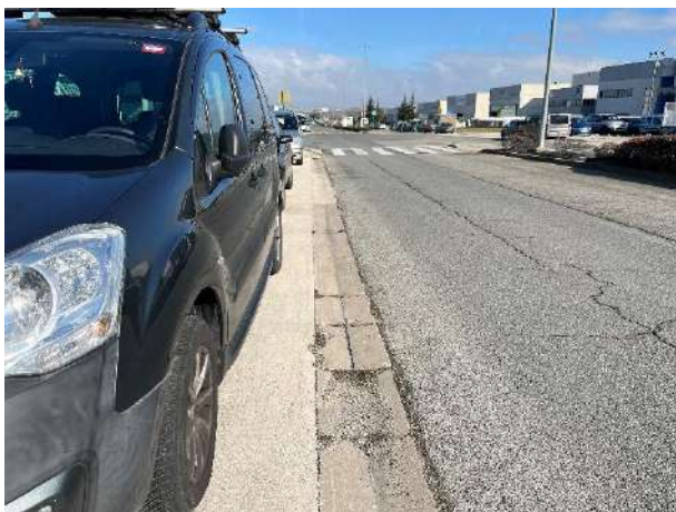
Fotografía 43 Caz deteriorado
