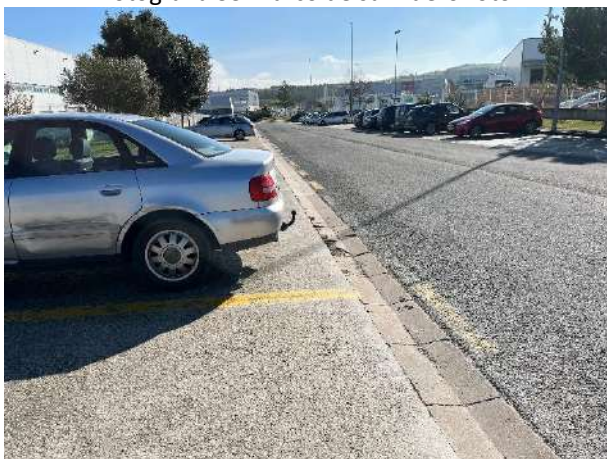
Fotografía 35 Caz deteriorado
