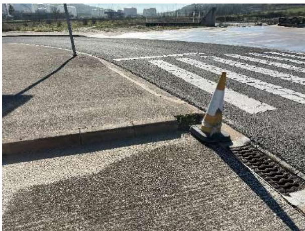
Fotografía 31 Reposición de bordillo
