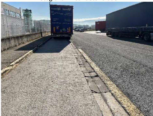
Fotografía 29 Caz deteriorado
