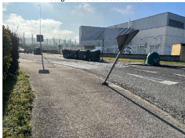
Fotografía 18 Reposición de señalización
