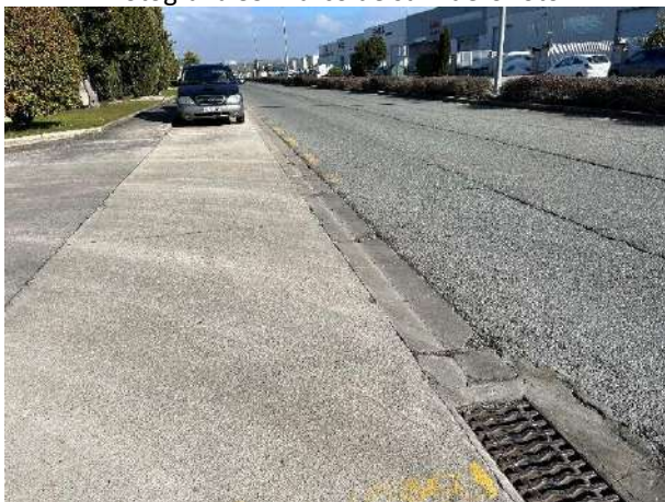
Fotografía 41 Caz deteriorado
