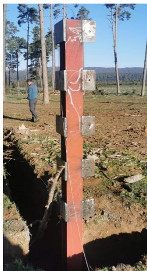
Imagen nº9: Colocación de pletinas en los perfiles HEB para la colocación de los travesaños.
