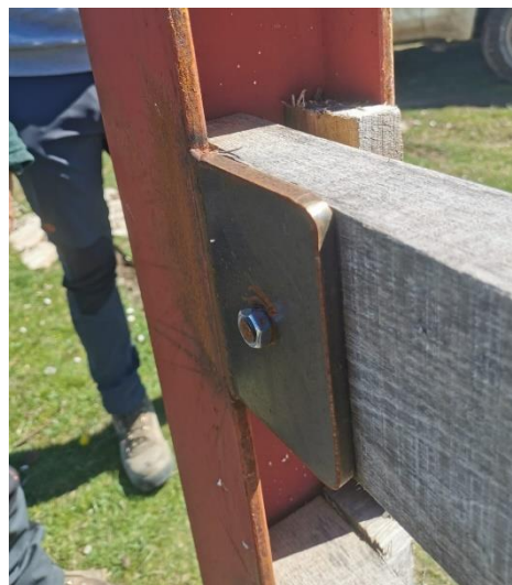
Imagen nº9: Colocación de pletinas en los perfiles HEB para la colocación de los travesaños.
