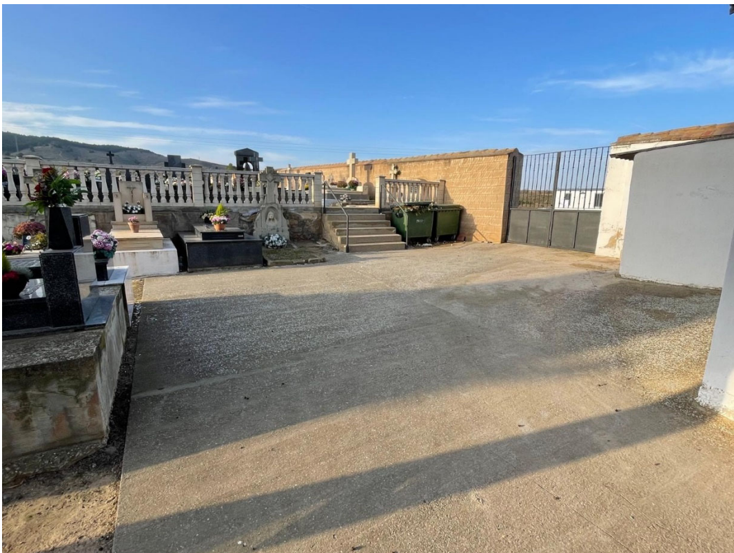
Zona de actuación rampa acceso interior.
