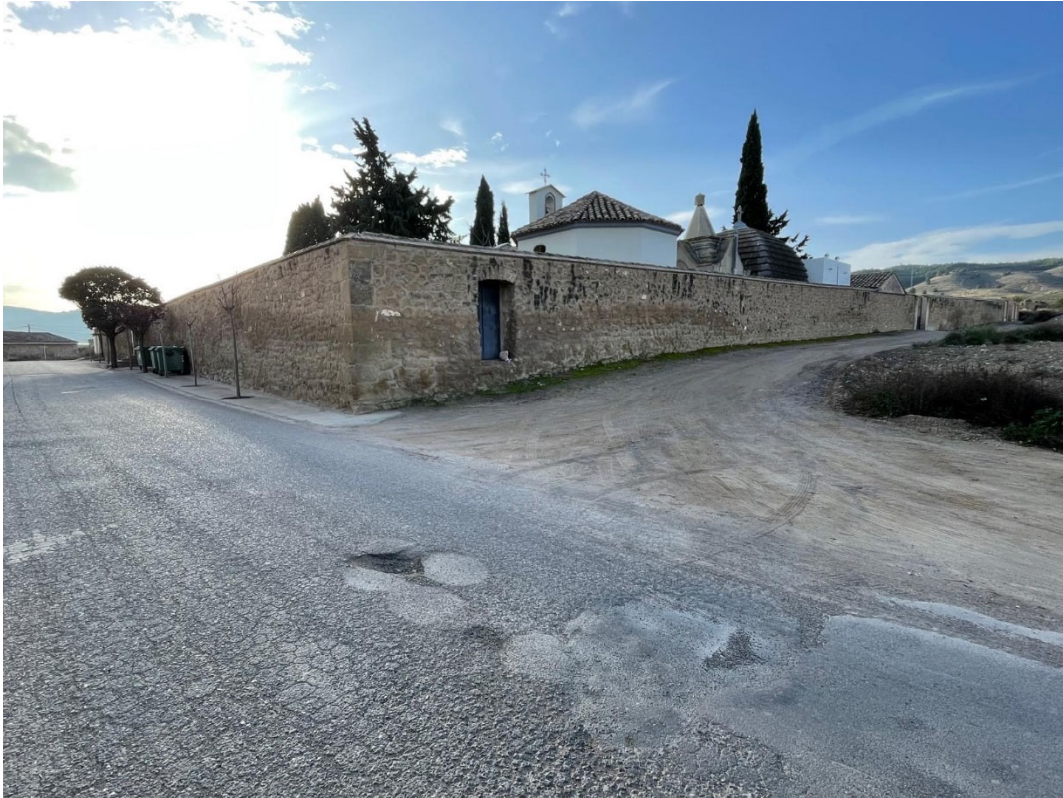
Camino Acceso Secundario
