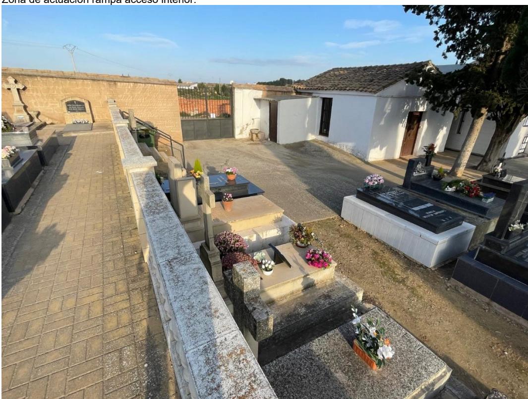
Zona de actuación rampa acceso interior.
