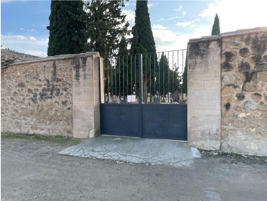
Puerta acceso Secundario
