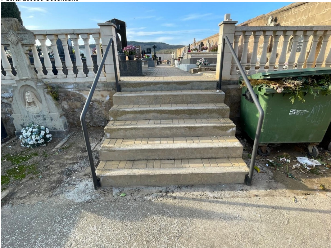
Escaleras entre plataformas interiores de cementerio.
