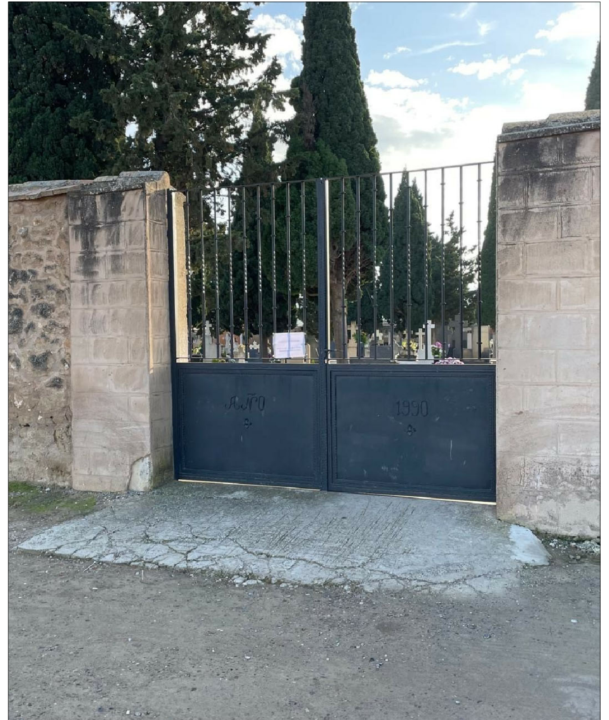
ESTADO ACTUAL PUERTA DE ACCESO
