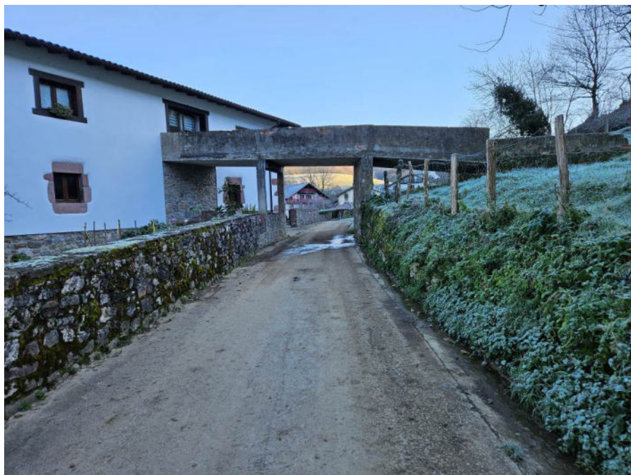
Fotografía del estado actual del camino con el puente de acceso al desván de la vivienda Lapitxea
