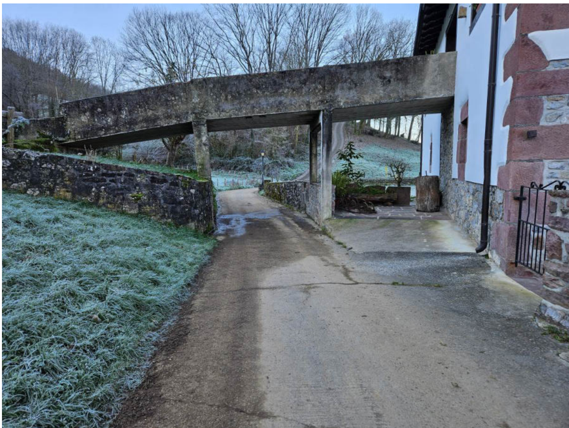
Otra fotografía del estado actual del camino con el puente de acceso al desván de la vivienda Lapitxea. Altura máxima de galibo 3,20 m.
