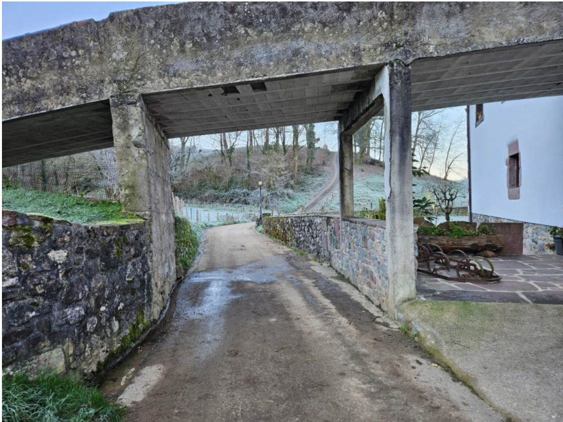
Fotografía del estado actual del camino con el puente de acceso al desván de la vivienda Lapitxea. Altura máxima de galibo 3,20 m.
