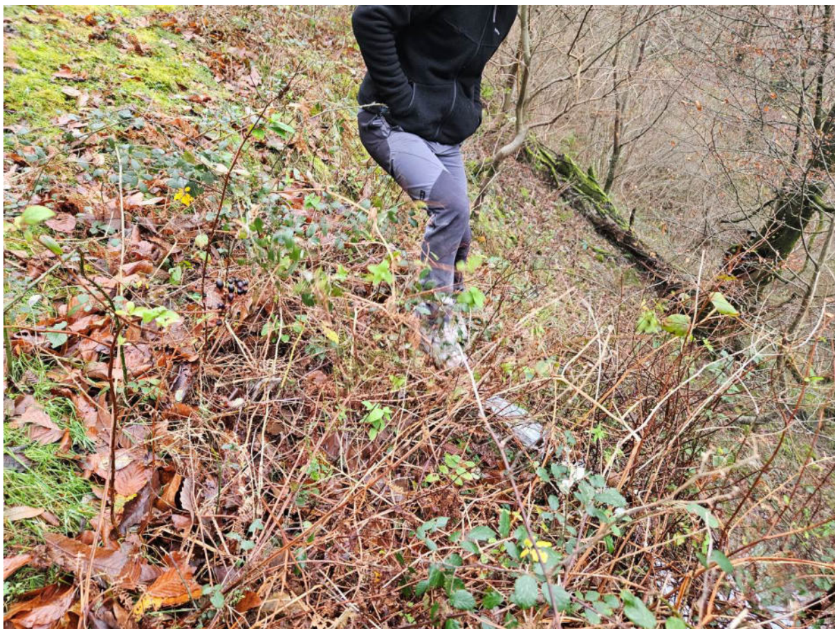
Fotografía del estado actual del camino Beltxenea donde en el terraplen se aprecia la abundancia de aguas subterráneas que manan de una tubería de drenaje.
