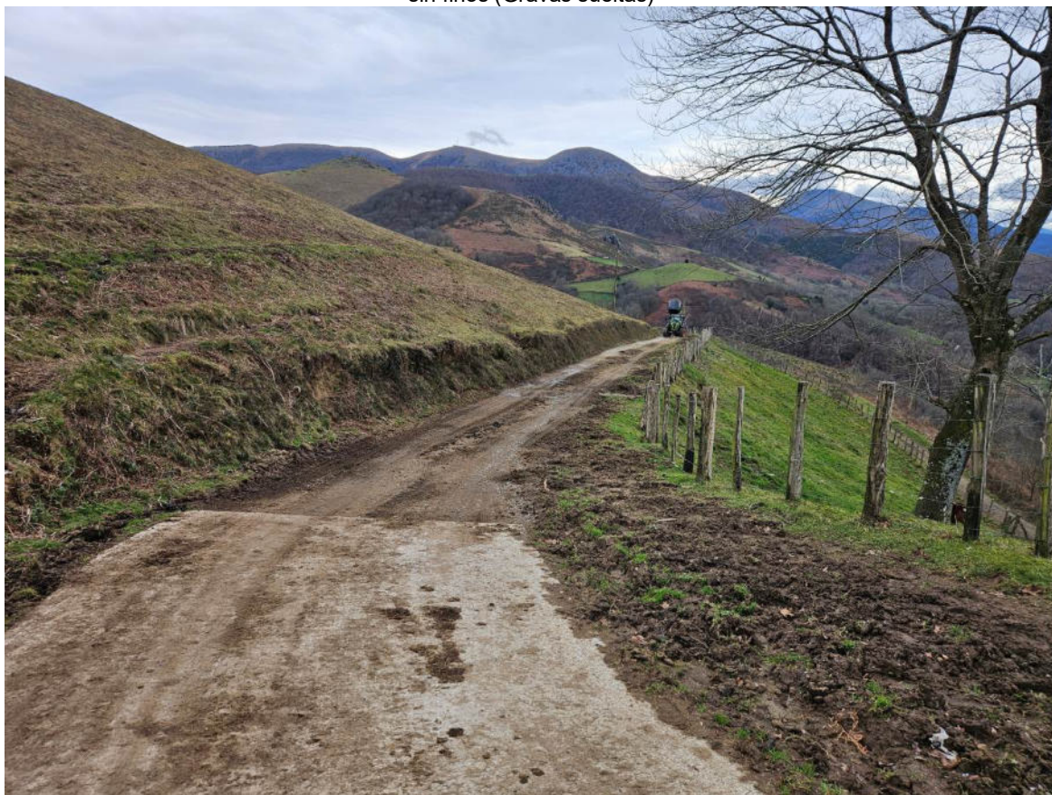
Fotografía del estado actual del camino Komaineko Borda (Parte central junto a un corral) con apenas zahorras artificiales y sin finos (Gravas sueltas)
