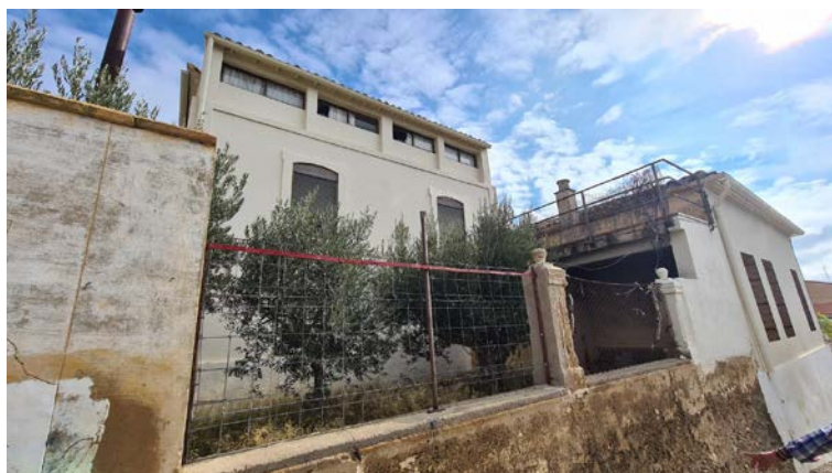
Imágenes estado actual fachadas Norte y Sur.
