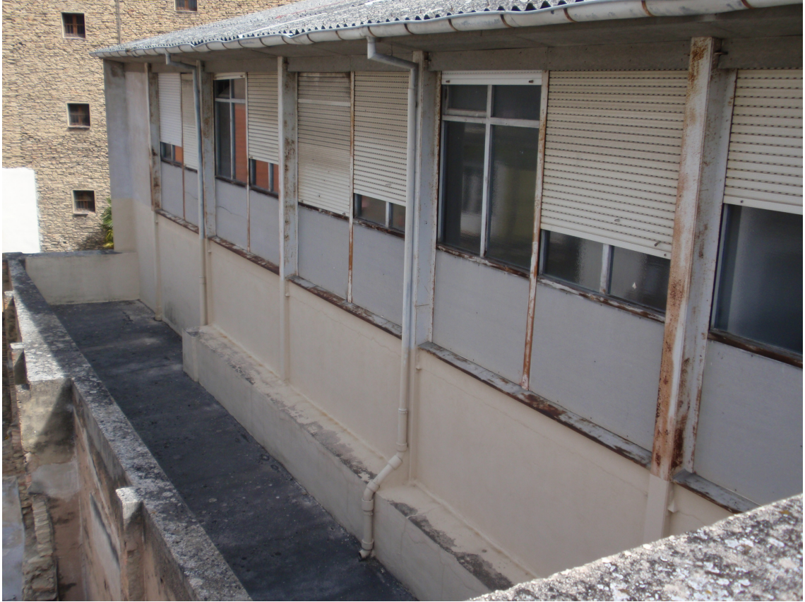
Detalle fachada hacia traseras Calle del Carmen. Placas de fibrocemento a desmontar en cubierta y fachada
