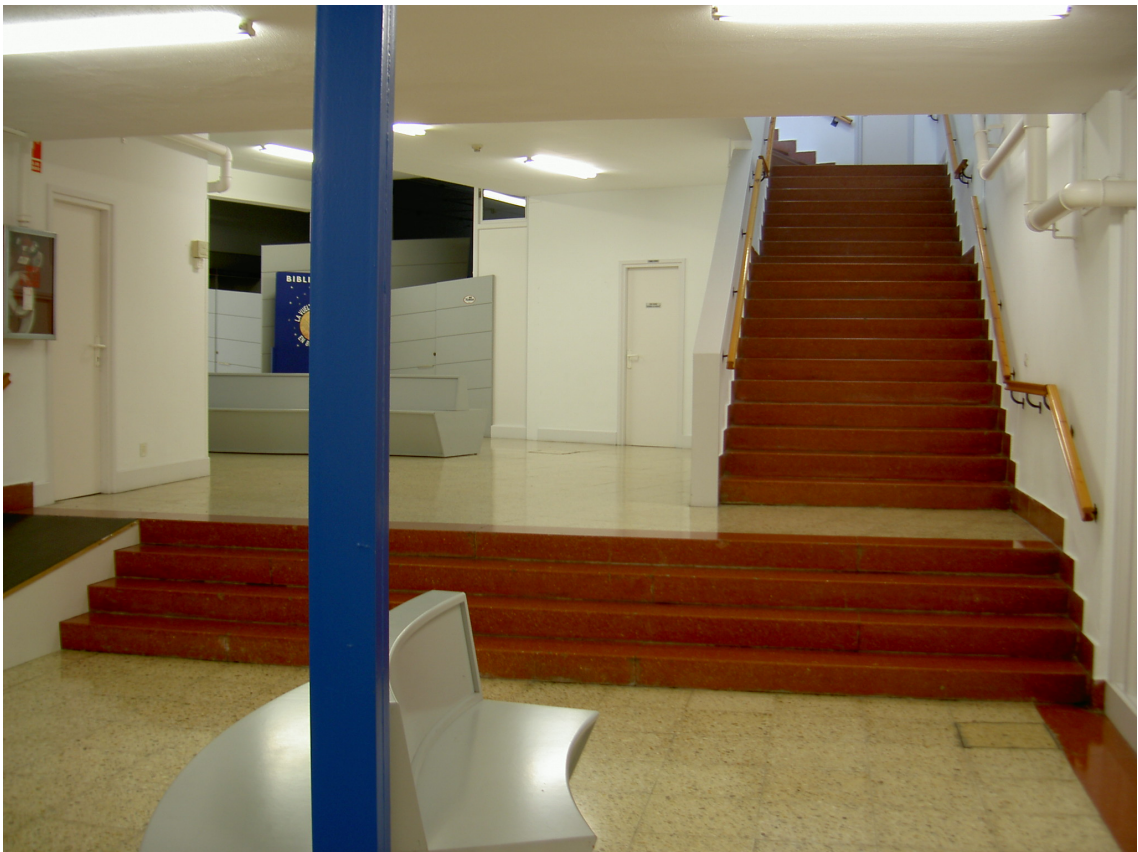
Escalera de acceso planta superior
