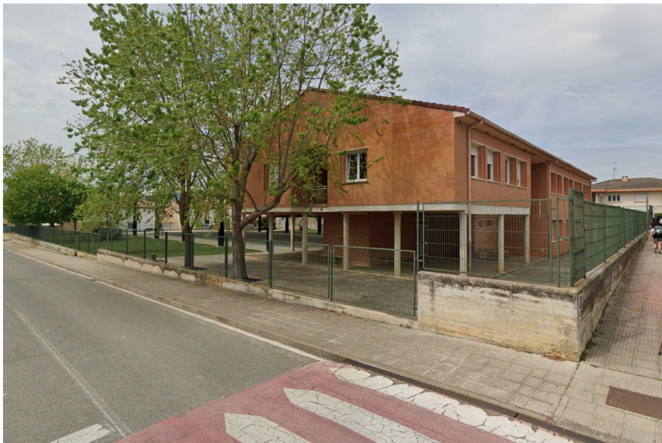
Foto de estado actual del edificio y la zona de la ampliación.
