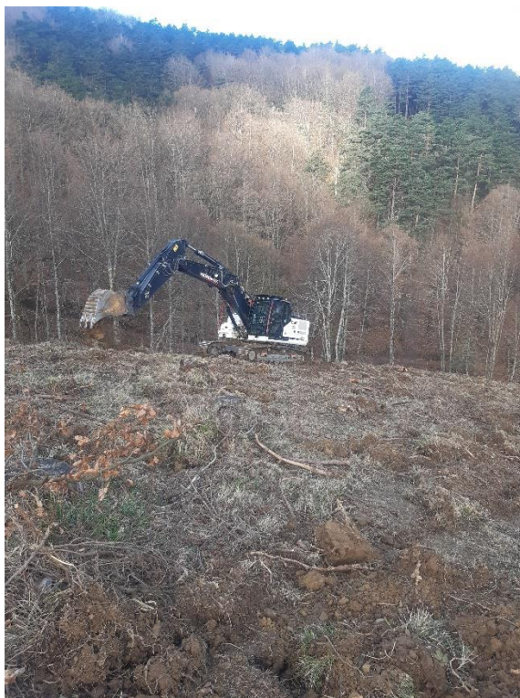
Ahoyado mecanizado con retroexcavadora
