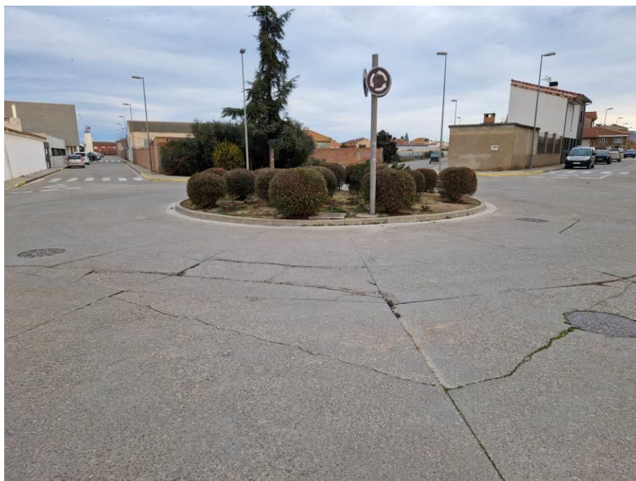
Detalle fisuraciones
