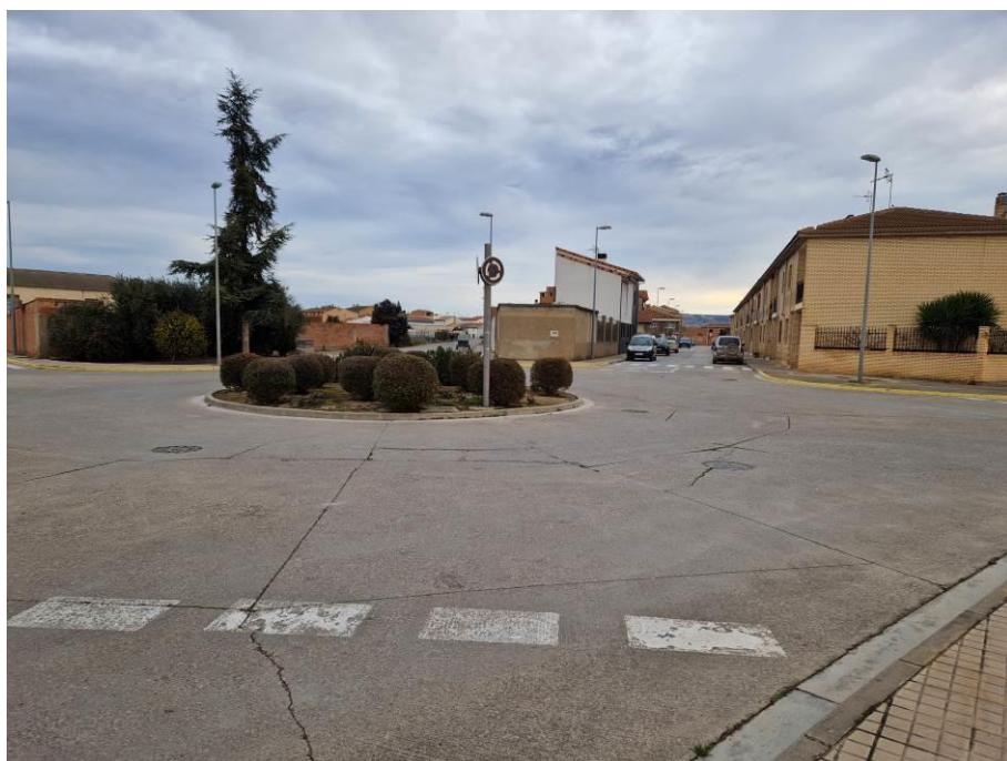
Cuadrante objeto de reparación
