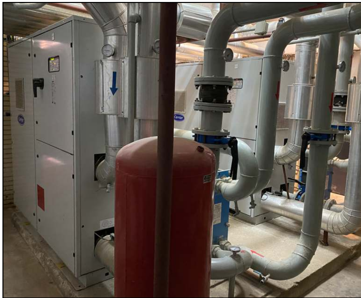
Imagen. Enfriadoras agua-agua para refrigeración.
