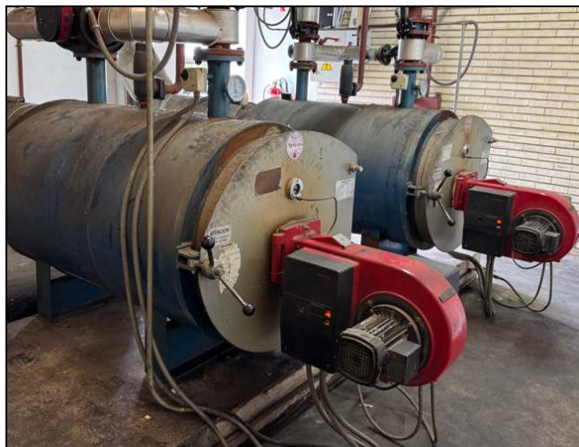
Imagen. Calderas de gasóleo para calefacción.
