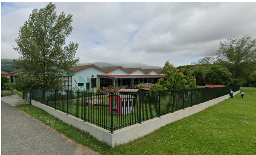
Fachada sur, porche cubierto y espacio exterior de juegos.
