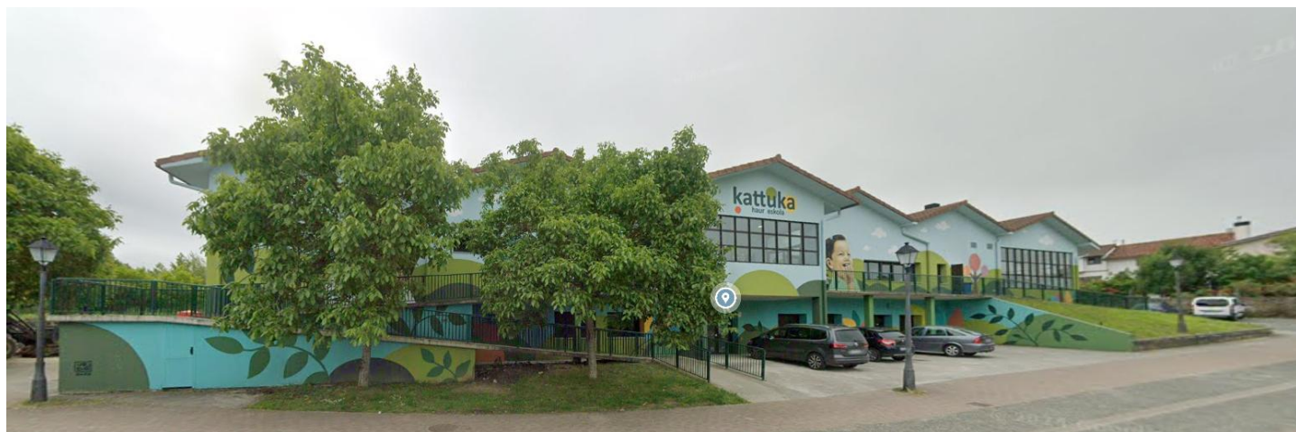
Fachada norte-acceso, semisótano + planta baja.
