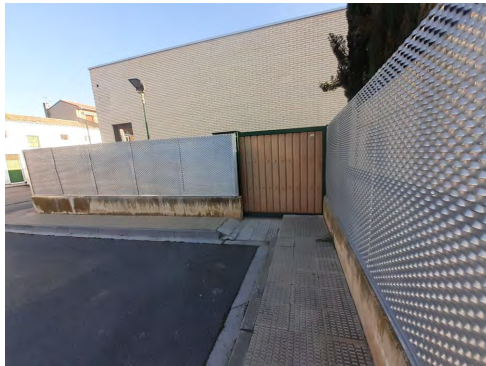
- Foto 5: Zona acera, cerramiento existente y entrada/acceso a colegio "Virgen del Soto" desde Avenida Pamplona
