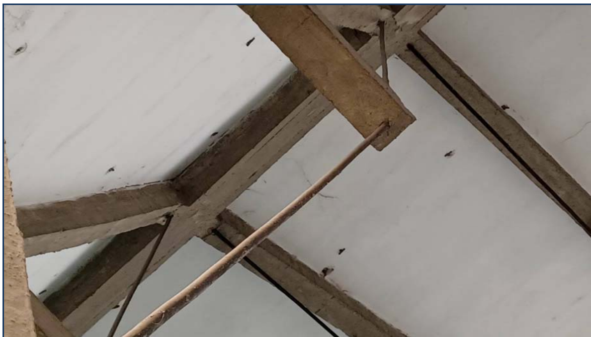
Detalle de Viga cenital. En primer plano, tensor metálico de cercha.
