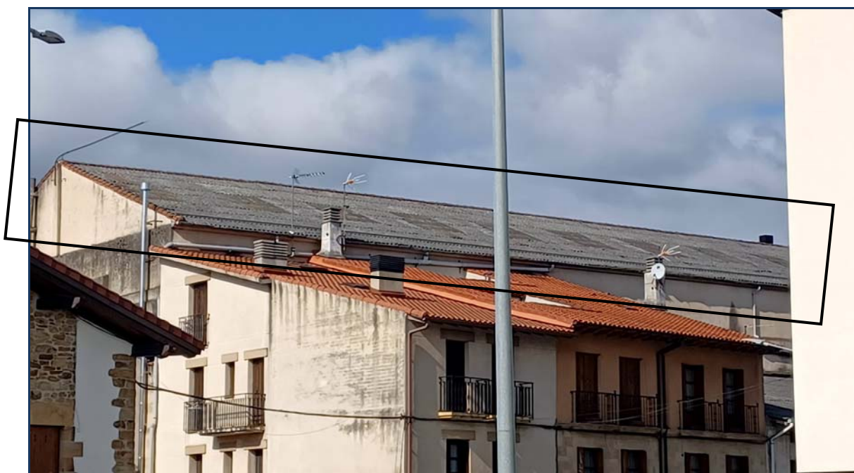
Faldón de Cubierta Vertiente Este.
