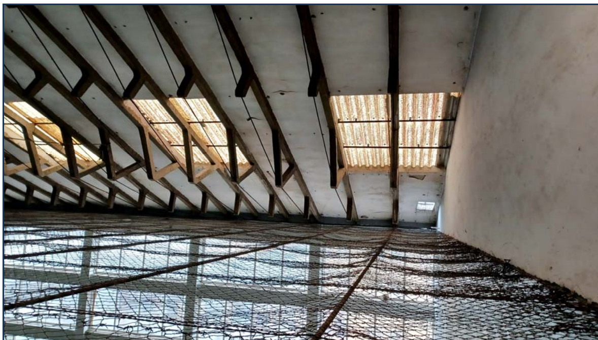
Detalle de cerchas de hormigón con tirantes metálicos. En primer plano, malla metálica protectora bajo cerchas. A la derecha, pared trasera (Norte). Al fondo abajo, fachada Oeste con lucernarios verticales a calle Larreñeta.
