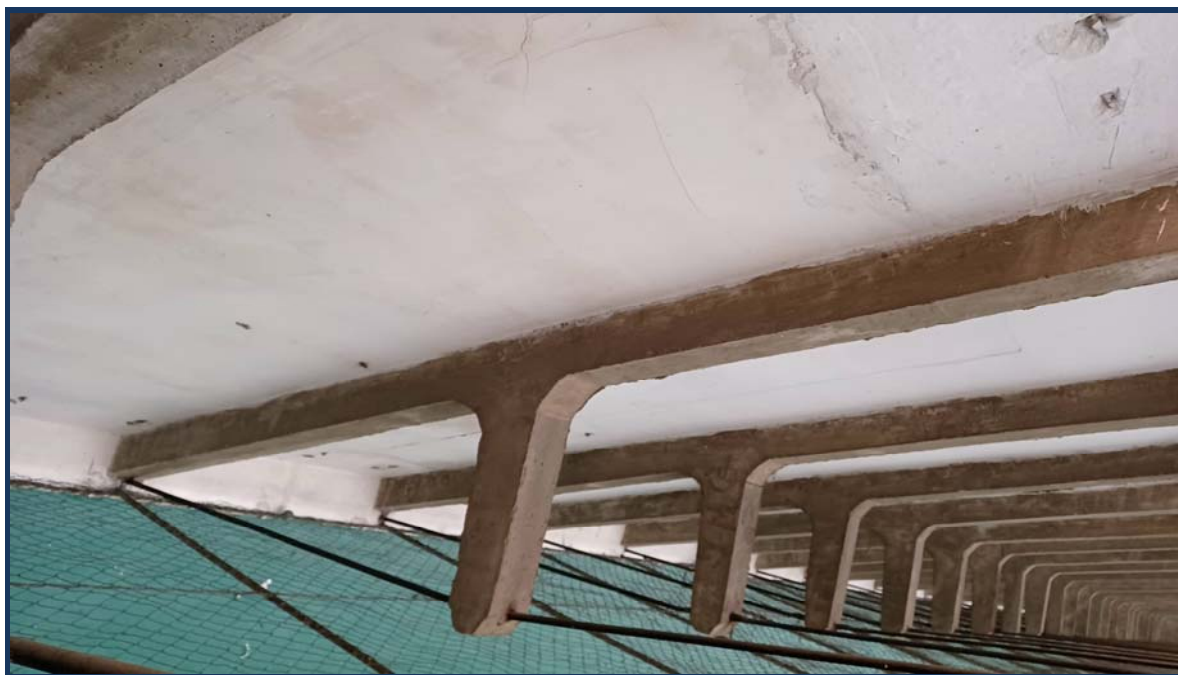
Detalle anclaje cerchas a muro portante (pared izquierda de frontón). En primer plano, malla metálica protectora bajo cerchas y tirante metálico de cerchas.
