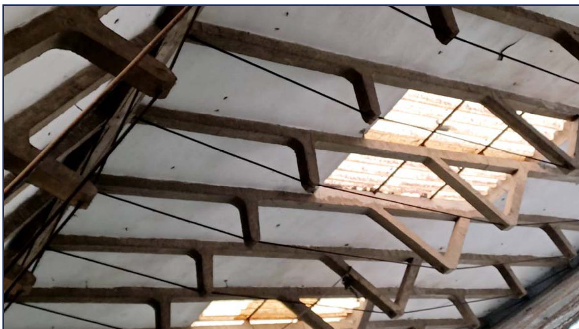
Detalle de cerchas y tablero de hormigón.
