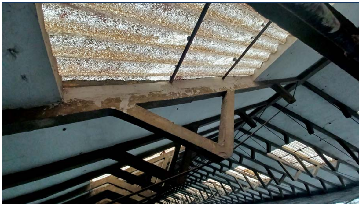
Detalle de cerchas, tablero de hormigón y lucernario.
