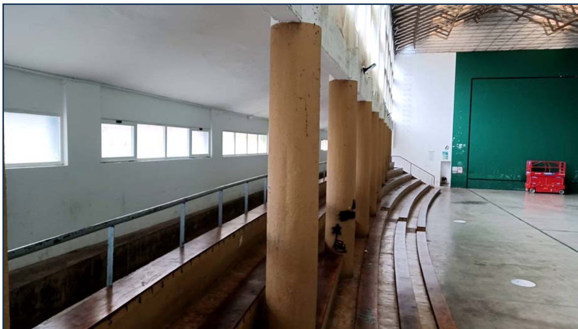
Graderío. Fachada Oeste a calle Larreñeta.
