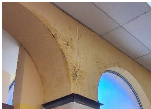
Presencia de humedades y grietas por asentamientos
