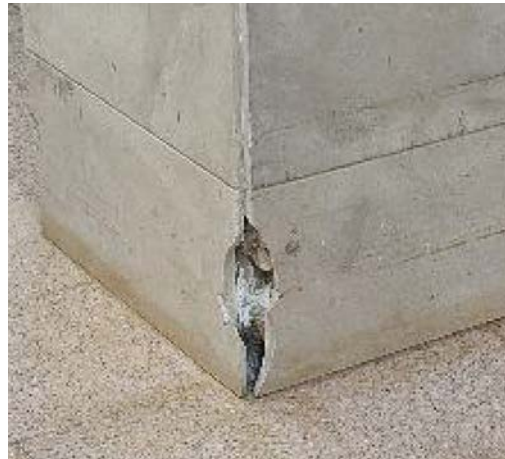
Presencia de remates de chapa y esquinas en mal estado.
