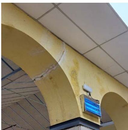
Presencia de humedades y grietas por asentamientos
