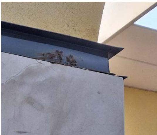
Presencia de remates de chapa y esquinas en mal estado.
