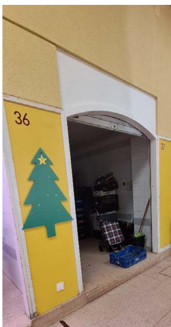
Estado actual del 37 en el que se instalara la nueva conserjería.
