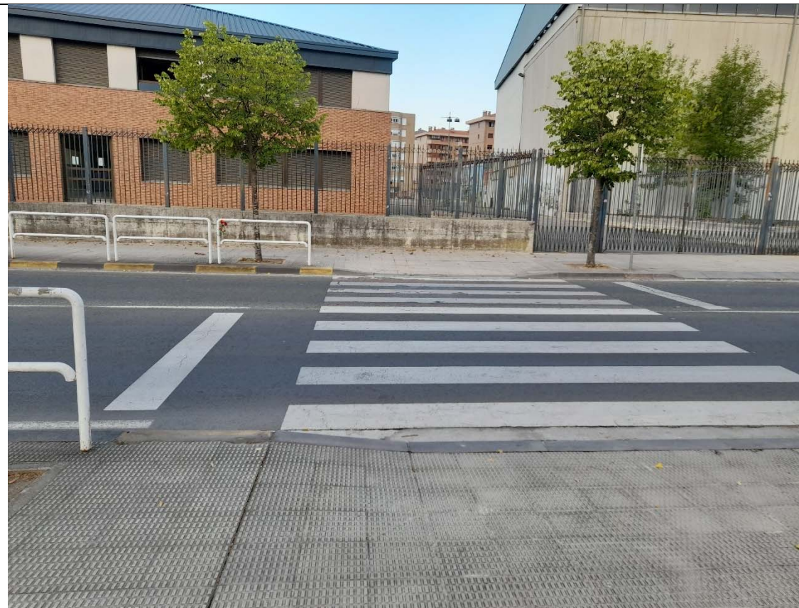
Fotografía 3: Paso de cebra que conecta con el Frontón y donde el eje pasa de la acera de la margen derecha a la de la margen izquierda.
