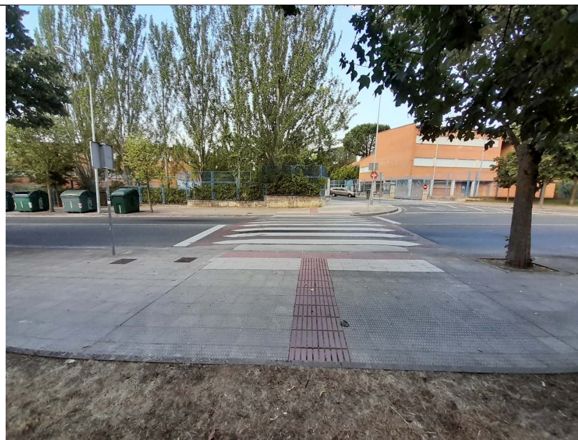
Fotografía 4: Paso de cebra previo a la intersección con Calle Ermita.
