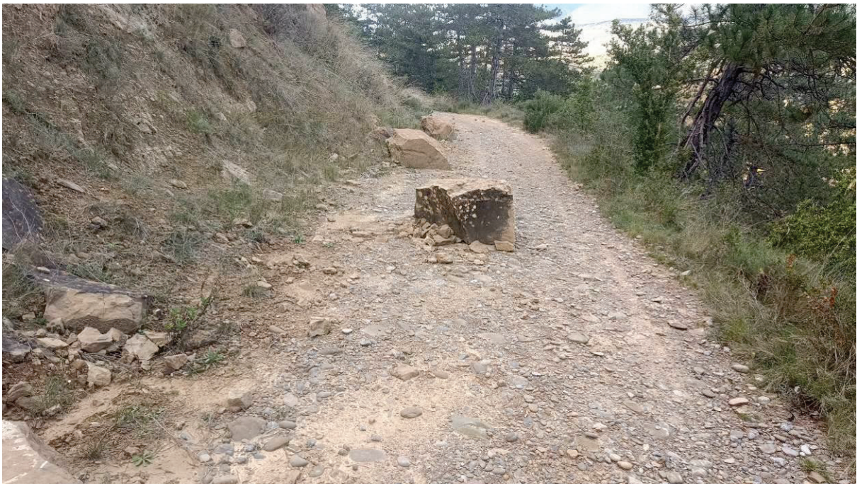
Foto 3: Derrumbes de rocas en la zona de Sangüesa
