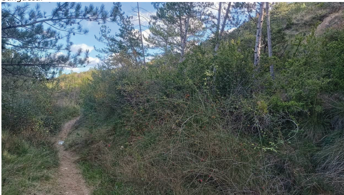
Foto 1: Zona del camino Urdina a ensanchar y eliminar derrumbes
