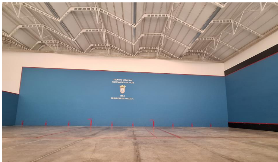
Vista del estado actual del frontón
