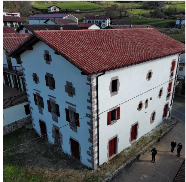
Fig 2.7 Fachadas noroeste y suroeste
