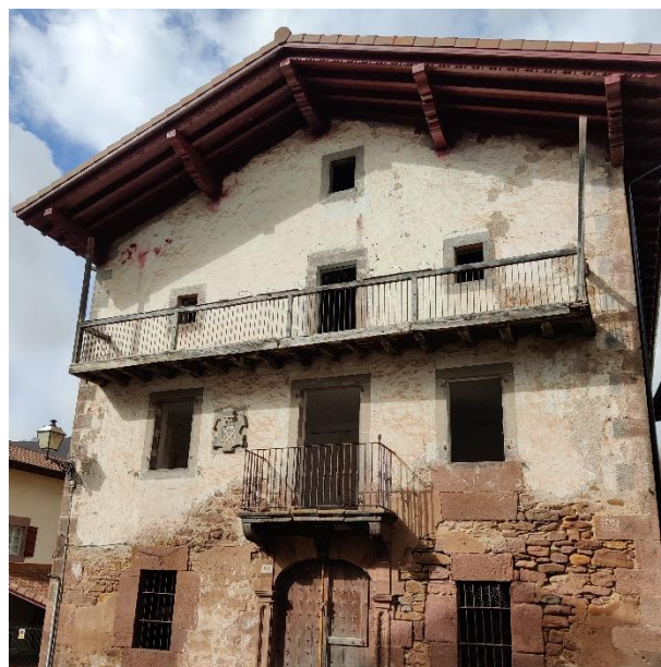
Fig 2.5 Fachada sureste con cubierta rehabilitada
