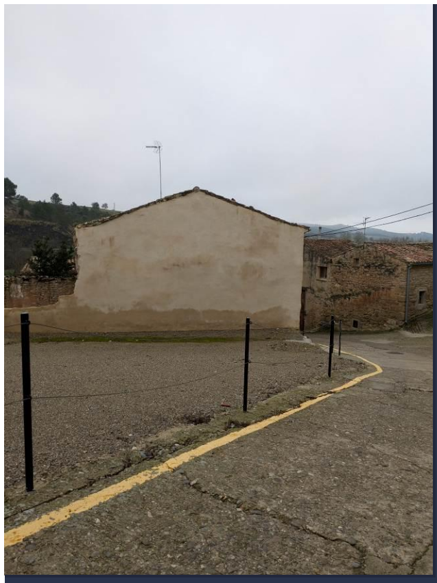
FOTOGRAFÍA 3: ESTADO INICIAL DE LA PLAZA DESDE PARTE SUPERIOR DE LA CALLE JESÚS ORDOÑEZ
