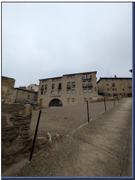
Imagen 1: Estado actual de la parcela
