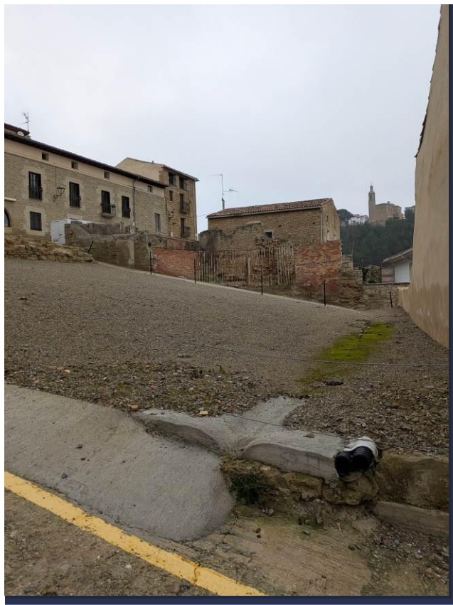
FOTOGRAFÍA 5: ESTADO INICIAL DE LA PLAZA DESDE PARTE INFERIOR DE LA CALLE JESÚS ORDOÑEZ
