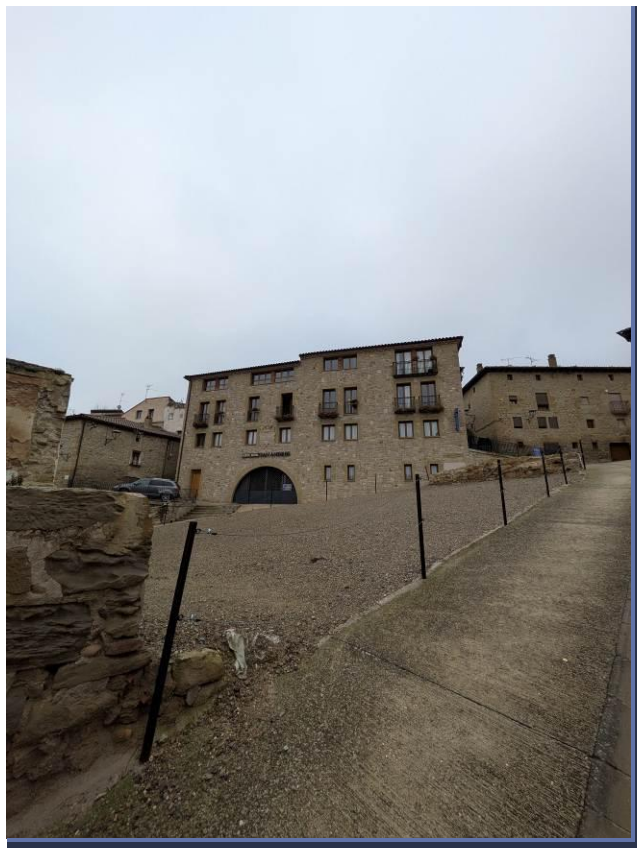
FOTOGRAFÍA 1: ESTADO INICIAL DE LA PLAZA DESDE PARTE INFERIOR DE LA CALLE ORIENTE
