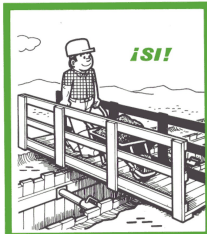
LAS ESCALERAS NO DEBEN UTILIZARSE COMO MONTANTES DE ANDAMIO, PISO DE TRABAJO O PASARELA.
