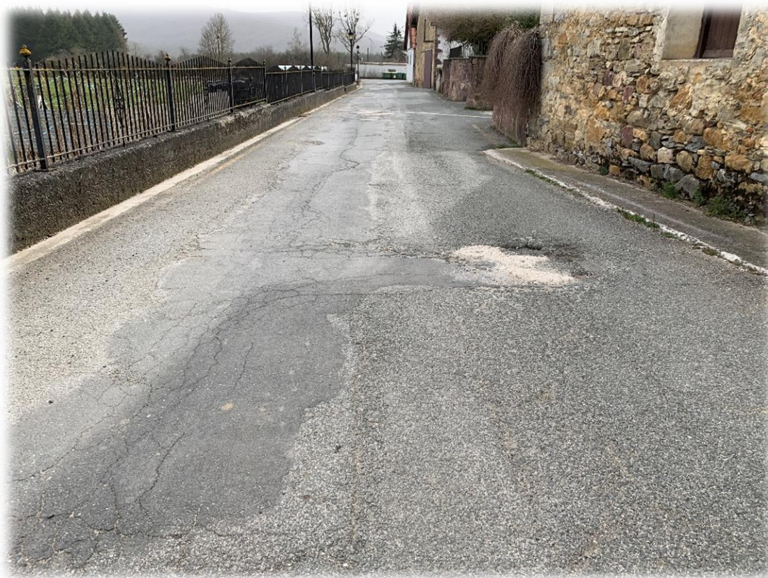
FOTOGRAFÍA 4: ESTADO ACTUAL DE LA CALLE
