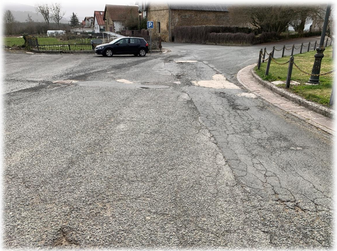
FOTOGRAFÍA 2: ESTADO ACTUAL DE LA CALLE
