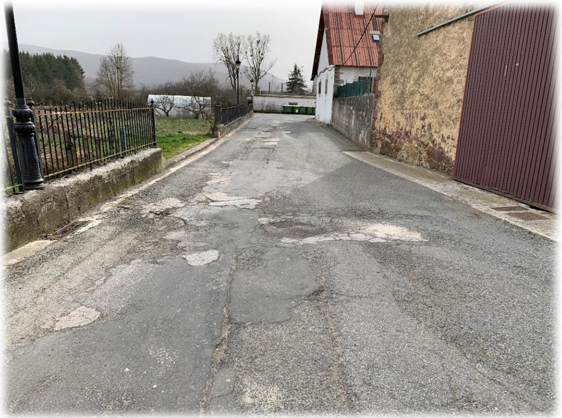
FOTOGRAFÍA 5: ESTADO ACTUAL DE LA CALLE
