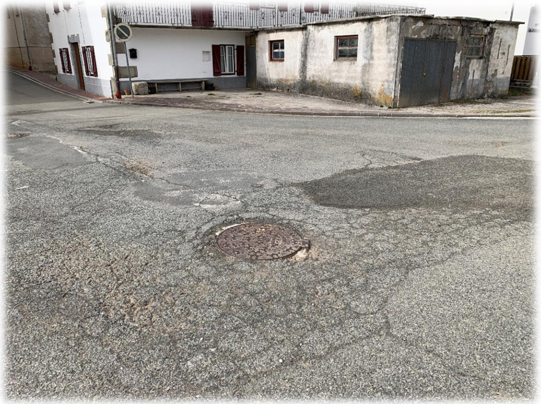
FOTOGRAFÍA 1: ESTADO ACTUAL DE LA CALLE
