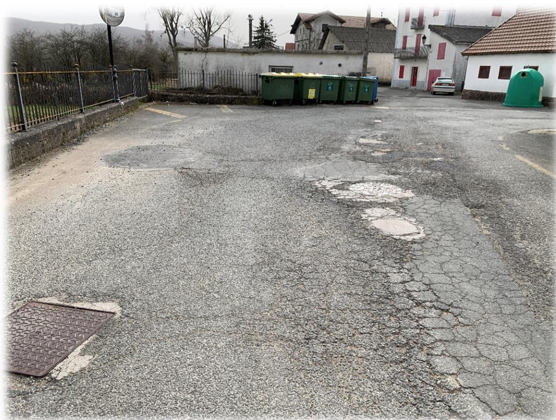
FOTOGRAFÍA 7: ESTADO ACTUAL DE LA CALLE
