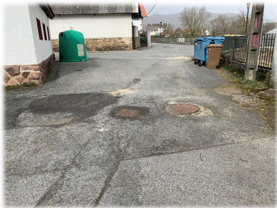
FOTOGRAFÍA 8: ESTADO ACTUAL DE LA CALLE
