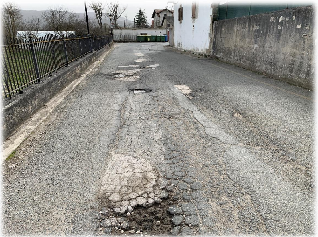
FOTOGRAFÍA 6: ESTADO ACTUAL DE LA CALLE
