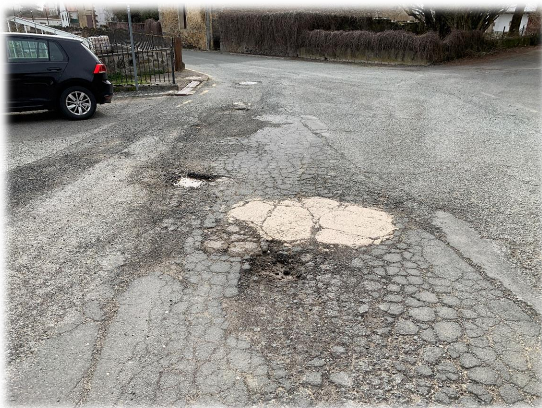
FOTOGRAFÍA 3: ESTADO ACTUAL DE LA CALLE
