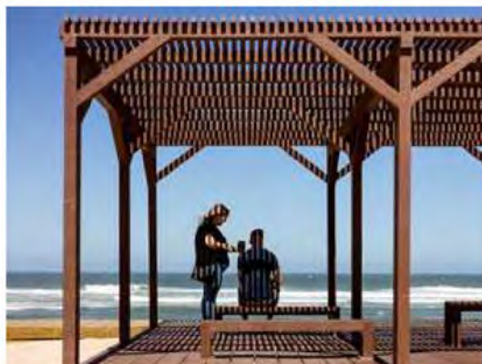
Pérgola con cubierta con perfiles de plástico reciclado
