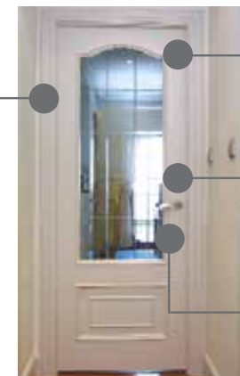
tabique de pladur (placas de yeso laminado y estructura interior metálica)
