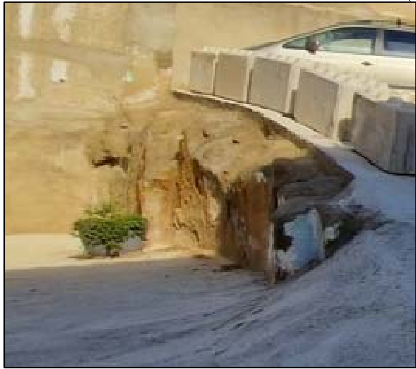
FOTO 1 Picado de muro para regularizar su forma
