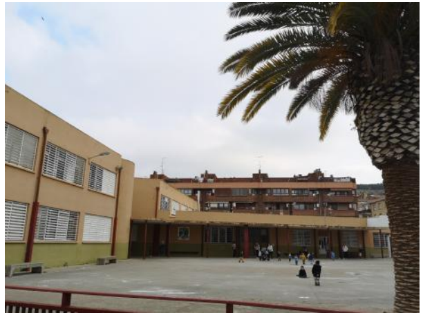
Fachada sureste, marquesina y guardería
