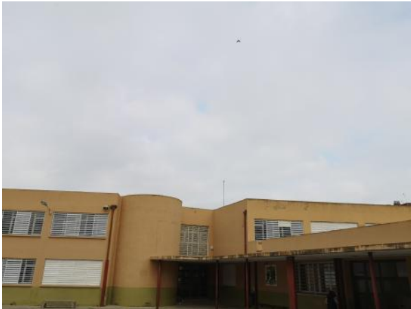
Acceso 01 desde marquesina
