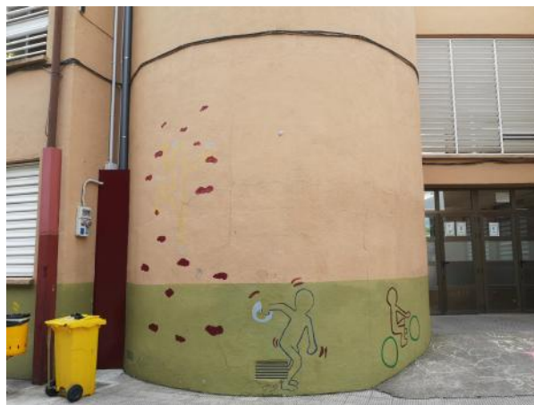
Acceso 01 desde fachada noroeste
