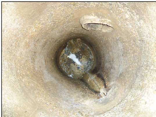
Pozos calle Fuente Canónigos:
