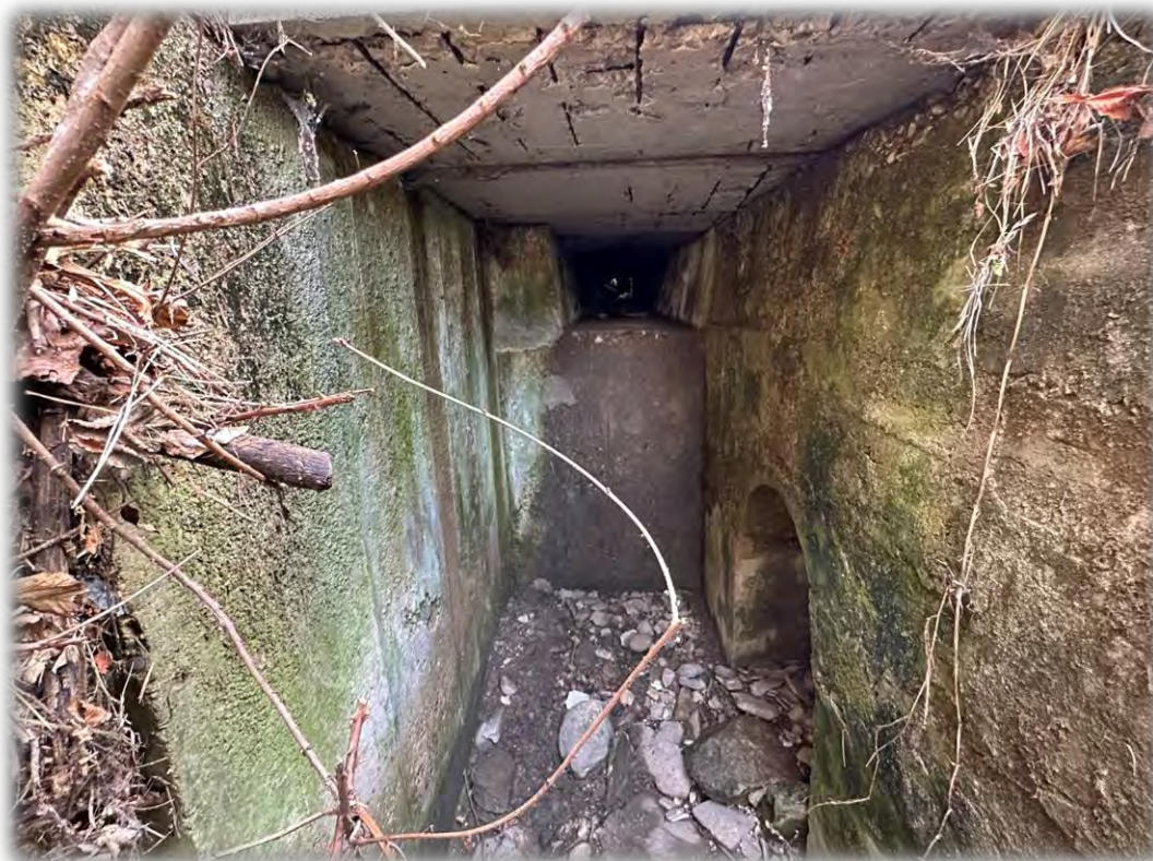
Fotografía 11: Obra de fábrica existe en donde se produce el vertido final de los colectores P-2 y P-3.
