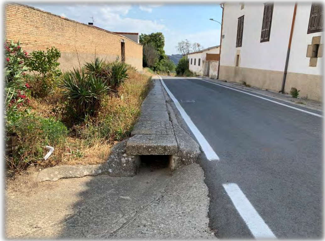
Fotografía 9: Vista general de la calle Esteban Pérez de Tafalla, inexistencia de aceras, frente el portal 10. Se observa uno de los canales de hormigón, con su tapa.
