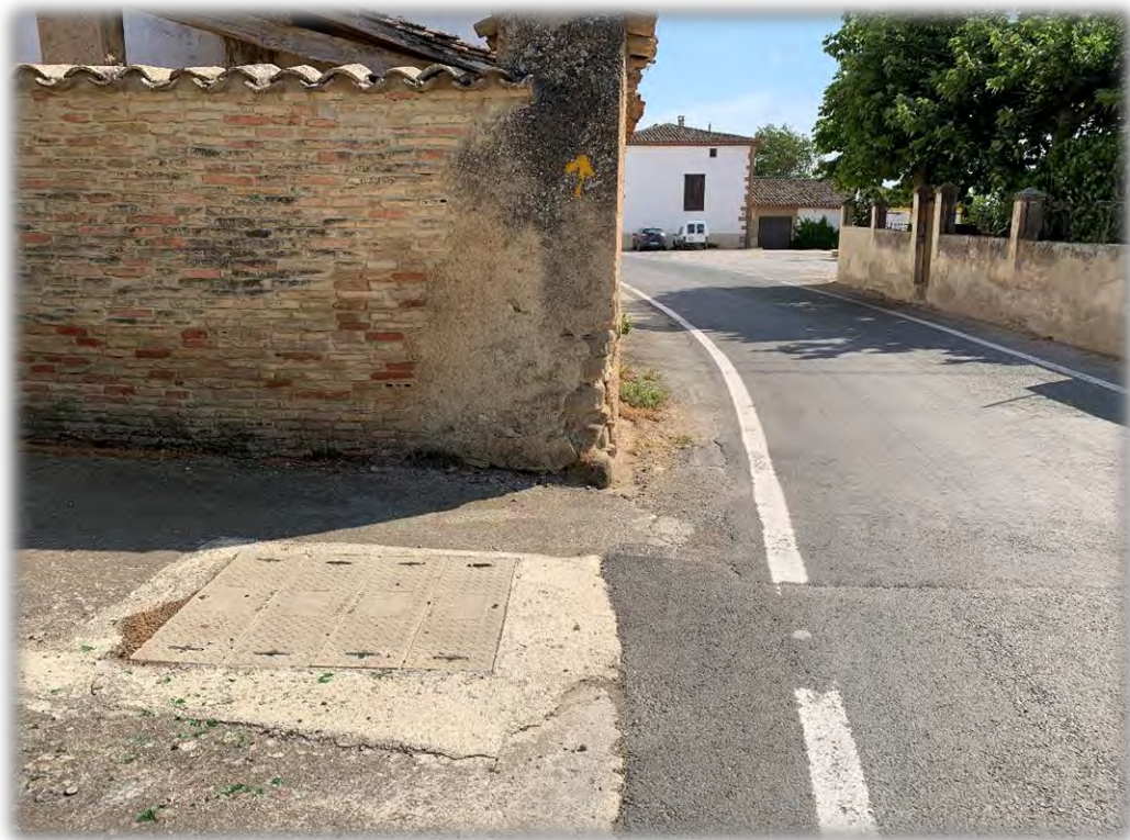
Fotografía 6: Vista general de la calle Esteban Pérez de Tafalla, inexistencia de aceras, tramo entre Ayuntamiento y portales 1 y 3.
