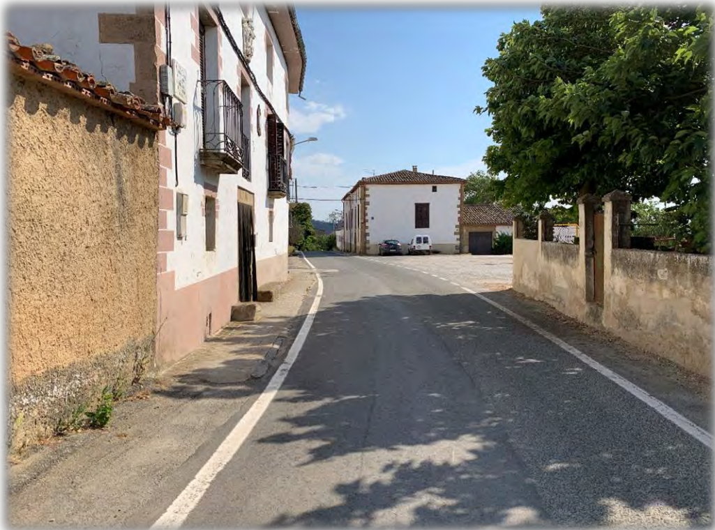
Fotografía 7: Vista general de la calle Esteban Pérez de Tafalla, inexistencia de aceras entre Ayuntamiento y portales 1 y 3. Y no accesibles entre los citados portales.
