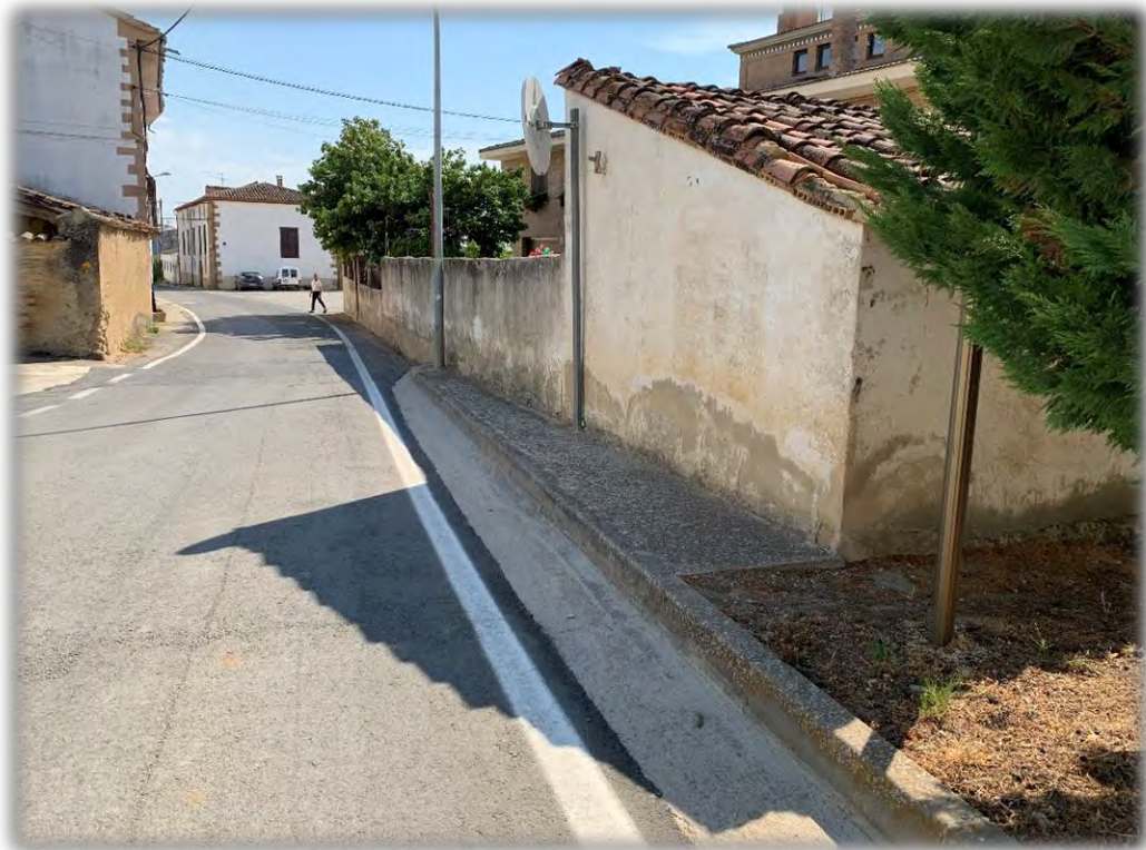
Fotografía 5: Vista general de la calle Esteban Pérez de Tafalla, inexistencia de aceras, tramo entre Ayuntamiento y portales 1 y 3.
