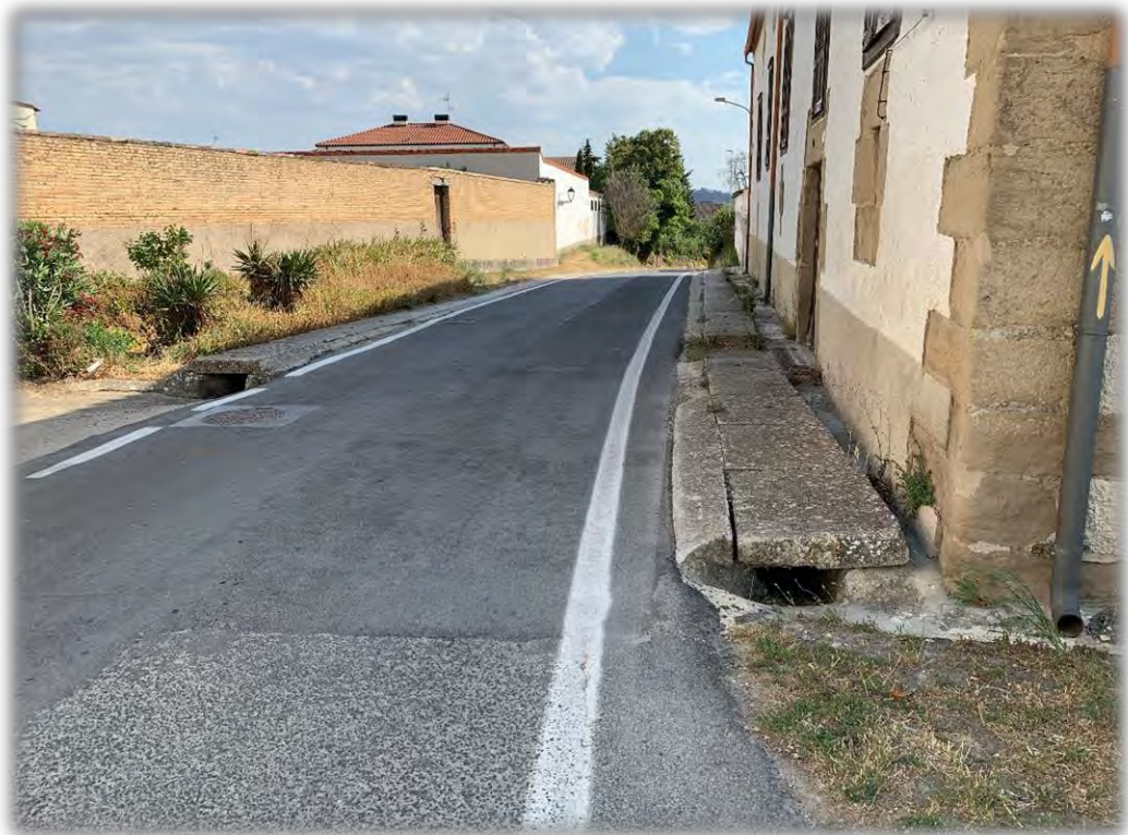
Fotografía 10: Vista general de la calle Esteban Pérez de Tafalla, inexistencia de aceras, frente el portal 10. Se observa uno de los canales de hormigón, con su tapa.
