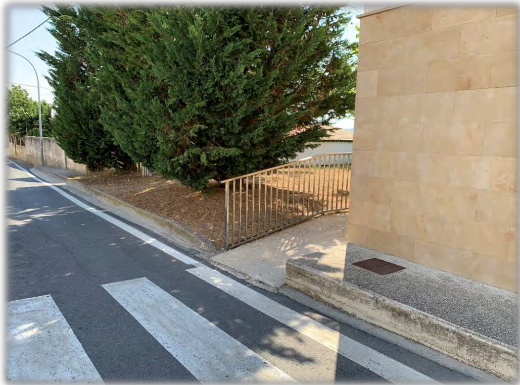
Fotografía 4: Vista general de la calle Esteban Pérez de Tafalla, acera del Ayuntamiento con escalón para rampa de acceso.
