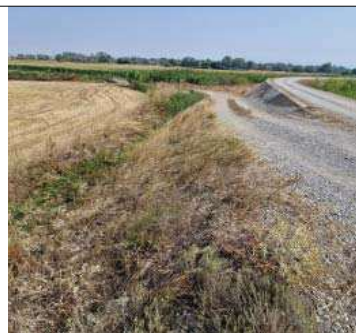
Imagen 4_Extremo oeste del tramo de talud hormigonado. El talud bajo el camino que se incorpora no está hormigonado.
