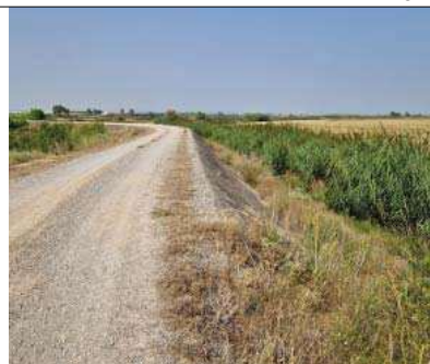
Imagen 3_Extremo este del tramo hormigonado
