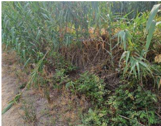
Imagen 7 _Punto con erosión en el talud
