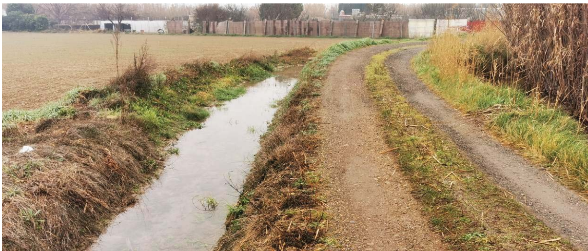
7. Acequia Arquetas, tramo en tierras. Intervención en las dos márgenes del camino
