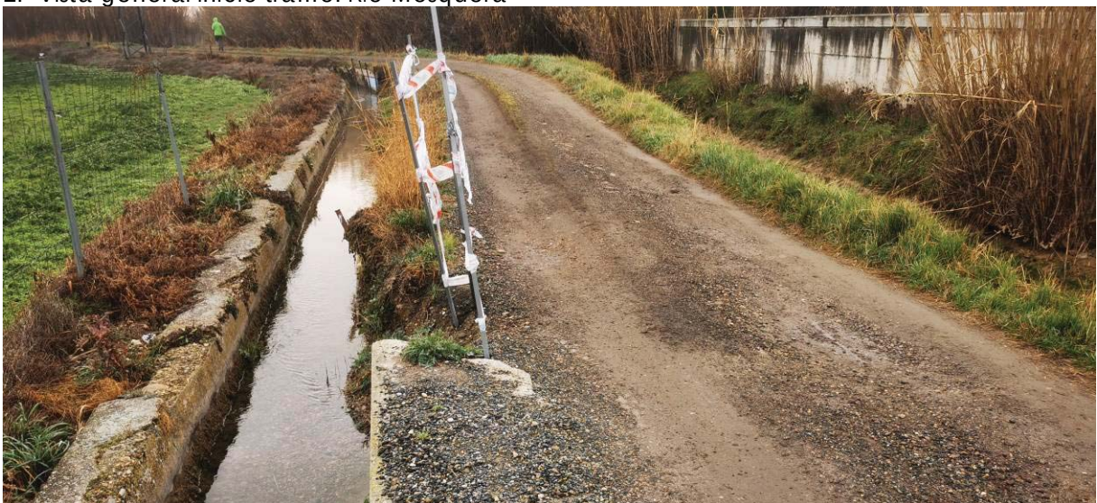
3. Vista general inicio tramo. Acequia Arquetas.
