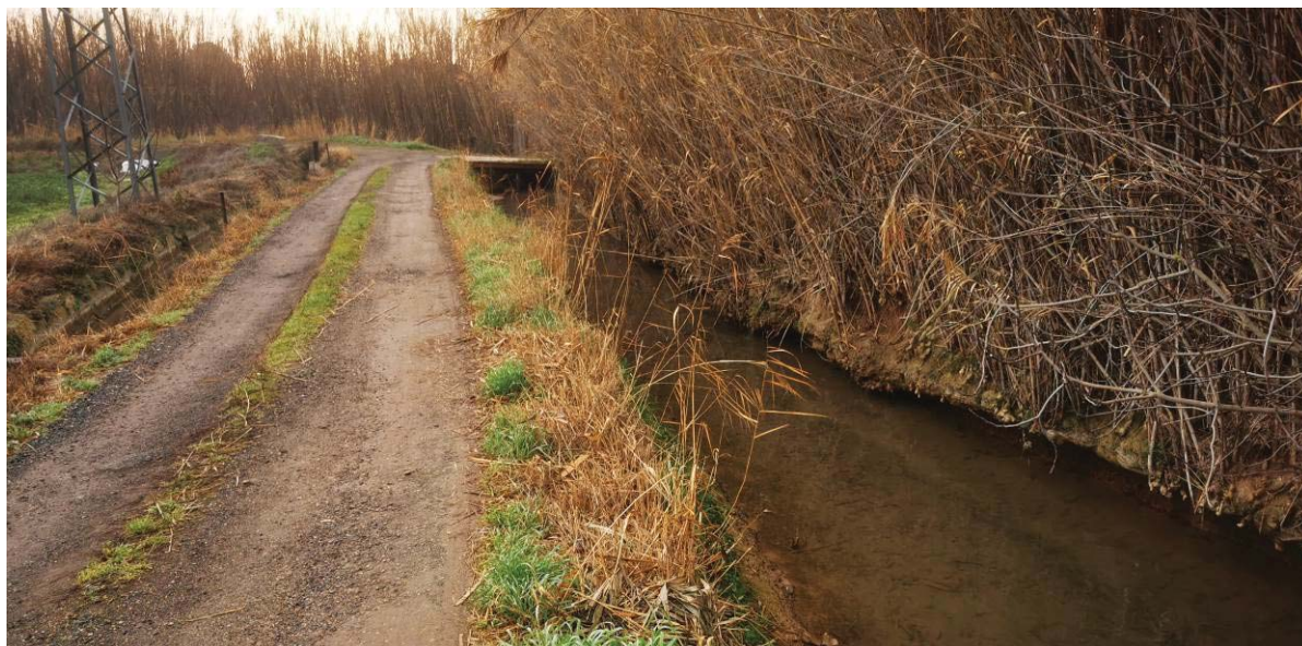
4. Tramo inicial. Actuación en margen derecha (Río Mosquera)
