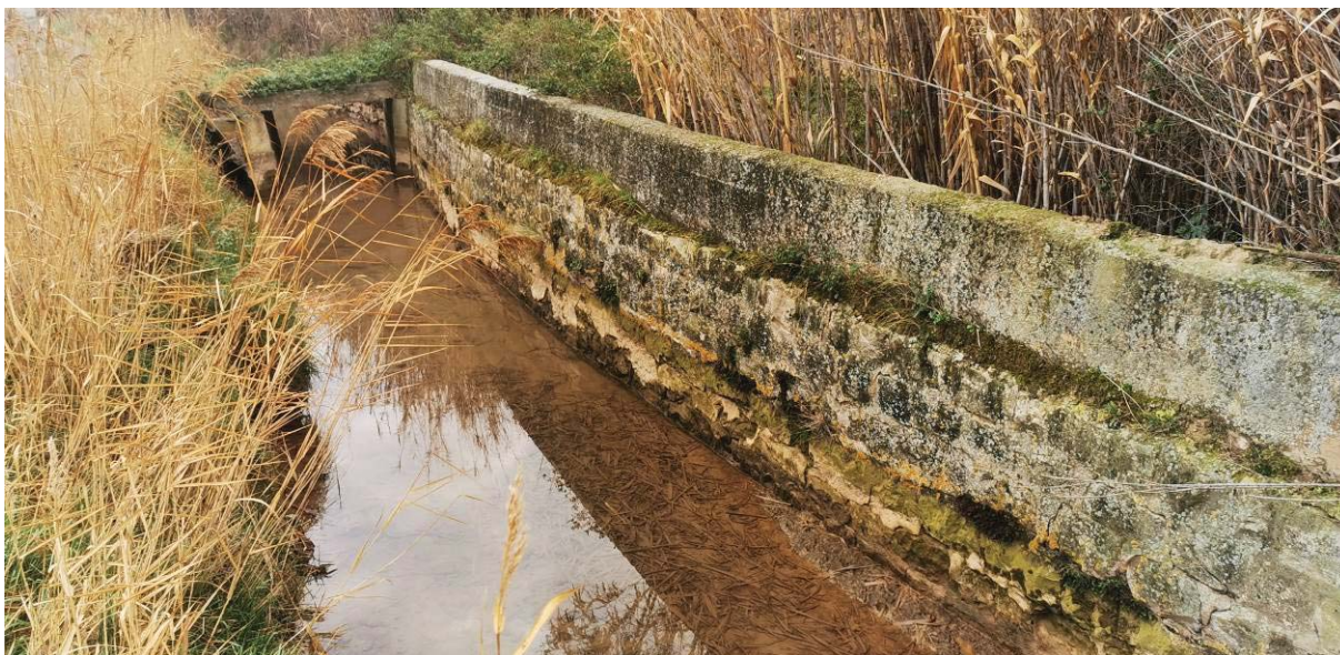
10. Vista Río Mosquera. Tramo final. Zona muro.
