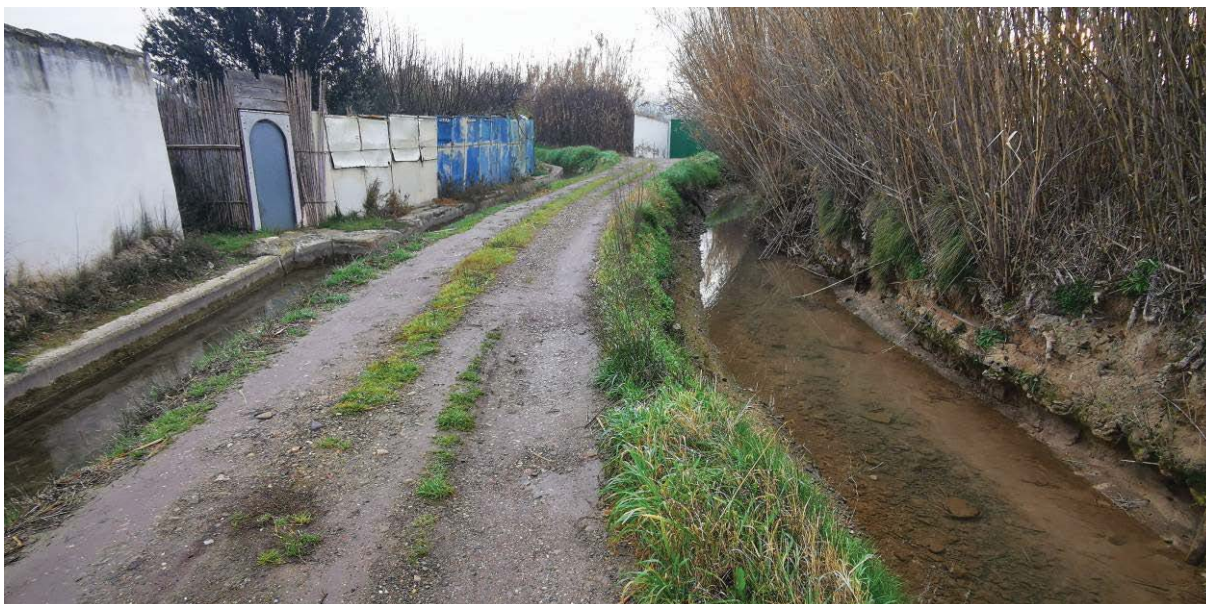
13.Vista tramo final.
