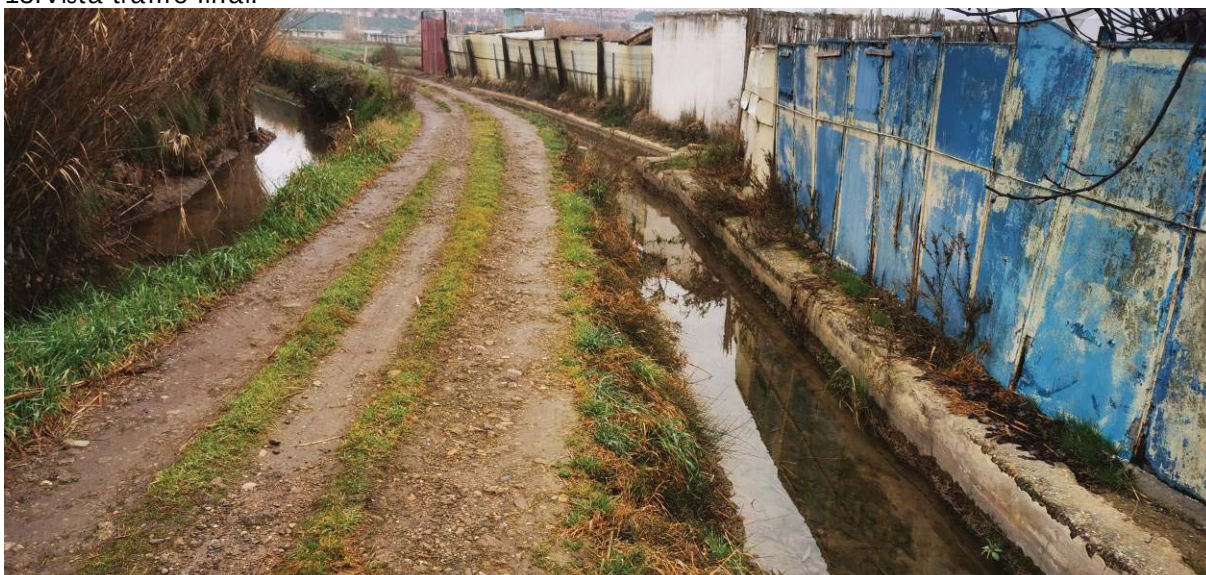
14.Tramo final. Estrechamiento. Acequia Arquetas (dcha en la imagen) y Río Mosquera (izq).
