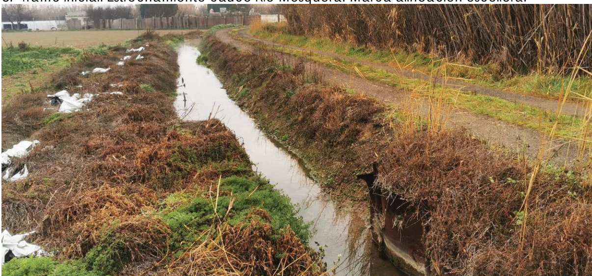
6. Inicio tramo centra. Acequia Arquetas en tierras.
