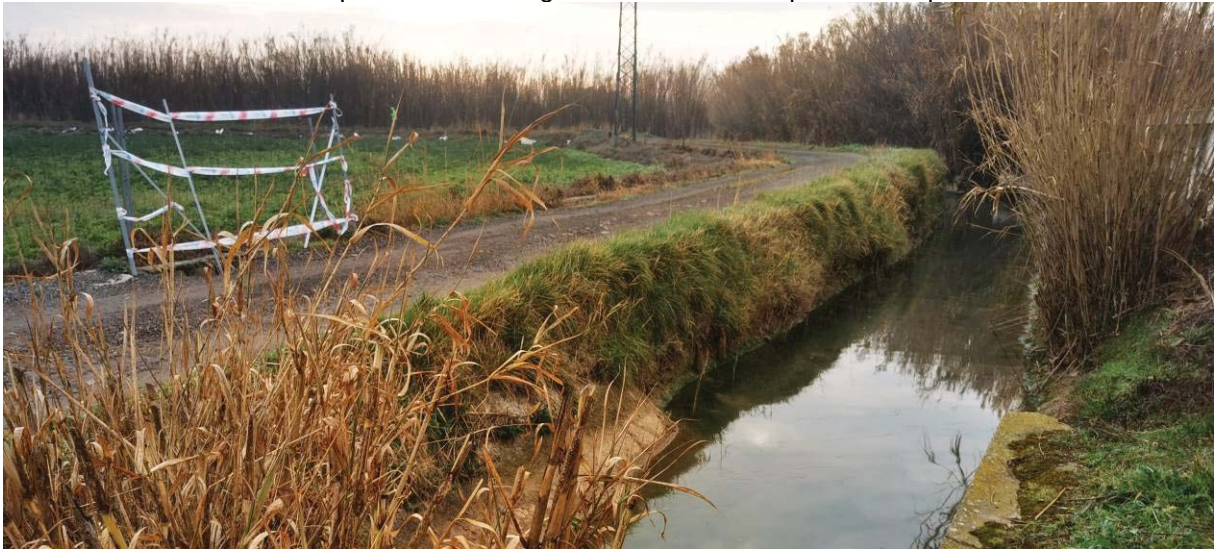
2. Vista general inicio tramo. Río Mosquera
