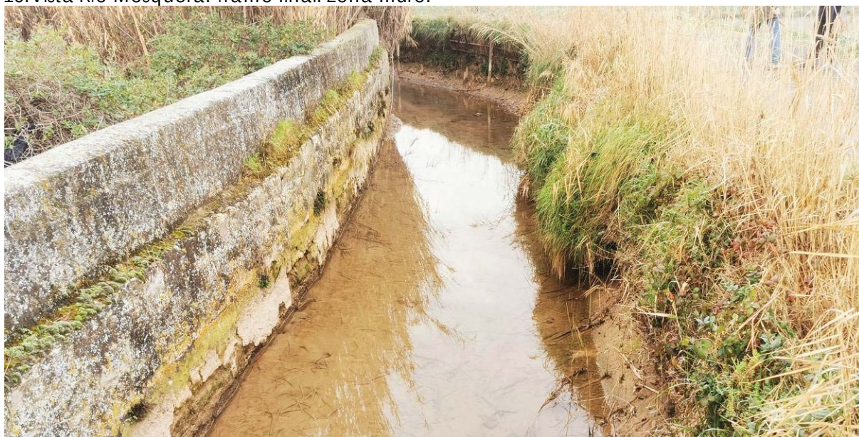
11. Vista Río Mosquera. Tramo final, zona muro.
