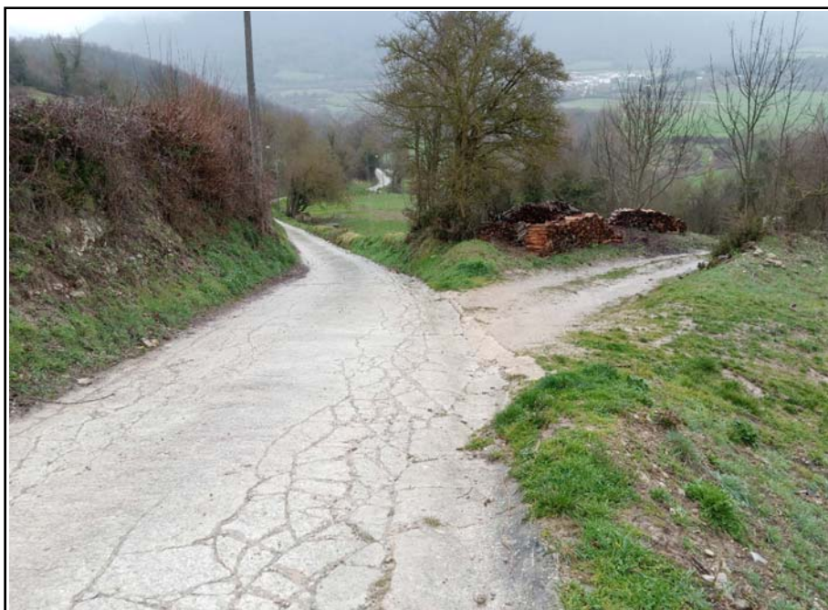
Imagen 3: Tramo final del tramo a reparar en el entronque con el camino entre las parcelas 345 y 347.
