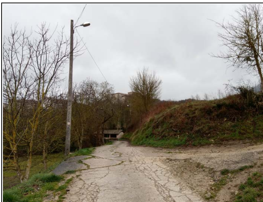
Imagen 4: Vista desde el mismo punto de la imagen anterior hacia el tramo a reparar donde se observa la práctica totalidad del tramo a reparar. Al fondo se observa el lavadero, desde donde está tomada la primera imagen de este Anejo.
