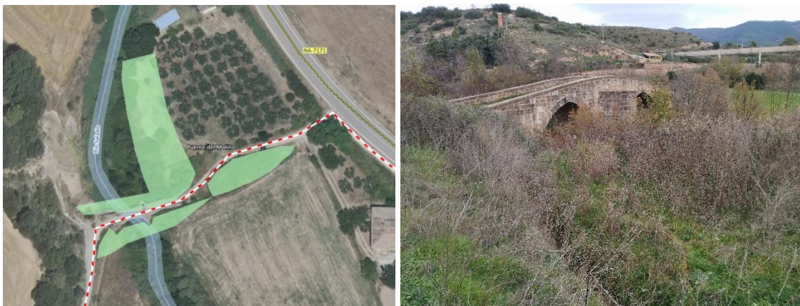
Detalle de las zonas de actuación junto al puente del Río Salado y estado actual.
