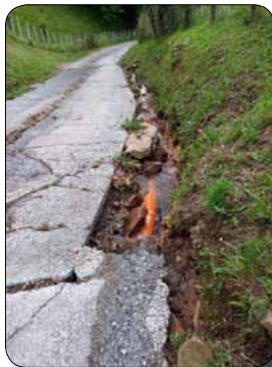
Peñaborda. Desmantelamiento de cuneta hormigonada
