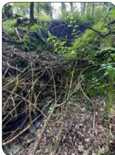
Suspelttiki 1. Restos de caños aguas abajo
