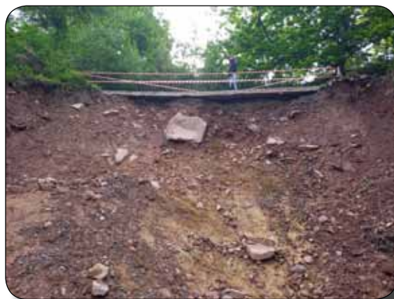
Larratxen Borda. Detalle del talud resultante y magnitud del descalzamiento
