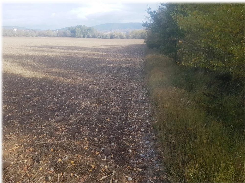
Fotografía 6: Apertura de nuevo camino y desbroce.
