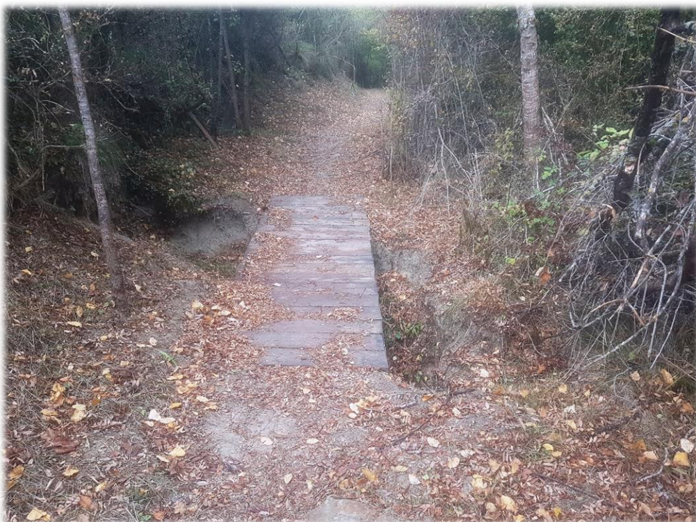
Fotografía 11: Cambio de pasarela con barandillas de seguridad.
