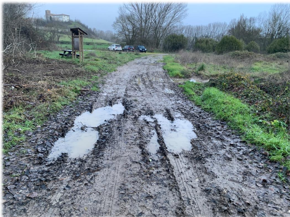
Fotografía 1: Zona a rasantear y regularizar, comienzo del Camino.
