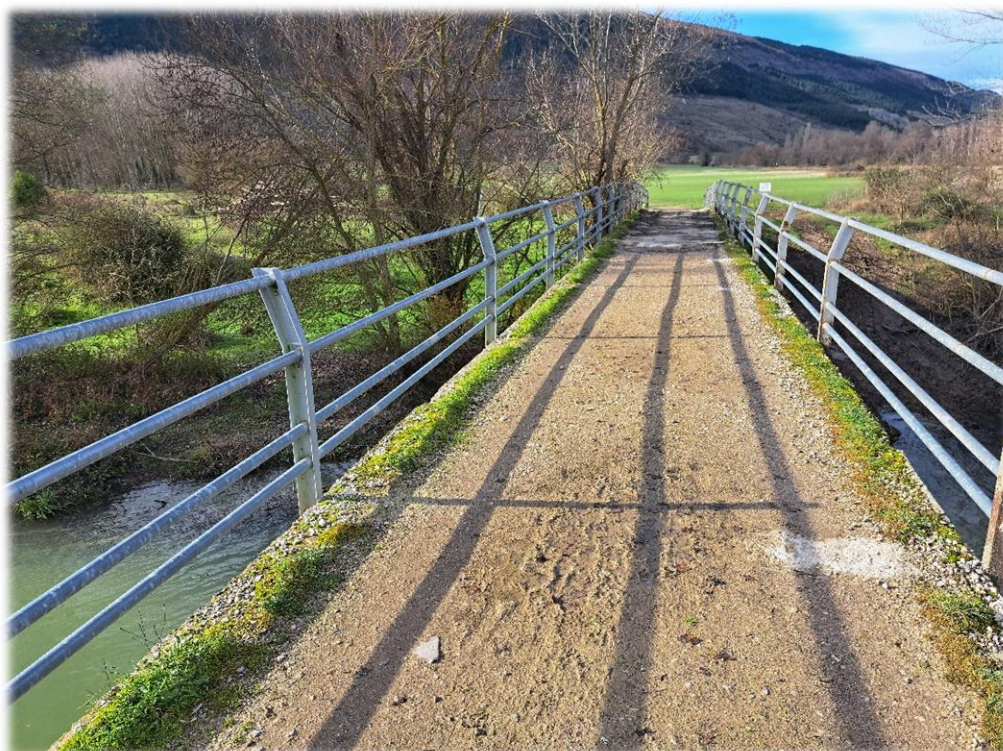
Fotografía 16: Acondicionamiento de rodadura de puente y renovación cierres con barandillas de seguridad.
