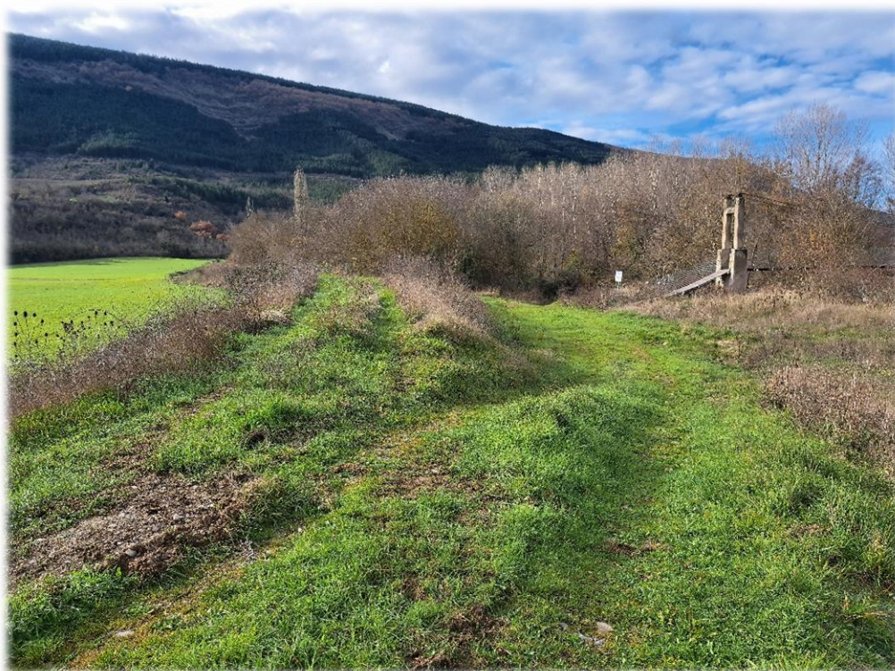
Fotografía 3: Regularización y rasanteo de camino existente tras desbroce.
