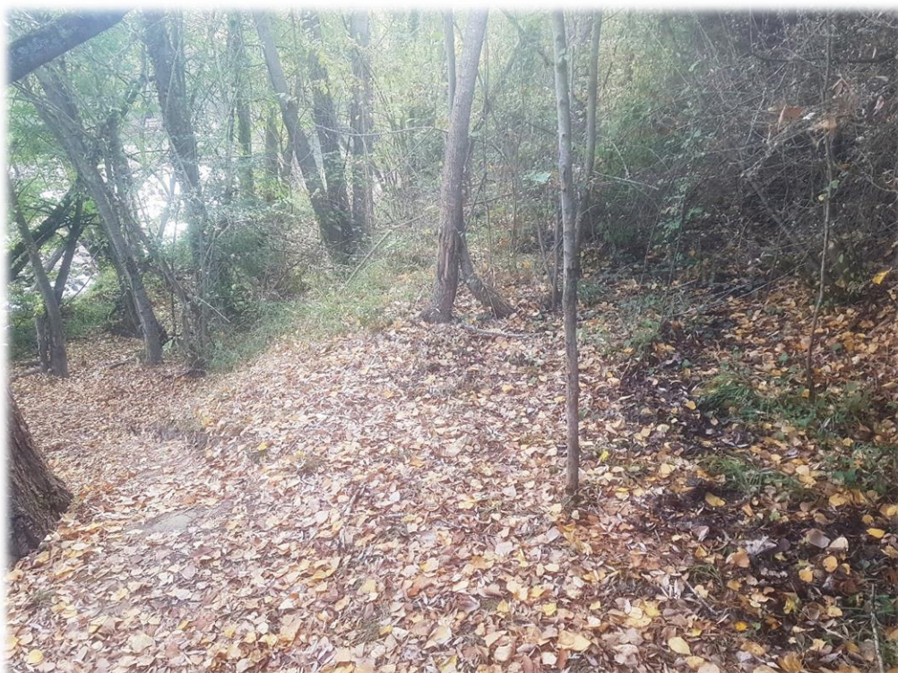
Fotografía 8: Desbroce y trazado recto de camino por antiguo trazado, plataforma existente.
