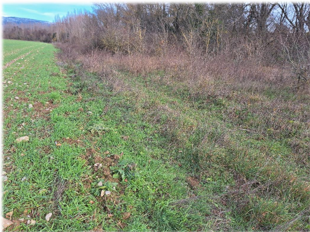
Fotografía 7: Apertura de nuevo camino y desbroce.
