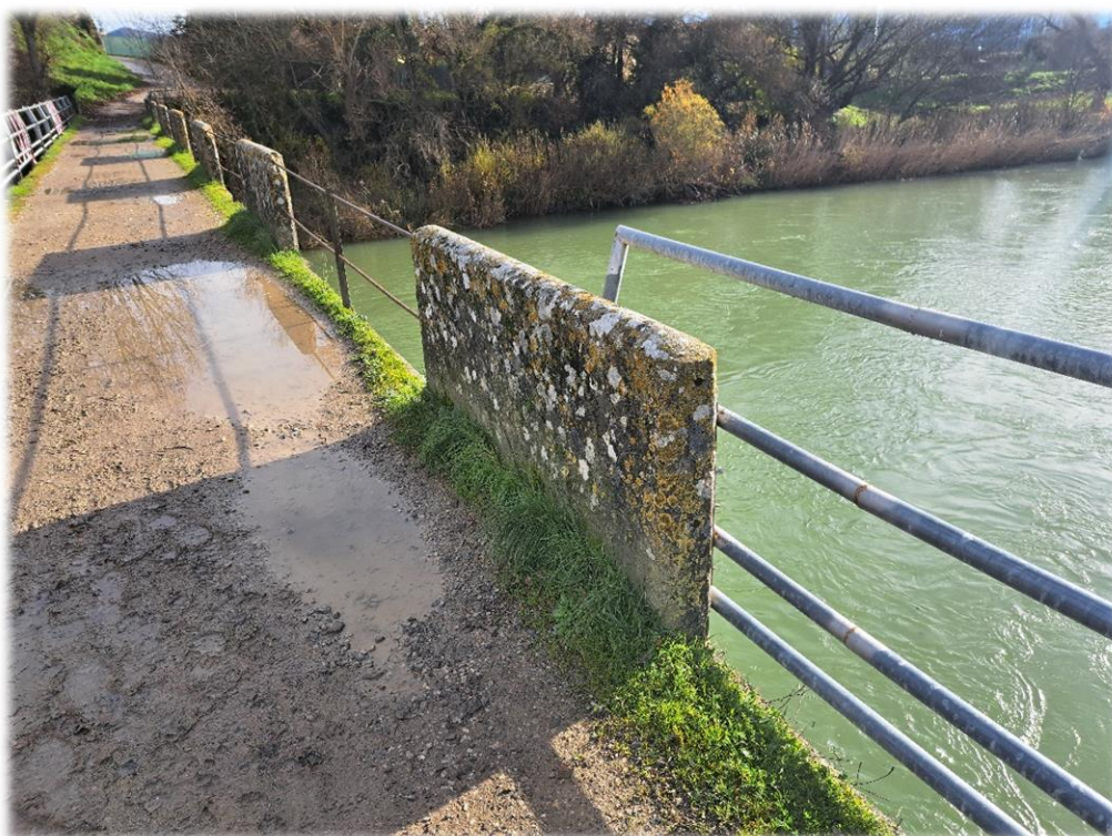
Fotografía 14: renovación cierres con barandillas de seguridad.
