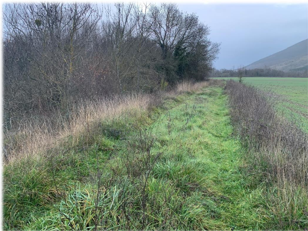
Fotografía 4: Regularización y rasanteo de camino existente tras desbroce.
