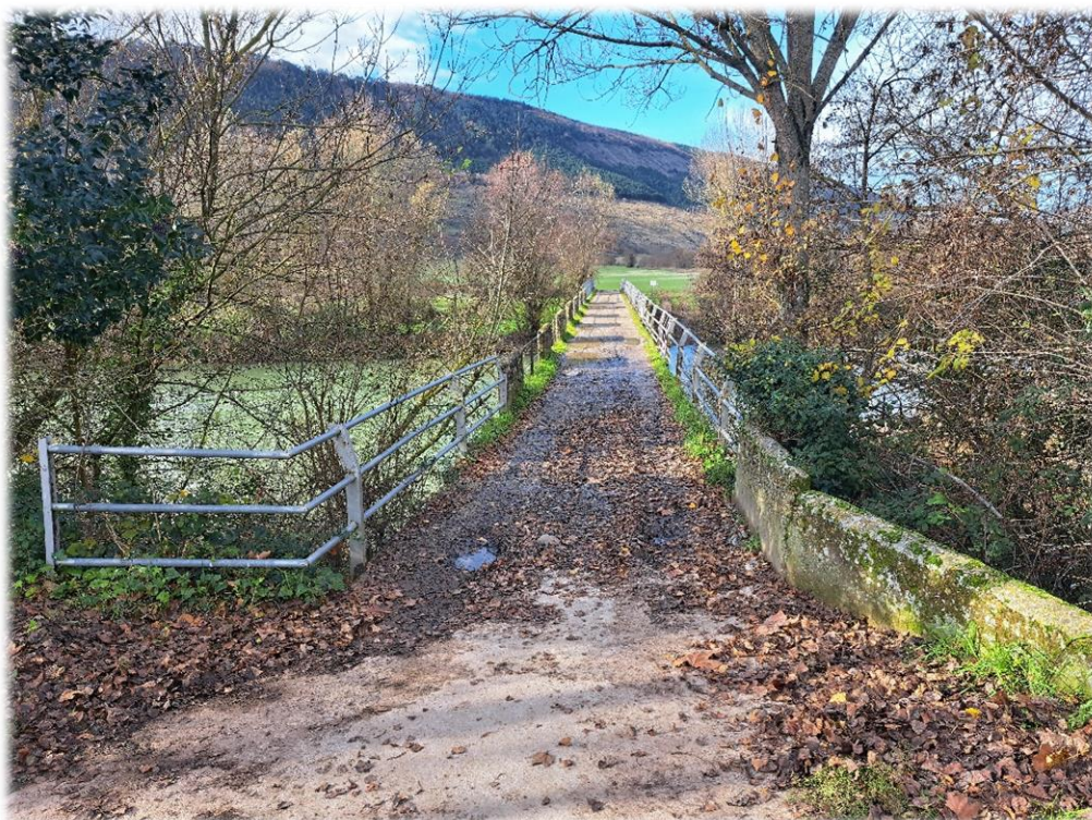
Fotografía 13: Acondicionamiento de rodadura de puente y renovación cierres con barandillas de seguridad.
