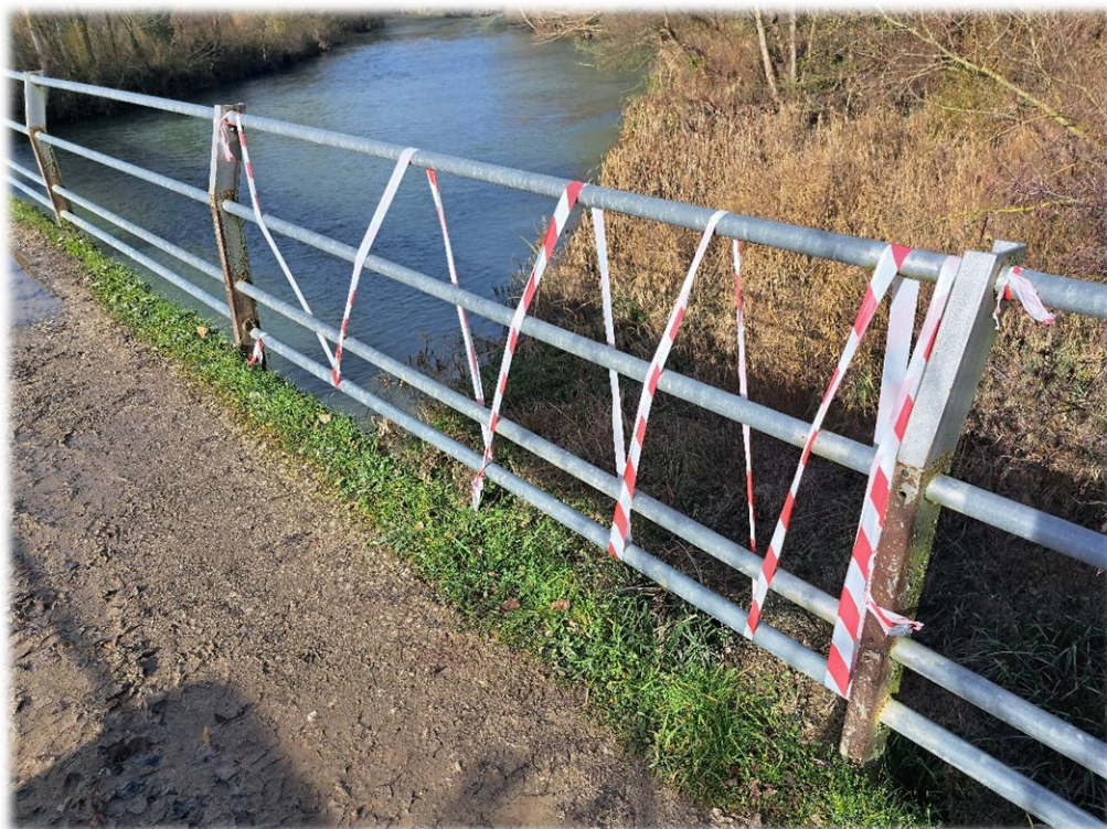
Fotografía 15: Renovación cierres con barandillas de seguridad.
