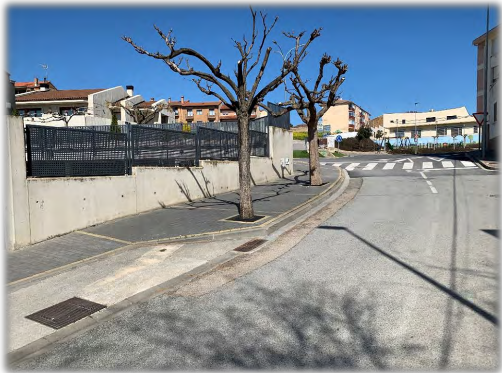
Fotografía 1: Ubicación arqueta reductora en la calle Cañada Real.
