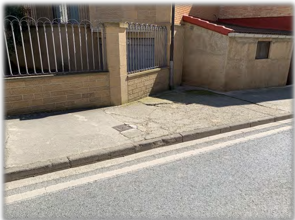
Fotografía 6: Conexión con la Red de Distribución, sectorización de la margen izquierda de la Carretera Lerín.
