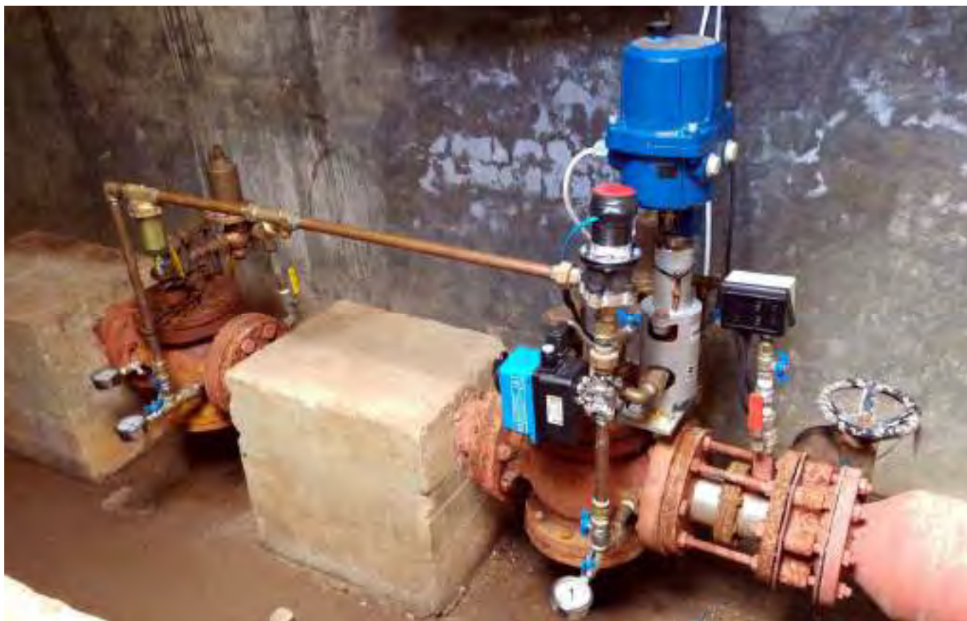
Gestor de Presiones Rocket y caudalímetro alimentados por la Turbina TR de Mistral Ross
