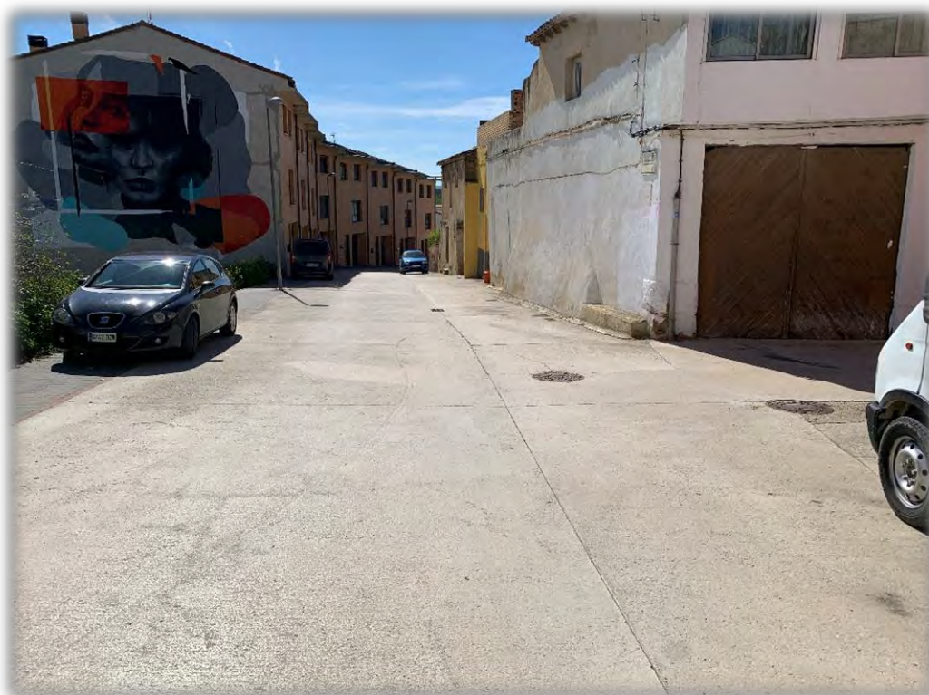
Fotografía 7: Ubicación de la arqueta reductora en la calle San Esteban.
