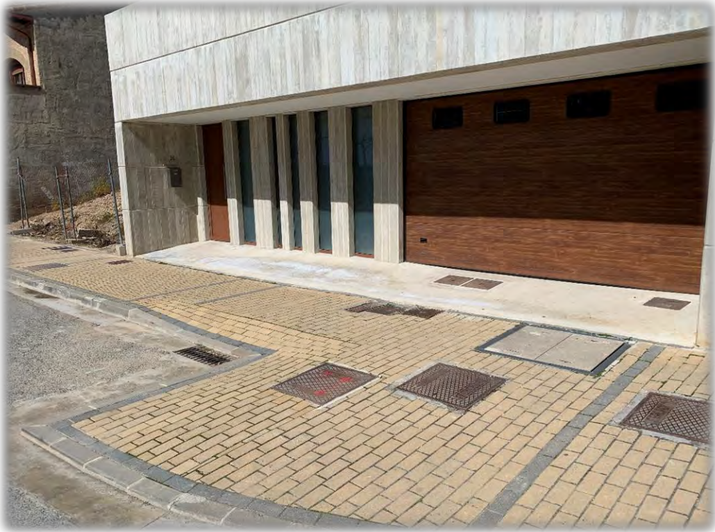
Fotografía 3: Ubicación de la nueva arqueta de conexión con la red de distribución y sectorización de la misma.
