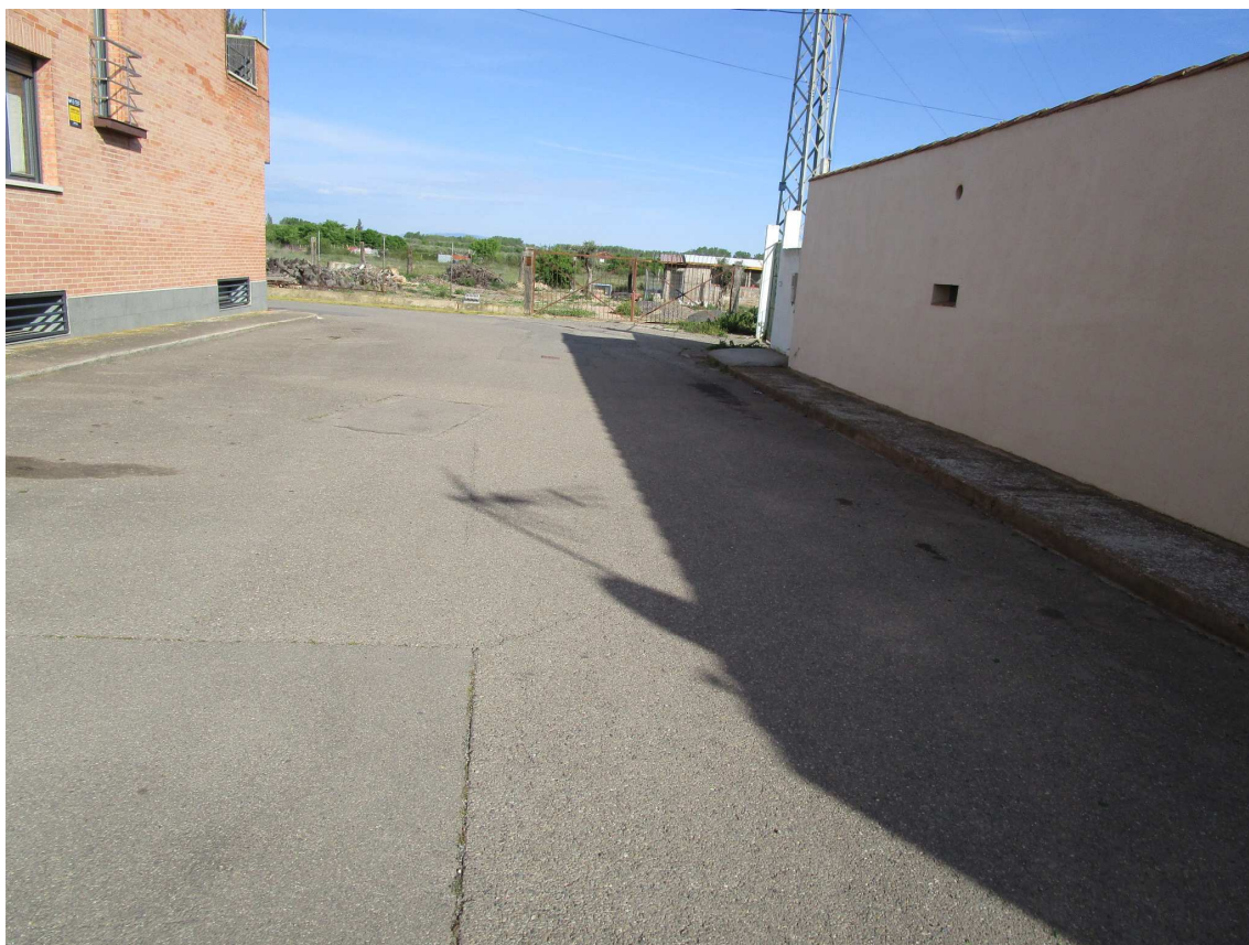
Fotografía 4: Vista c/ Ronda Palmera en inicio del Colector 1 de saneamiento, PR-01.
