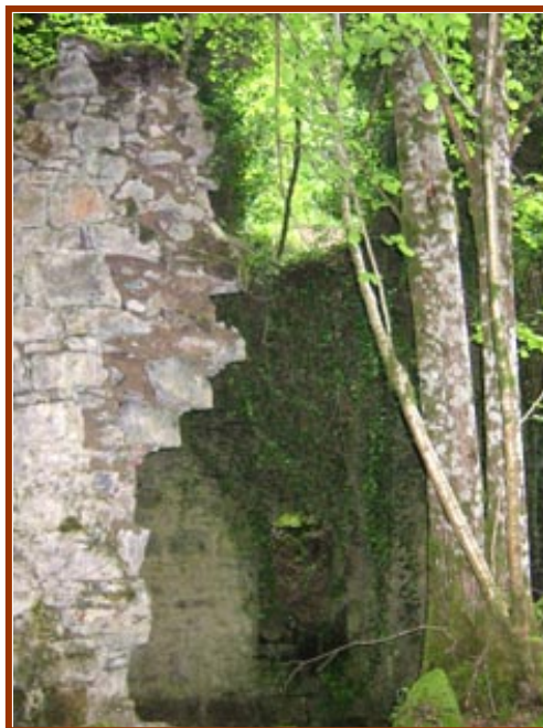
Fig. 30.- En la parte superior acceso para pasar el carbón a la boca de los hornos.
