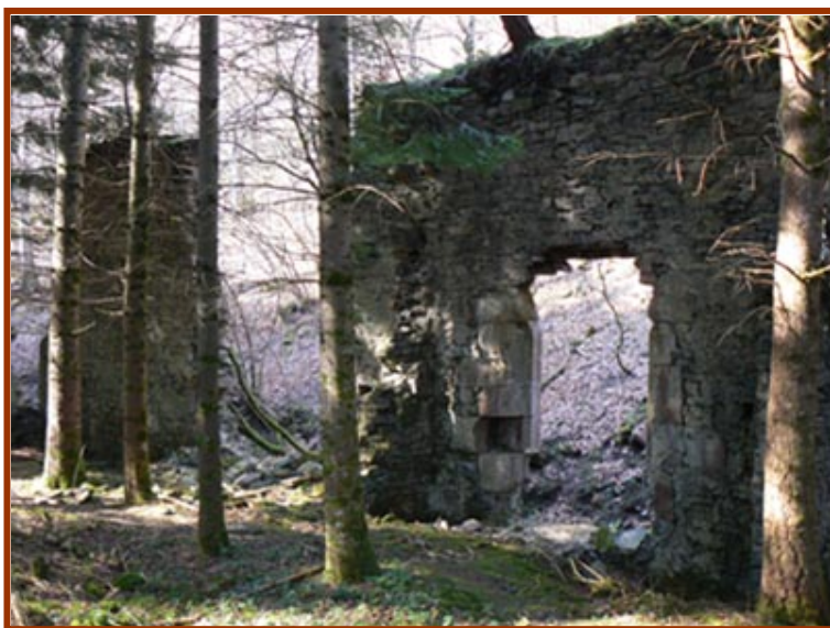
Fig. 23.- Edificio de oficinas o talleres. Fachada Norte.
