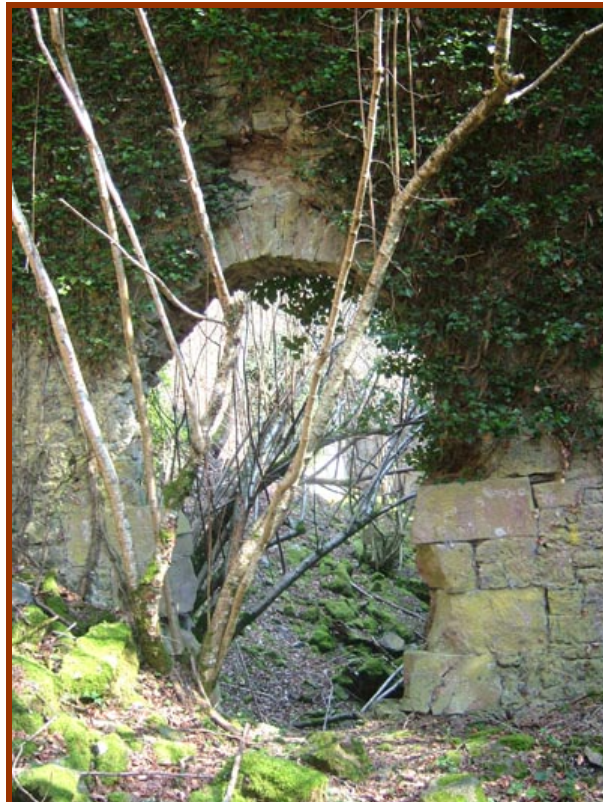
Fig. 32.- Puerta de la carbonera Norte. Fachada Oeste.
