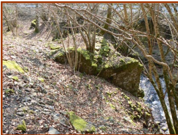
Fig. 20.- Estructuras de la antigua fábrica reaprovechadas (Vid Fig.1, nº 7).
