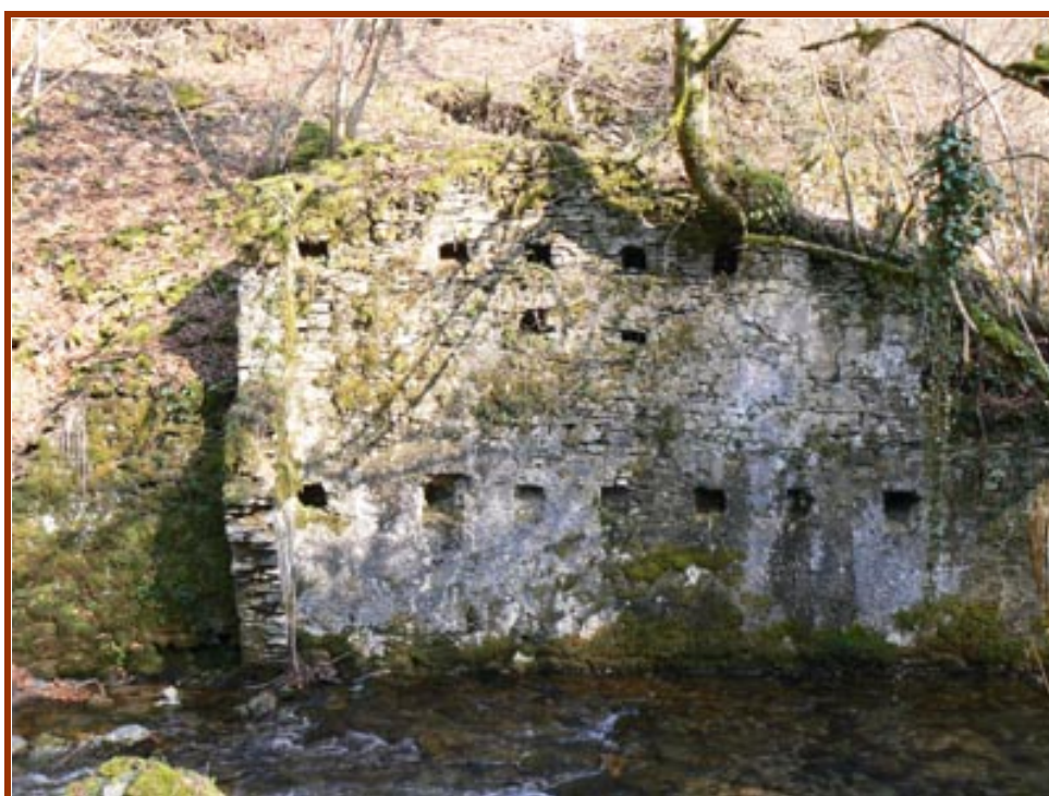
Fig. 34.- Mechinales a distinto nivel (Vid Fig. 1, nº 7)
