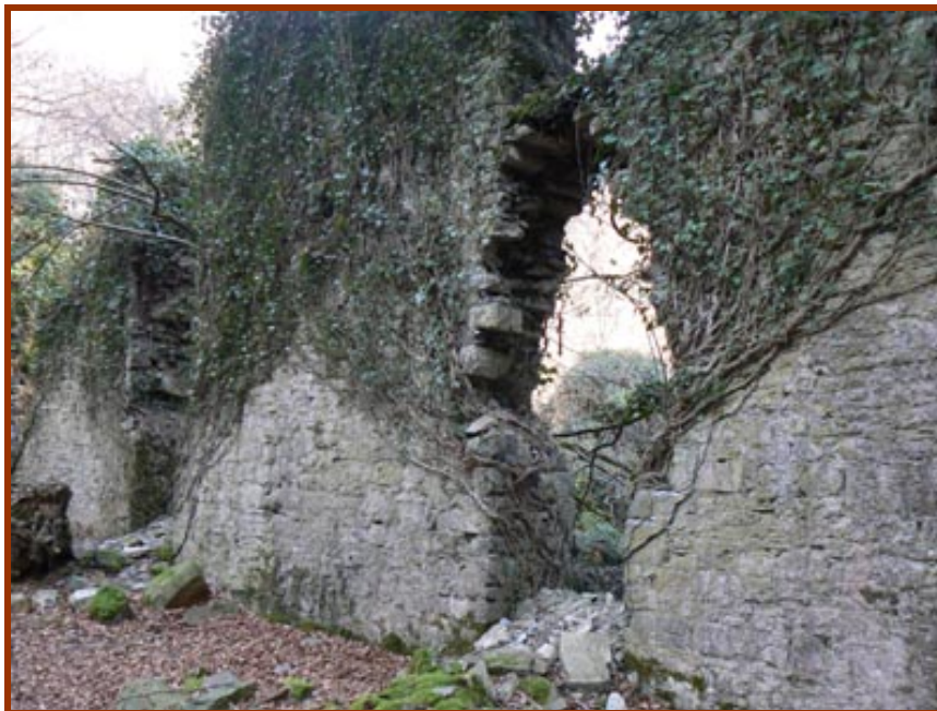
Fig. 44.- Bocas superiores de descarga de la carbonera de San Lorenzo.
