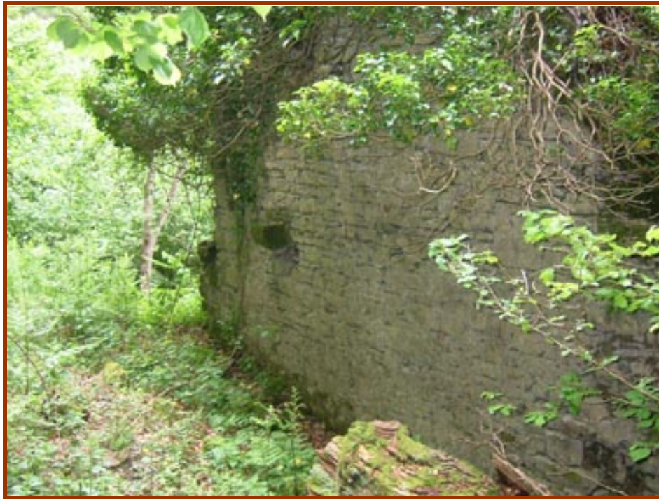
Fig. 31.- Ménsula para tinglado en zona de descarga.
