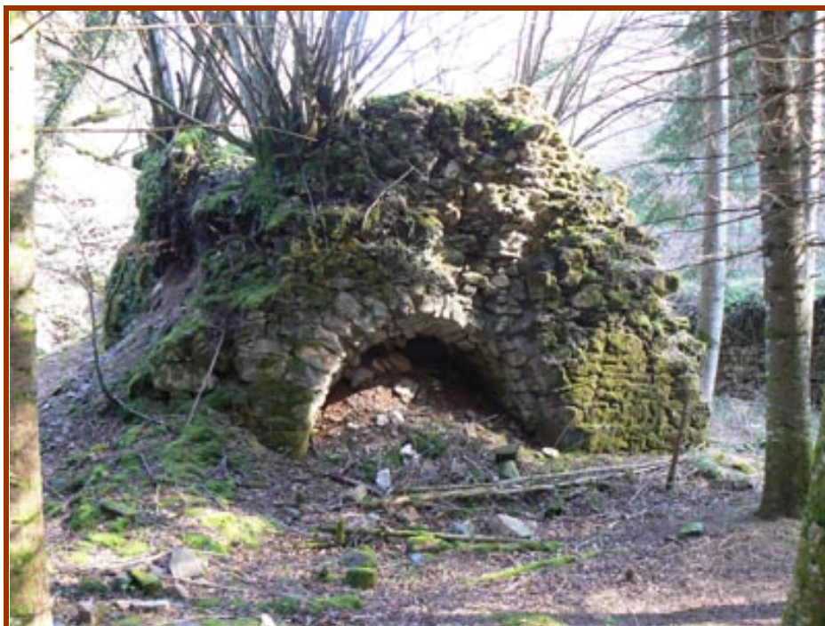
Fig. 35.- Boca Oeste del horno de Santiago.
