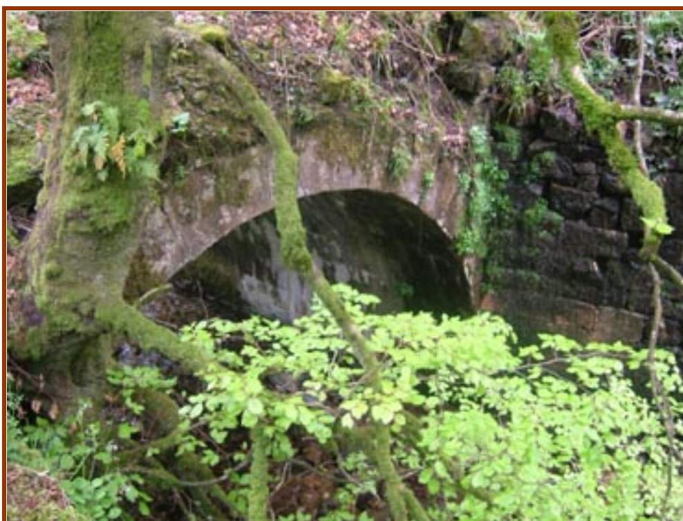
Fig. 49.- Puente de la Puerta de Francia.
