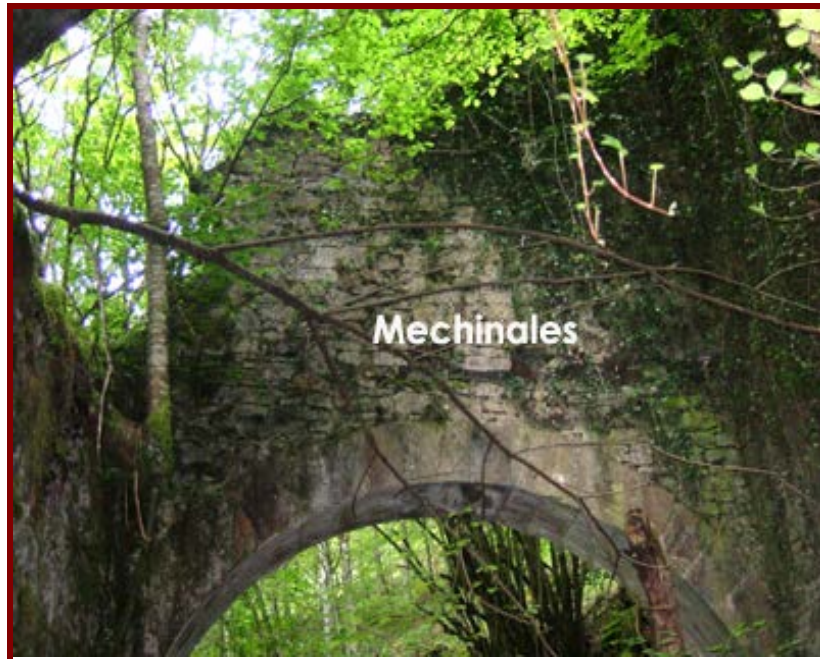
Fig. 28. Mechinales para la plataforma que cubría el río.
