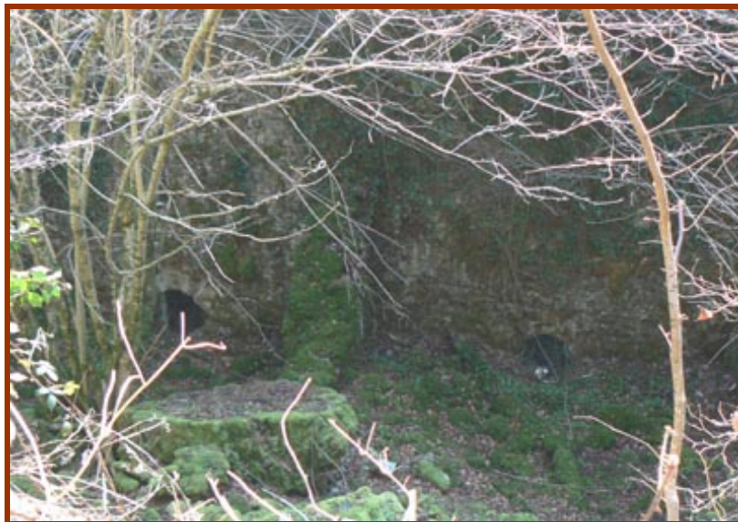
Fig. 29.- Interior de la carbonera Norte. Muro divisorio y vanos inferiores.
