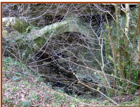
Fig. 11. Arquería sobre el río.
