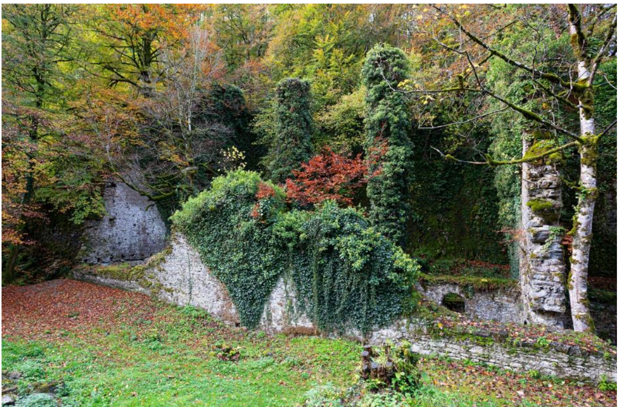
Vista del compartimento sur desde la calle inferior. En el interior se distinguen dos esbeltos pilares cubiertos de vegetación y, a la derecha de la imagen, el muro que separa los dos compartimentos en que está dividido el interior de la carbonera.
