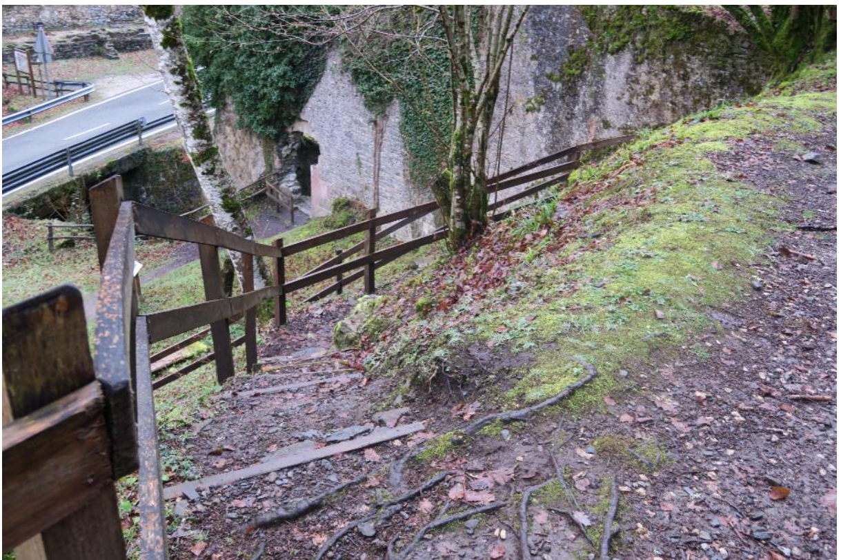
Vista de la escalera desde el arranque superior
