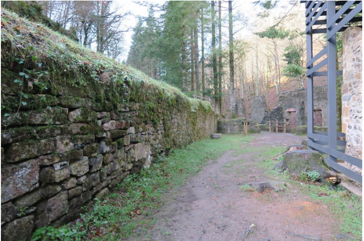
Muro de cierre del taller de moldería situado frente a los hornos, que hace de límite y contención al relleno sobre el que se construyó en el siglo XX la carretera que atraviesa la fábrica. Al fondo se ven los muros que se conservan de otros talleres.
