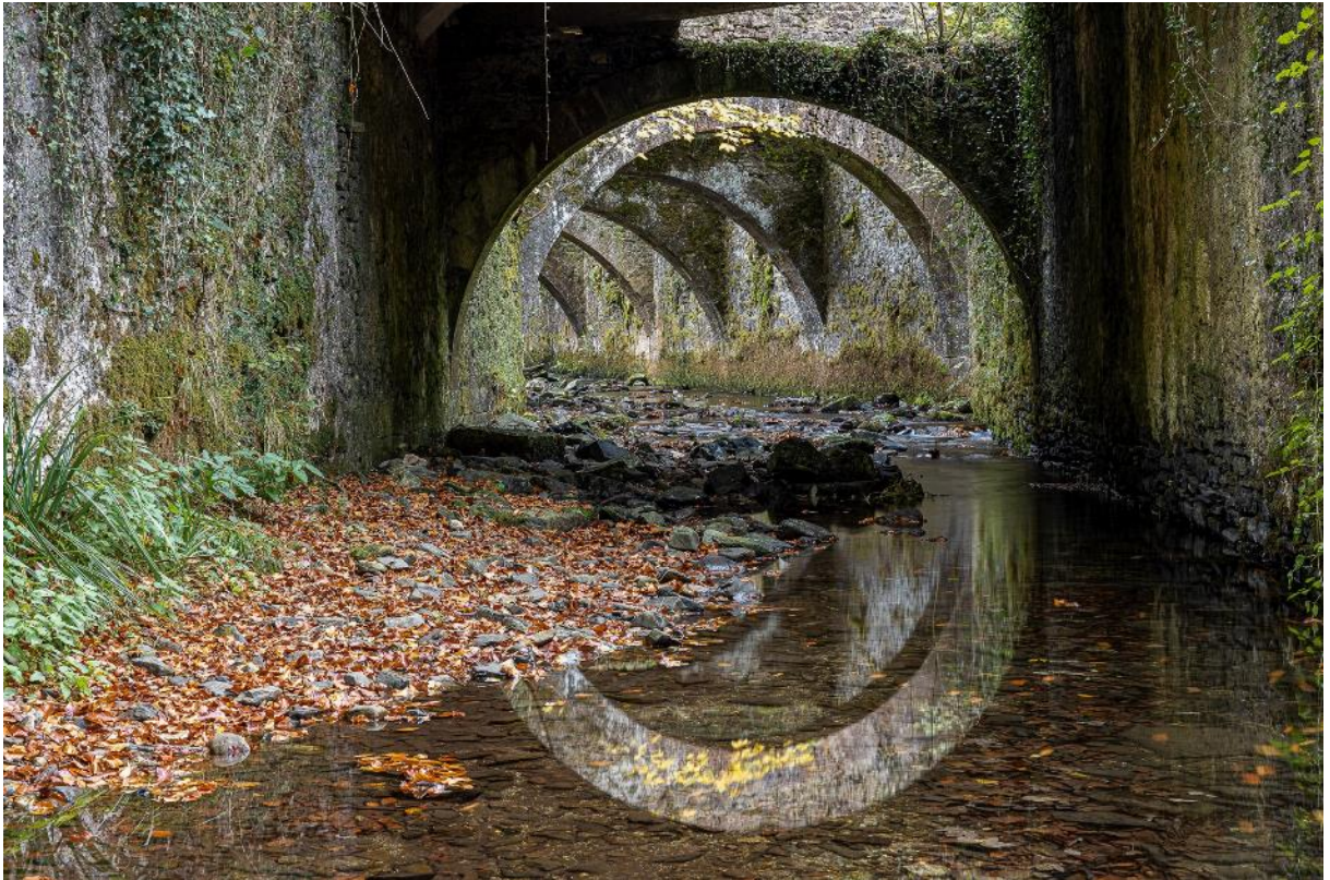
Vista de la canalización del río Arga justo después de superar la Carbonera Mayor con los arcos que salvan el cauce al fondo. Fuente: Goio Seminario.
