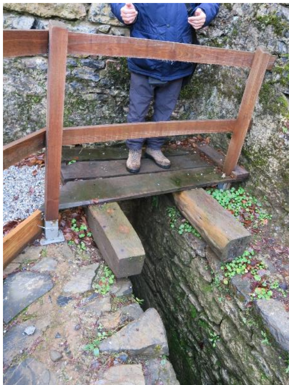
Izda.: Ejemplo de cómo estaría cubierto el canal de hornos con una pasarela de madera. Dcha. Arriba: compuerta. Dcha. Abajo: final de canal de hornos donde el agua retornaría al cauce del río.
