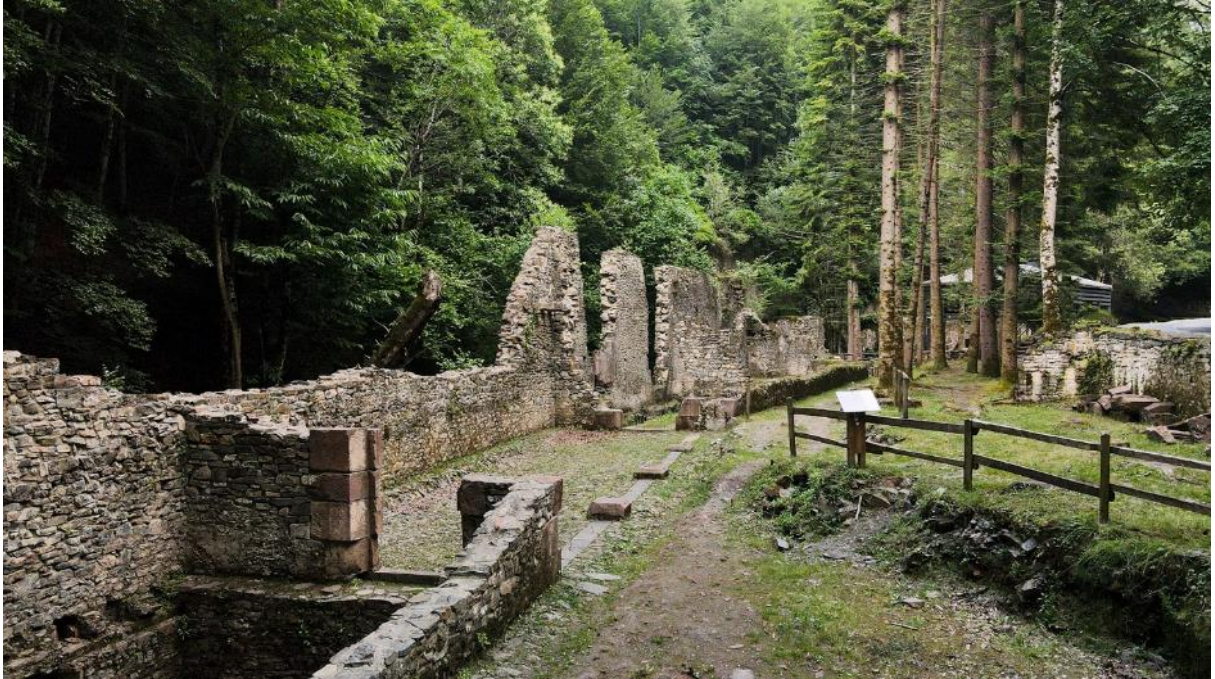
Vista desde el acceso al edificio de palacio con los restos de una estancia en primer término que serviría como calabozo, basas del espacio porticado del patio interior del edificio en segundo plano y, al fondo, restos de los muros de las construcciones destinadas a talleres. Fuente: Goio Semianario.
