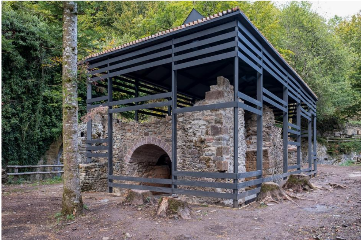
Estado actual de los hornos tras los trabajos de recuperación y consolidación realizados entre los años 2012 y 2022 y la construcción de una estructura de protección.
