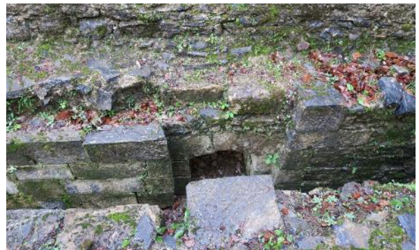
Canal de hornos visto desde lados opuestos a su paso entre el muro de cierre sur de la Carbonera Menor y el edificio de los hornos. Se ven los restos de los contrafuertes mutilados que contrarrestaban los empujes de los arcos sobre el río del edificio de la carbonera.
