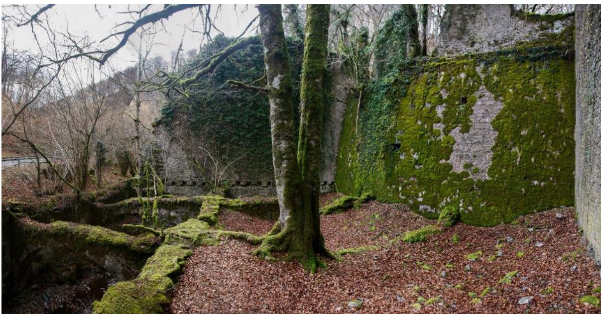
Vista del interior del compartimento norte con el gran haya en primer término, el cauce del río en la parte izquierda y la pared ataluzada contraterreno a la derecha de la imagen. Fuente: Goio Seminario
