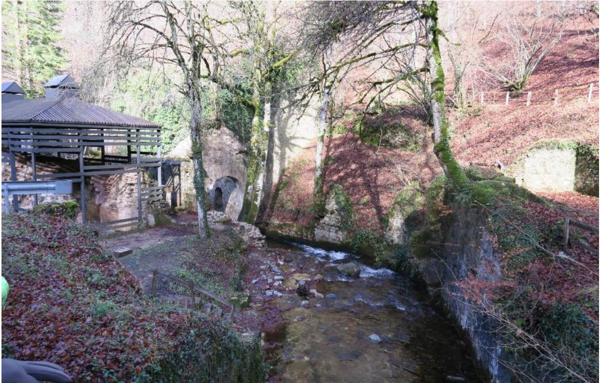
Canalización del río con parte del muro de contención arruinado vista desde el nivel de la carretera. Al fondo a la izquierda se encuentran los hornos de fundición y, a su derecha, los restos del edificio de la Carbonera Menor
