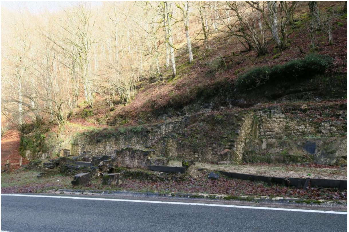
Restos de edificaciones destinadas a viviendas, talleres o almacenes.
