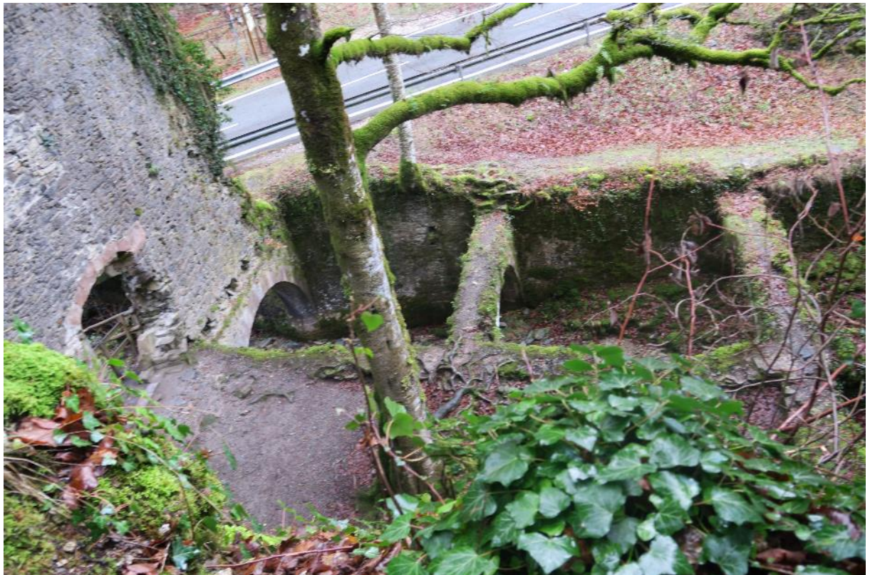
Interior del compartimento norte visto desde una de las bocas de descarga del nivel superior. Puerta de salida del combustible a la izquierda y arcos sobre el cauce del río para apoyar el forjado inferior y ocupar, así, el máximo espacio posible en planta.
