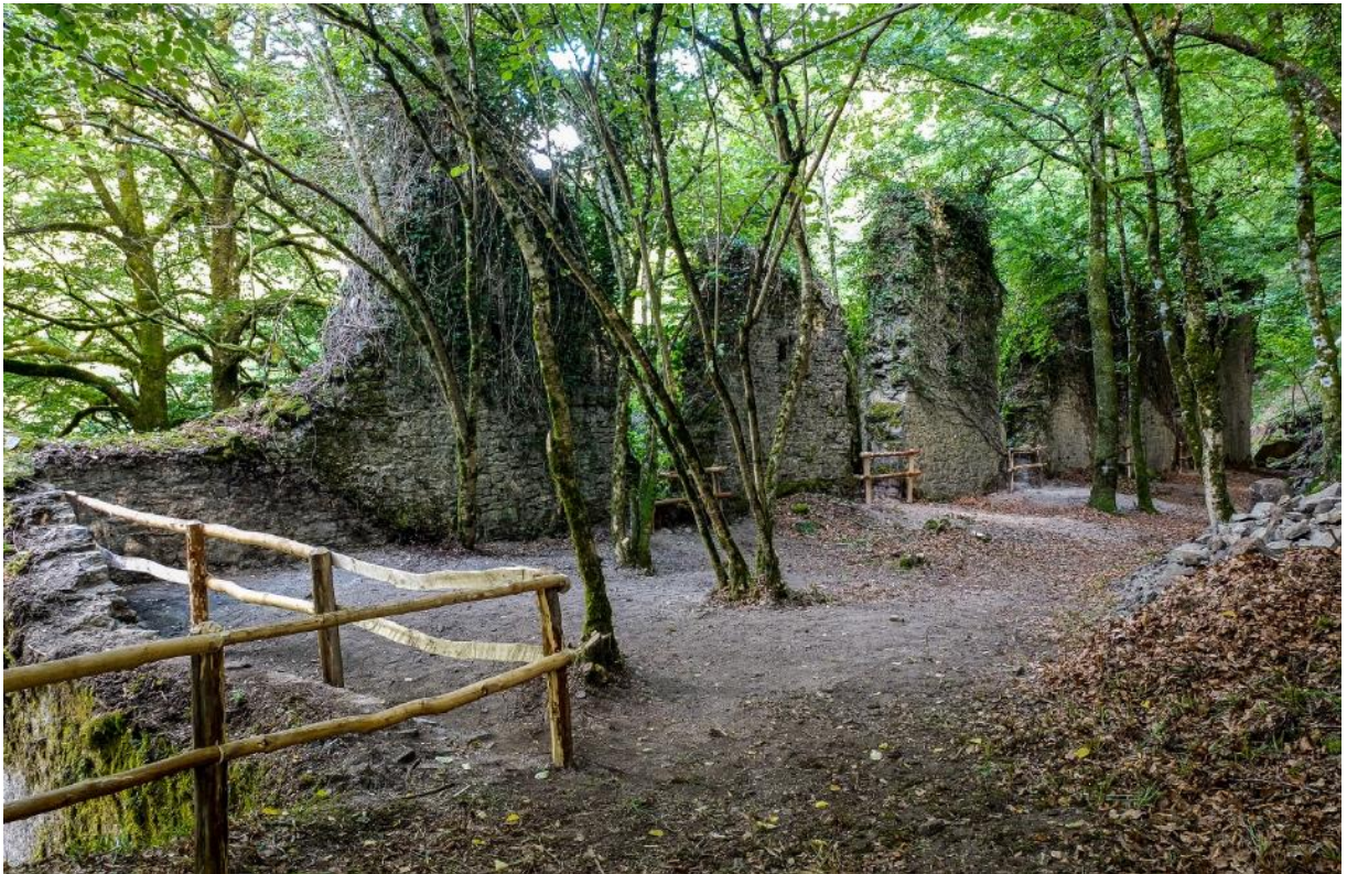
Vista del lienzo suroeste de la carbonera desde el nivel superior recorrido por el Camino Real con las rasgaduras correspondientes a las antiguas bocas de descarga despojadas de las piezas de sillería que conformaban los huecos. Fuente: Goio Seminario
