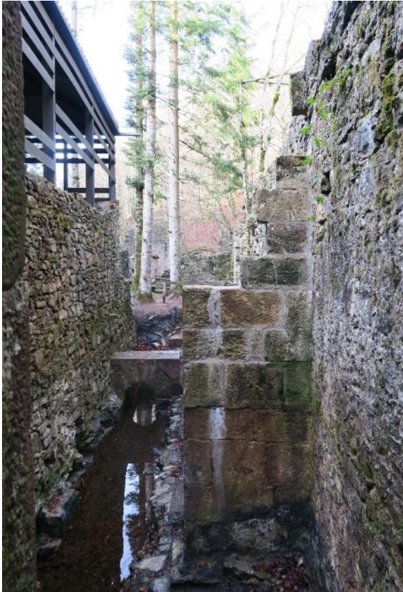
Canal de hornos visto desde lados opuestos a su paso entre el muro de cierre sur de la Carbonera Menor y el edificio de los hornos. Se ven los restos de los contrafuertes mutilados que contrarrestaban los empujes de los arcos sobre el río del edificio de la carbonera.
