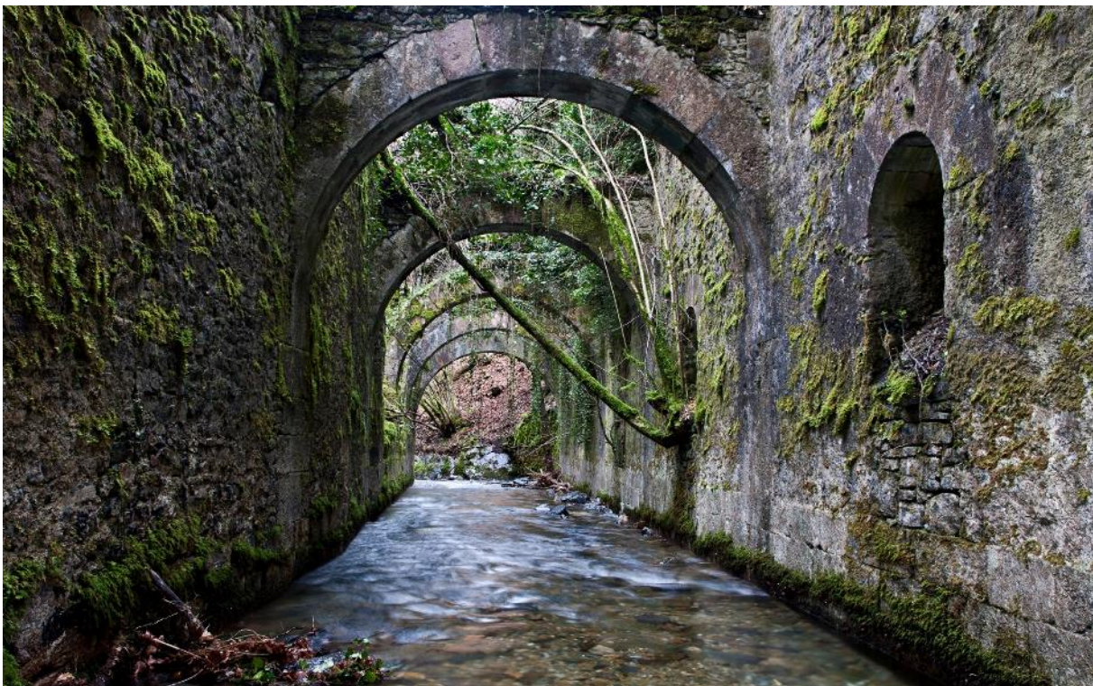
Canalización del río a su paso por el interior de la Carbonera Menor, con la secuencia de arcos diafragma que sujetaban el piso interior del almacén y los huecos de ventilación del espacio situado bajo dicho piso. Fuente: Goio Seminario
