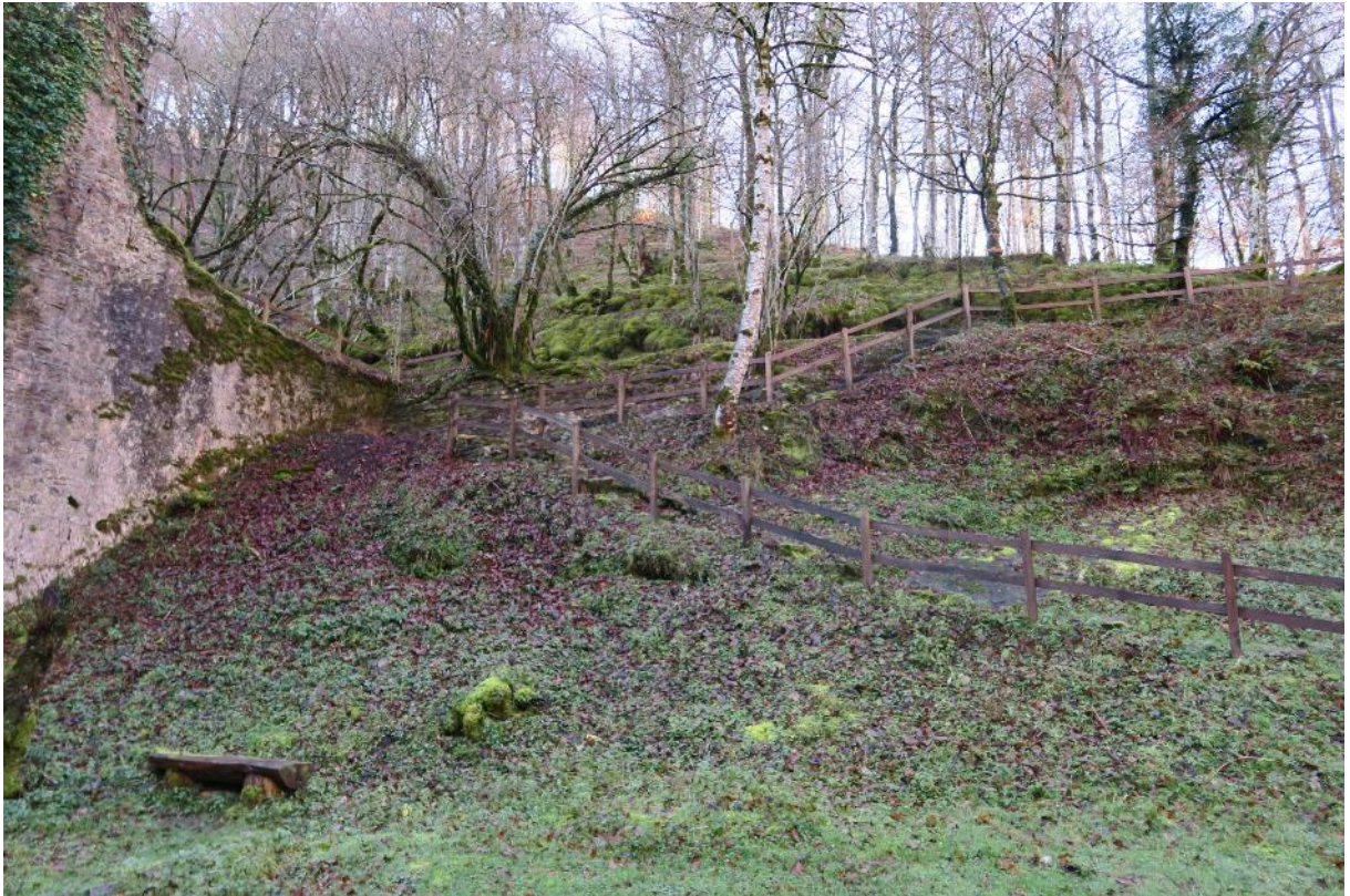
Escalera construida recientemente para comunicar los dos niveles de la carbonera en su frente noroeste
