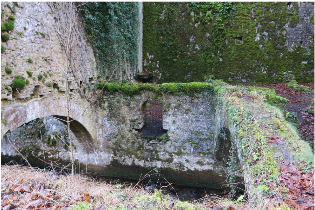
Vista de la canalización del río Arga y los arcos que salvan su luz para apoyar el forjado del piso inferior con el hueco de arco de medio punto en el frente que servía de ventilación al espacio inferior.
