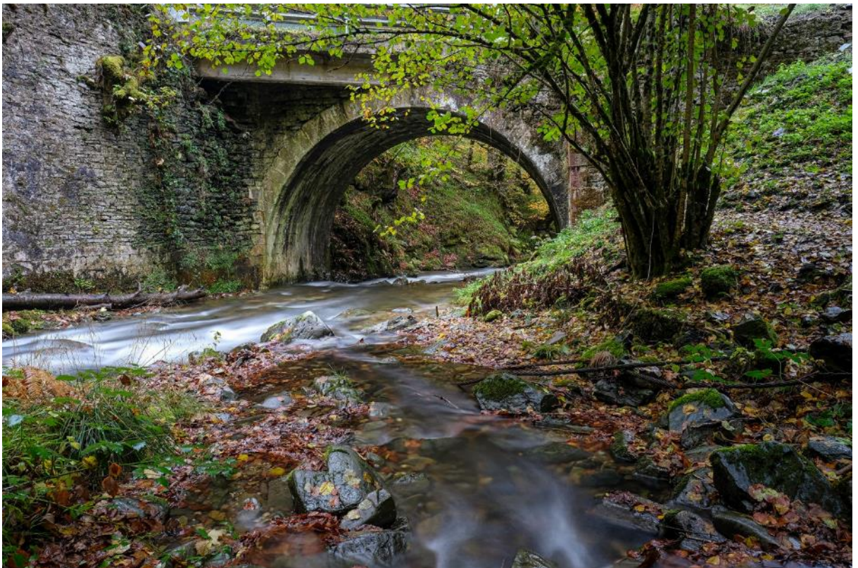
Vista actual del puente que daba paso al Portal de Pamplona, uno de los dos accesos al complejo industrial, sobre el cual se construyó el tablero para el trazado de la carretera en el siglo XX. Fuente: Goio Seminario
