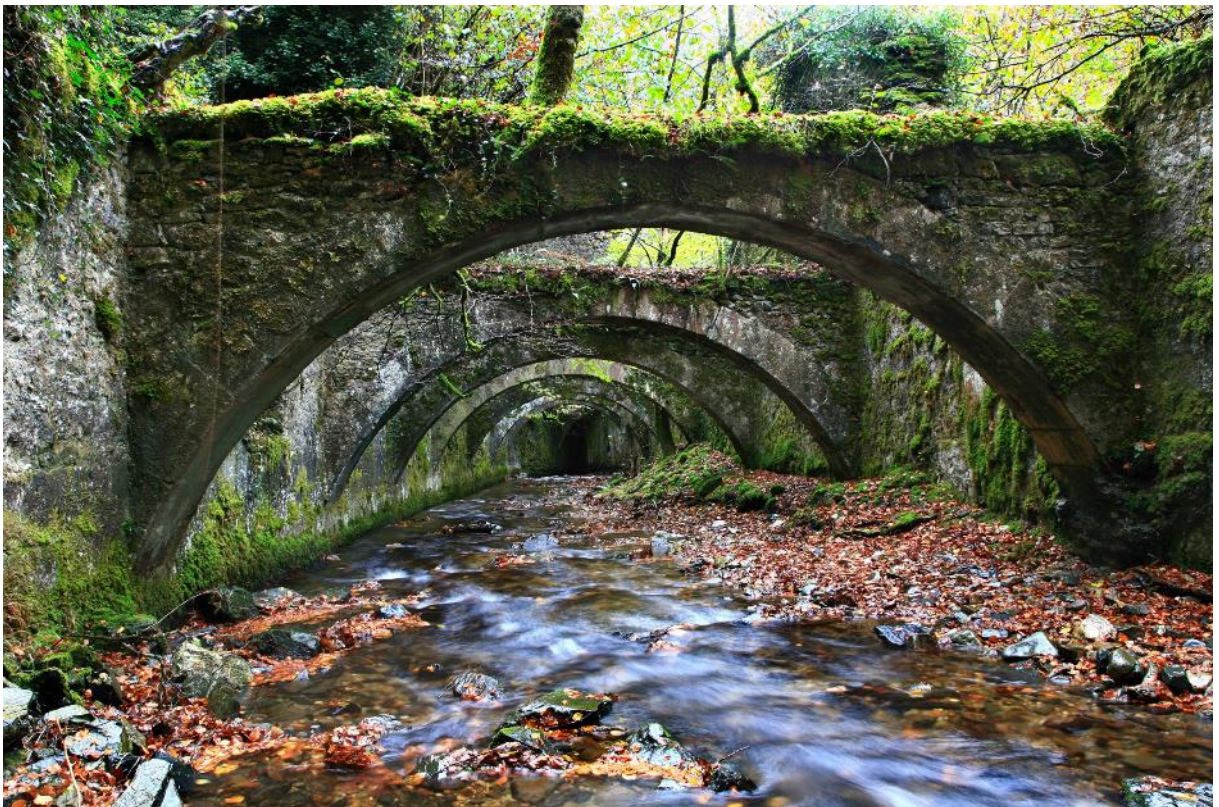
Secuencia de arcos diafragma sobre los que apoyaba la estructura del piso inferior de la carbonera vistos desde el cauce del río. Fuente: Goio Seminario.
