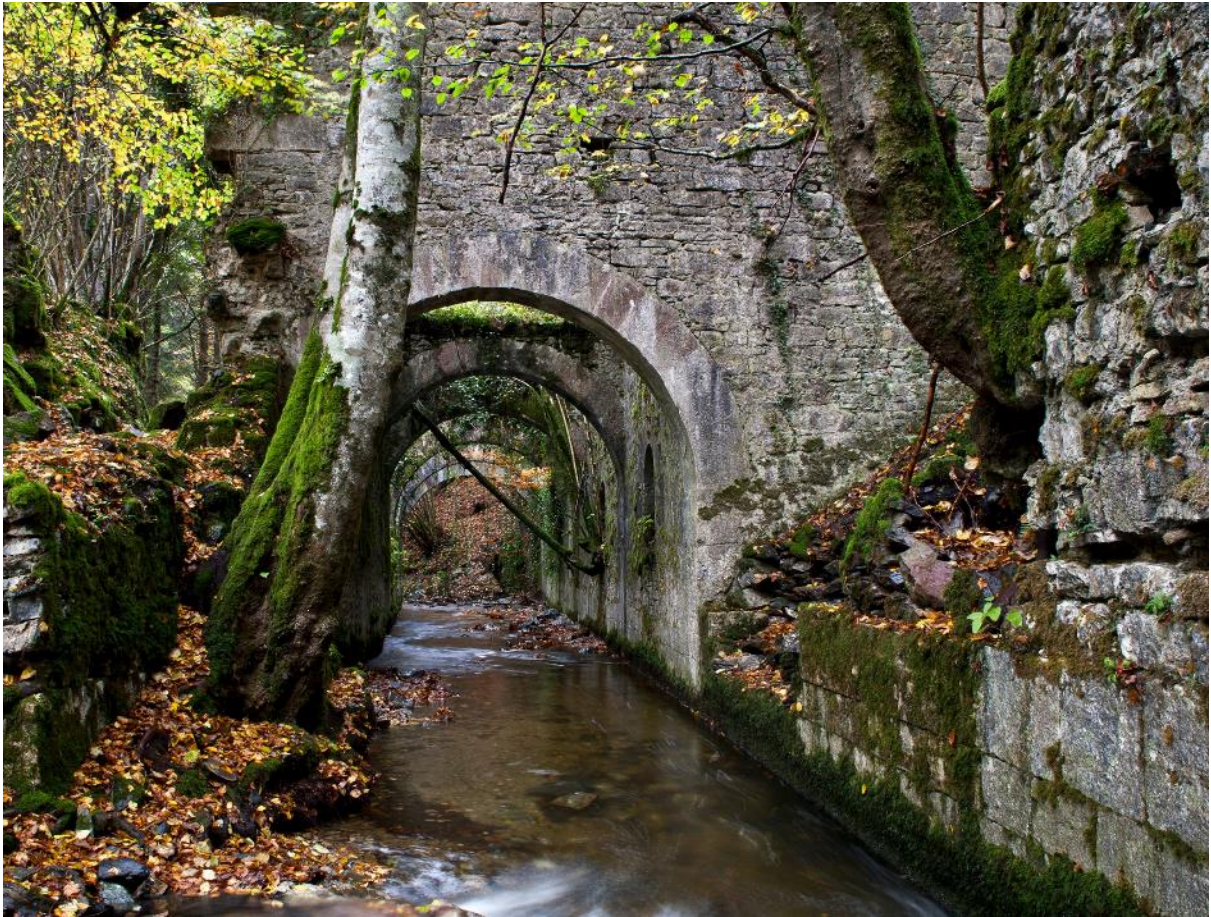
Canalización del río a su entrada bajo el edificio de la Carbonera Menor. Fuente: Goio Seminario
