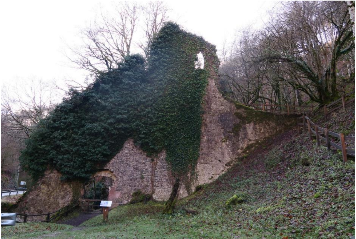
Vista frontal del lienzo noroeste con la salida en la parte inferior por la que se conducía el carbón directamente a los hornos a través de una pasarela.
