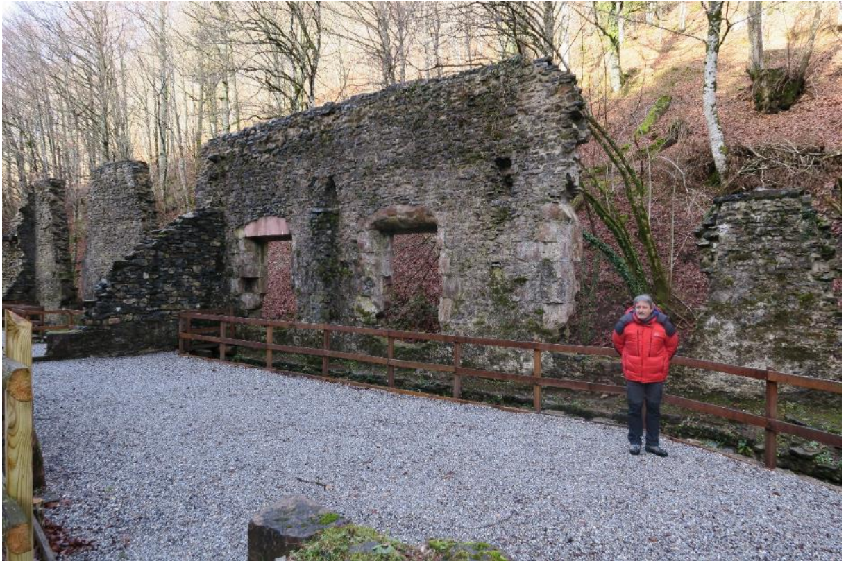
Restos del taller de limpieza y reconocimiento de municiones por cuyo interior discurre el canal de hornos y que conserva gran parte del muro exterior de cierre hacia el río con grandes vanos de ventilación e iluminación.
