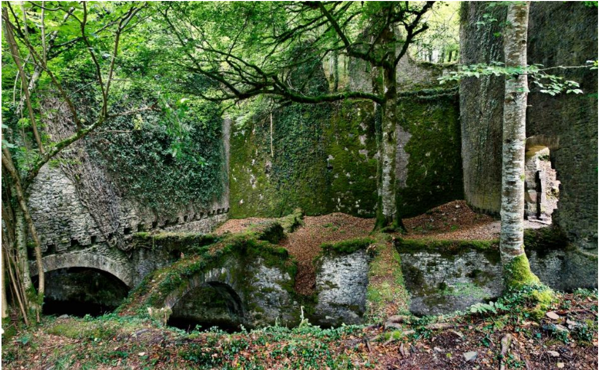
Interior del compartimento norte visto desde la calle inferior. Se aprecian los mechinales para el empotramiento del forjado del piso inferior que se extendería sobre los arcos que salvan la luz del cauce del río. Fuente: Goio Seminario.
