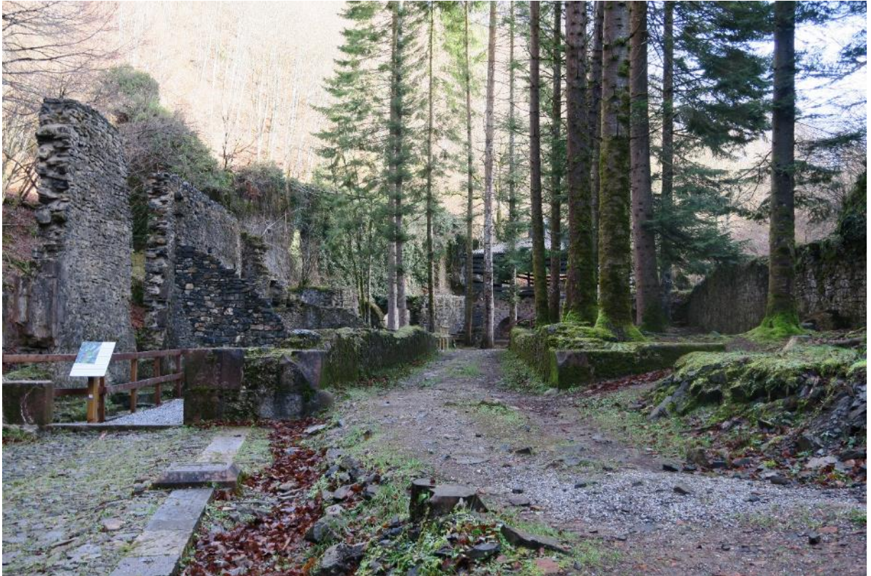
Fotografía tomada desde el patio del edificio del palacio frontalmente al corredor que separaba los talleres de limpieza y reconocimiento de municiones y de refinería de tierras y que daba paso al fondo al edificio de hornos.
