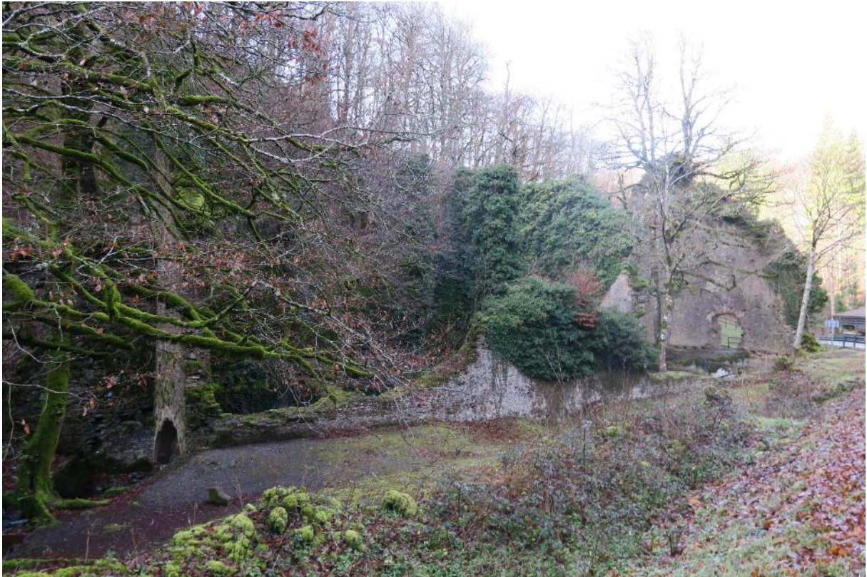
Vista general del edificio de la Carbonera Mayor desde el borde de la carretera que cruza el yacimiento.
