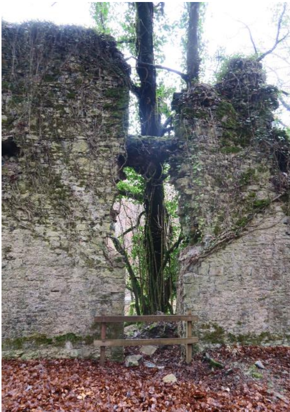
Izda.: Fotografía de una de las bocas de descarga a la que han expoliado las piezas de sillería que conformaban el hueco. Dcha.: Interior del compartimento sur visto desde la puerta de acceso al nivel superior situada en el lienzo sureste. Se ve el espacio interior colonizado completamente por la vegetación, incluso los dos esbeltos pilares centrales.
