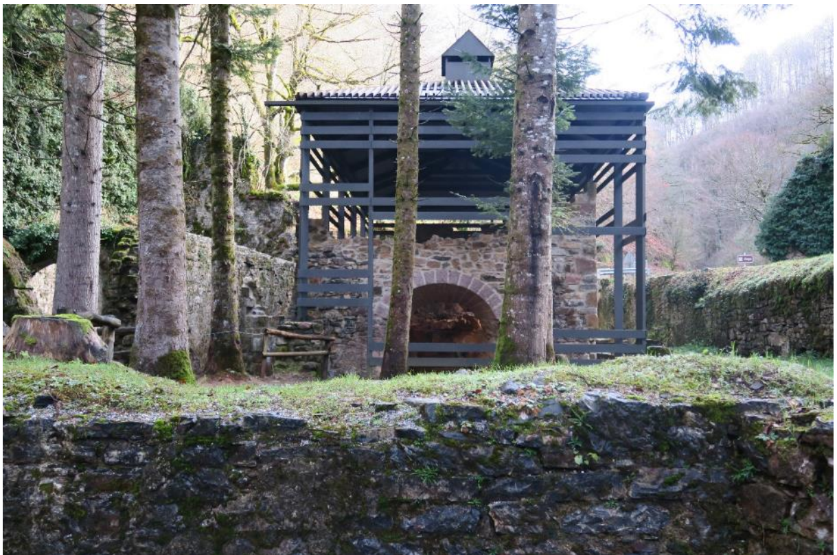
Muro de cierre del taller de moldería situado frente a los hornos, que hace de límite y contención al relleno sobre el que se construyó en el siglo XX la carretera que atraviesa la fábrica. Al fondo se ven los muros que se conservan de otros talleres.
