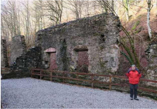
Izda.: Muro de cierre hacia el río de los talleres junto al edificio de hornos. Los grandes vanos abiertos en la fábrica de mampostería están resueltos con sillares de piedra roja de Baztán. Dcha.: Muro de cerramiento del taller de moltería que actualmente sirve de contención a la base de la carretera. Se aprecian las piezas que conformaban el derrame de uno de los huecos.
