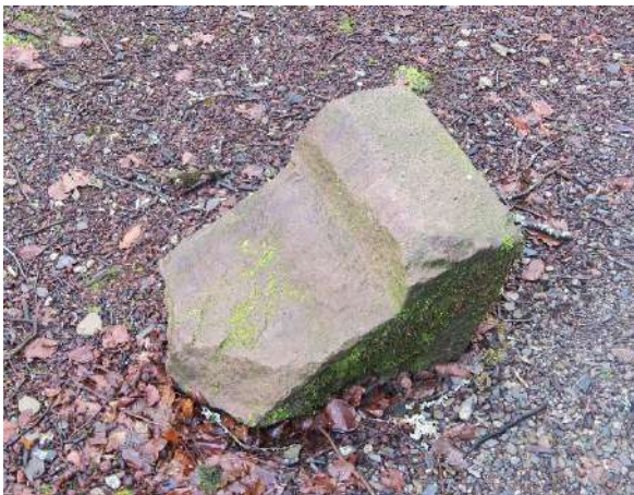
Izda.: Sillar correspondiente a una mocheta de un hueco de piedra roja de Baztán. Dcha.: Sillar de piedra dolomita.
