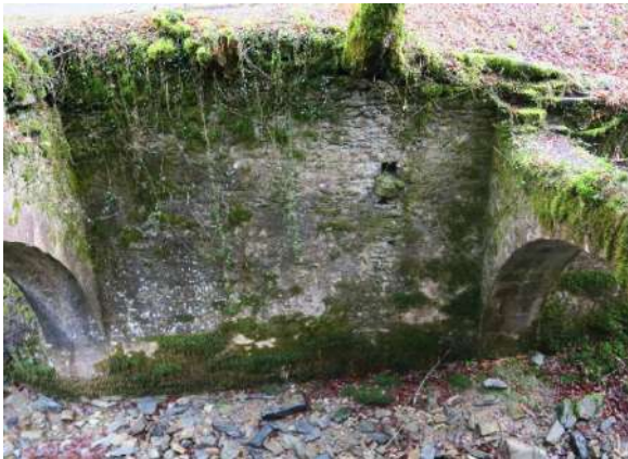
Canalización del Arga a su paso por el interior de la Carbonera Mayor. Fotografías de ambos lados del canal en las que se ven los arcos para el apoyo del forjado interior del almacén y los huecos para desagüe (izda.) y ventilación (dcha.)
