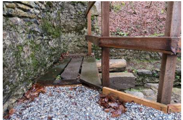
Izda.: Conexión intermedia del canal de hornos con el cauce del río con elementos tallados para la colocación de una compuerta reguladora del paso de agua. Dcha.: Reproducción a modo de ejemplo de la pasarela de madera que cubriría el canal.
