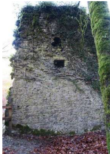
Izda.: Ejemplo de boca de descarga despojada de las piezas de sillería que formaban las mochetas y el dintel. Centro: Ejemplo de mechinales donde se alojaban las vigas de la estructura del porche de la zona de descarga. Dcha.: Elemento de piedra tallado que protegía las esquinas de los golpes con las ruedas de las carretas que transportaban las materias primas.
