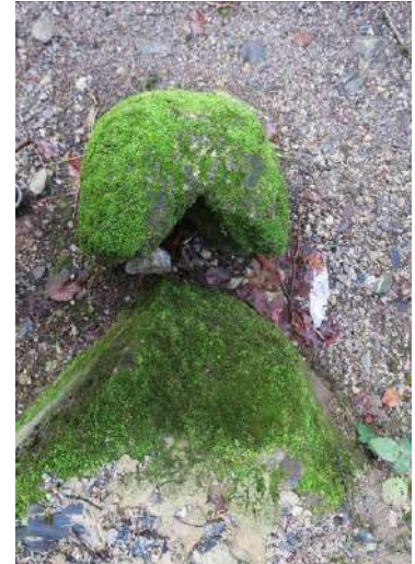
Izda.: Ejemplo de boca de descarga despojada de las piezas de sillería que formaban las mochetas y el dintel. Centro: Ejemplo de mechinales donde se alojaban las vigas de la estructura del porche de la zona de descarga. Dcha.: Elemento de piedra tallado que protegía las esquinas de los golpes con las ruedas de las carretas que transportaban las materias primas.
