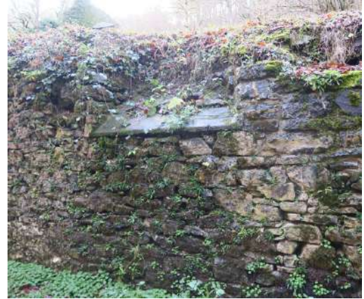
Izda.: Muro de cierre hacia el río de los talleres junto al edificio de hornos. Los grandes vanos abiertos en la fábrica de mampostería están resueltos con sillares de piedra roja de Baztán. Dcha.: Muro de cerramiento del taller de moltería que actualmente sirve de contención a la base de la carretera. Se aprecian las piezas que conformaban el derrame de uno de los huecos.
