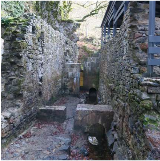
Izda.: Canal de hornos a su paso entre los hornos de fundición y la carbonera menor. Dcha.: salida del agua de canal de hornos hacia el río Arga.
