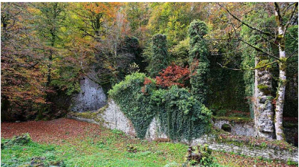
Fotografía del compartimento sureste con los dos esbeltos pilares cubiertos de vegetación en el interior y la parte que se conserva del cierre exterior en primer término. Fuente: Goio Seminario.
