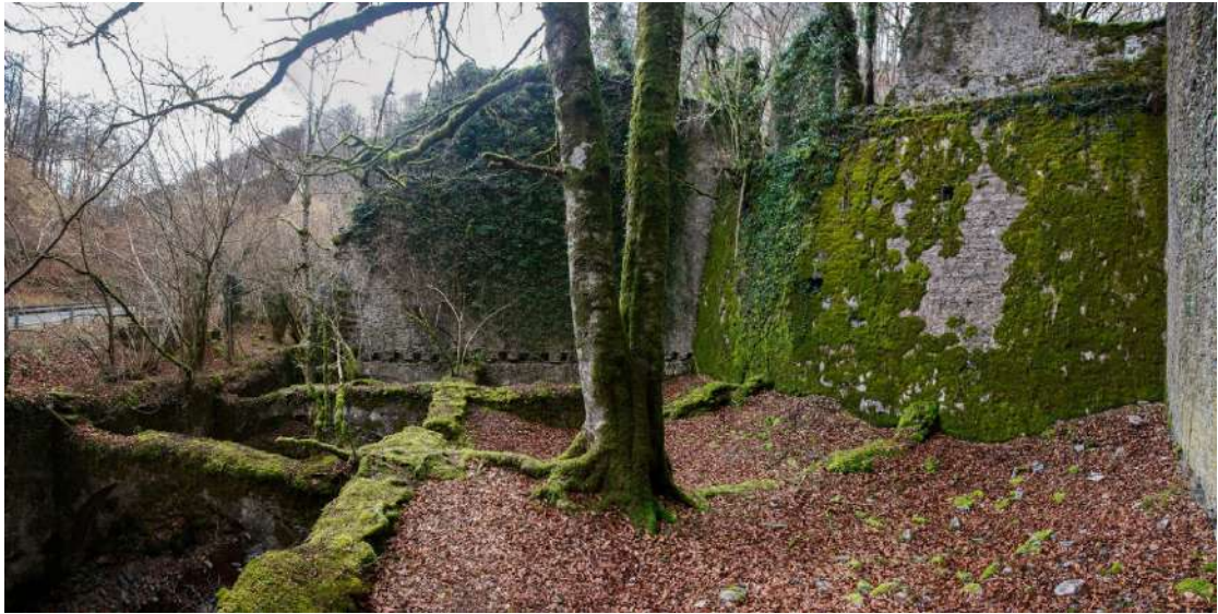
Fotografía del interior del compartimento noroeste de la Carbonera Mayor
