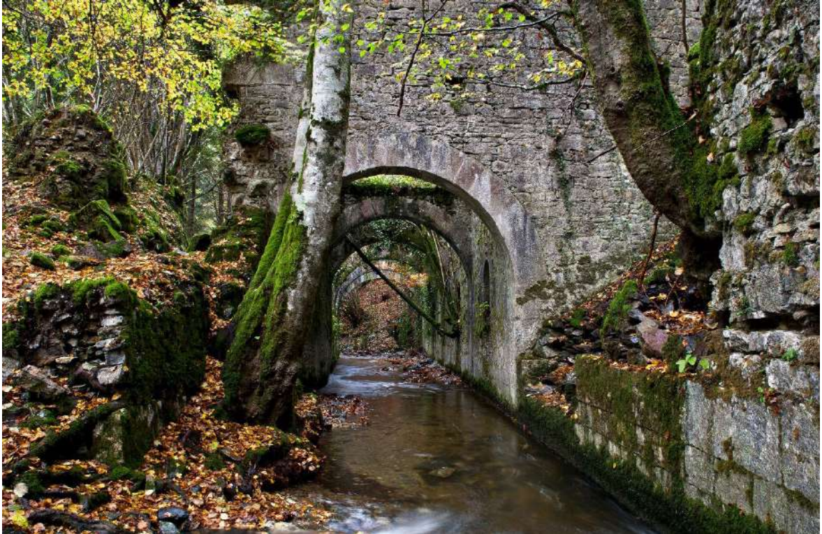
Fotografía tomada desde el cauce de la canalización a su entrada a la Carbonera Menor. A la izquierda de la imagen se aprecia la diferencia entre la parte baja del muro, ejecutada con sillería, y la parte alta, realizada con mampostería.
