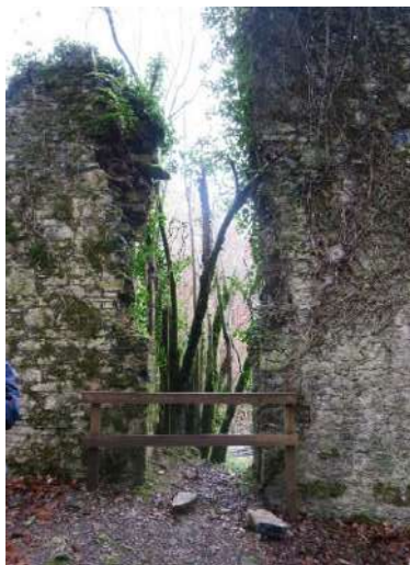
Izda.: Ejemplo de boca de descarga despojada de las piezas de sillería que formaban las mochetas y el dintel. Centro: Ejemplo de mechinales donde se alojaban las vigas de la estructura del porche de la zona de descarga. Dcha.: Elemento de piedra tallado que protegía las esquinas de los golpes con las ruedas de las carretas que transportaban las materias primas.
