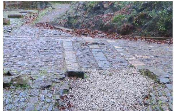
Izda.: Formación del Camino Real mediante el desmontado de la roca natural. Dcha.: Detalle del pavimento a base de cantos rodados y encintado de piedra en el acceso y plaza interior del edificio del palacio.
