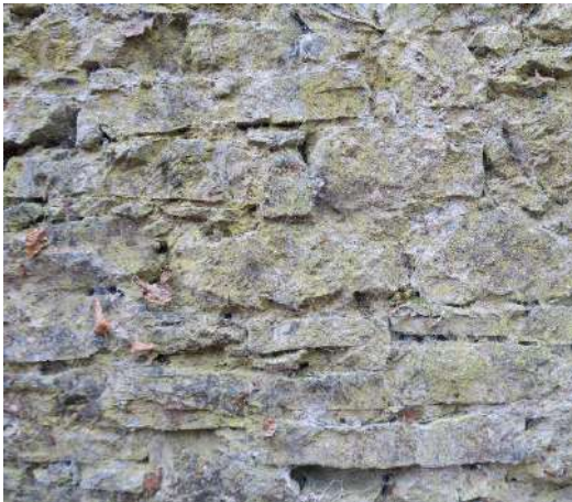
Izda.: detalle de la fábrica de mampostería realizada con encofrado del muro sur de la carbonera mayor; dcha.: puerta inferior de acceso a la carbonera con sillares de piedra roja de Baztán en mochetas y dovelas del arco.
