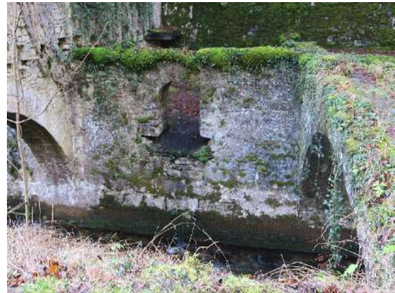
Canalización del Arga a su paso por el interior de la Carbonera Mayor. Fotografías de ambos lados del canal en las que se ven los arcos para el apoyo del forjado interior del almacén y los huecos para desagüe (izda.) y ventilación (dcha.)
