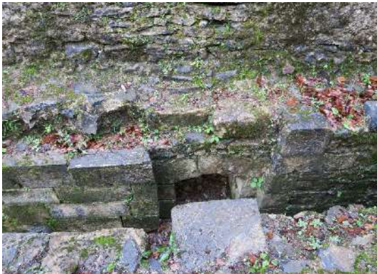
Izda.: Conexión intermedia del canal de hornos con el cauce del río con elementos tallados para la colocación de una compuerta reguladora del paso de agua. Dcha.: Reproducción a modo de ejemplo de la pasarela de madera que cubriría el canal.
