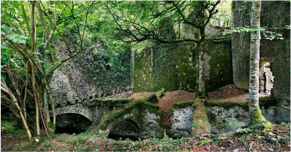
Fotografía del compartimento noroeste con el muro que divide los dos espacios a la izquierda, el cerramiento exterior lateral a la derecha, el muro de contención ataluzado en el frente y los arcos sobre el canal en la parte inferior. Fuente: Goio Seminario.
