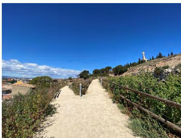
VARIAS VISTAS DE LOS CAMINOS EJECUTADOS (SECTOR 1 Y 2 DE PARQUE ARQUEOLÓGICO)
