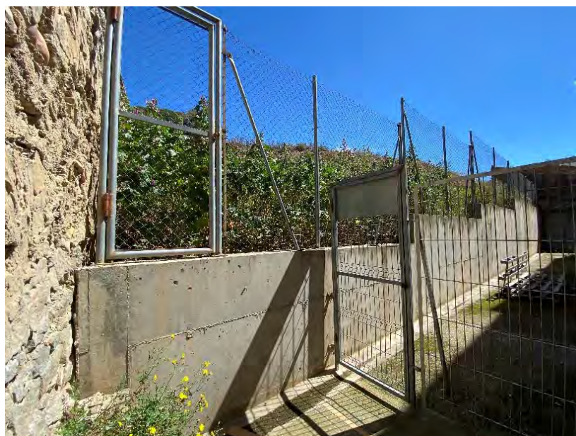
VISTA DEL INTRADOS DEL MURO Y VALLADO TRASERA N°38BIS Y N°38, ASÍ COMO DE CAZ Y SUMIDERO EXISTENTES
