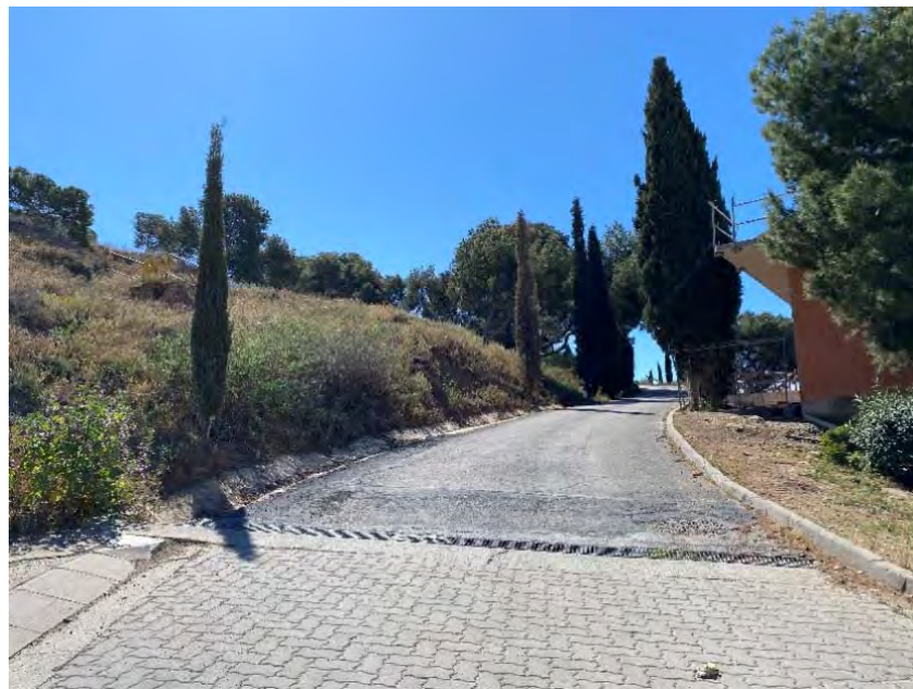
ZONA FINAL DE CUNETA "C" (CONEXIÓN A REJILLA) PROPUESTA PARA RECOGIDA DE CUENCAS VERTIENTES A CAMINO DE SUBIDA AL MONUMENTO DEL CORAZÓN DE JESÚS. VISTA DESDE AGUAS ABAJO
