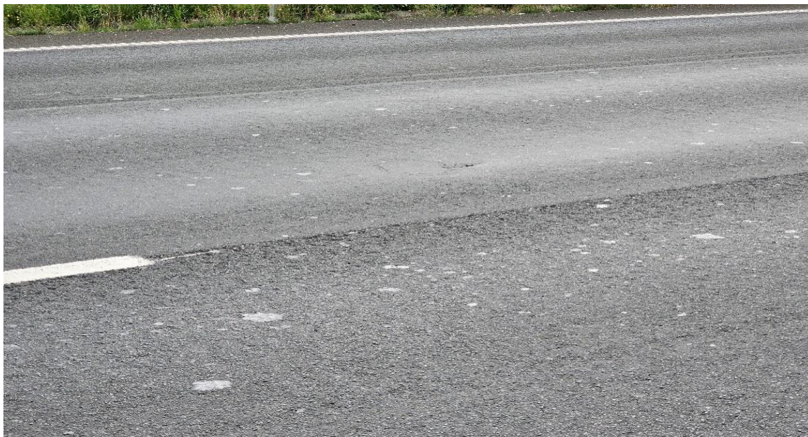
Aspecto del tramo entre el pk 81+300 y 80+400 sur, zona 3 carriles
