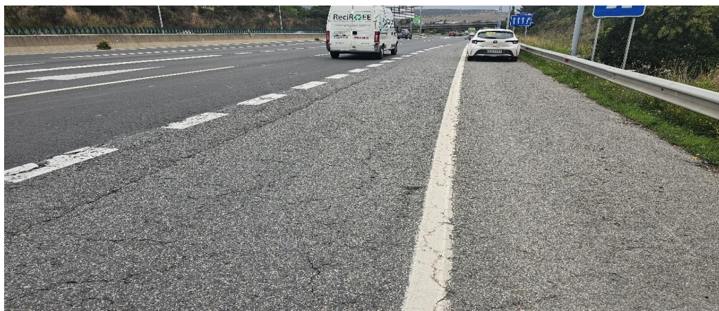
Aspecto del tramo entre el pk 83+300 y 83+000 sur, zona 4 carriles
