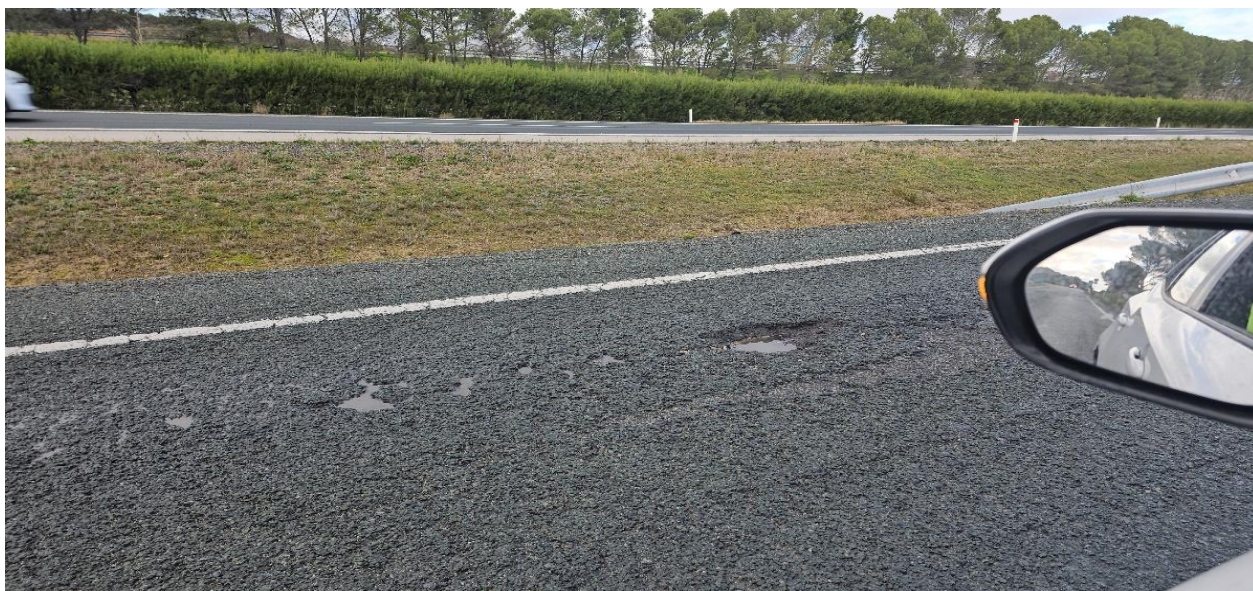
Aspecto del pavimento en el acceso al área descanso de Olite
