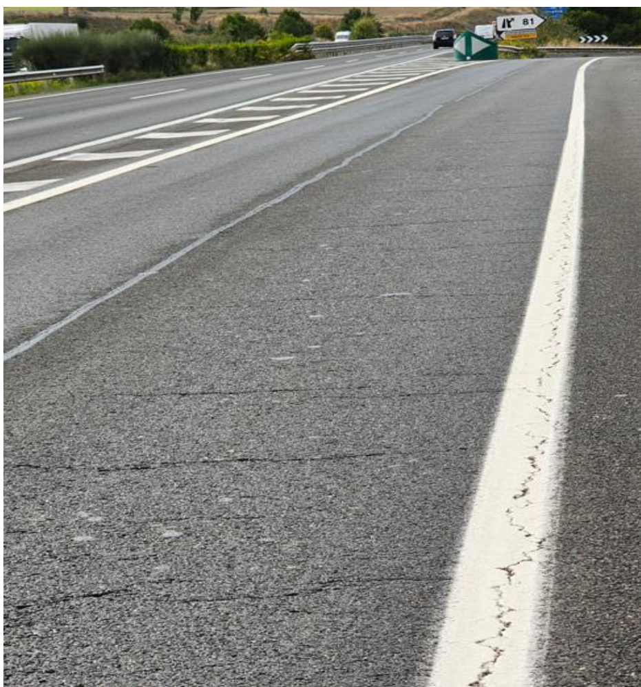
Aspecto del tramo entre el pk 80+600 y 80+400 sur, salida 81
